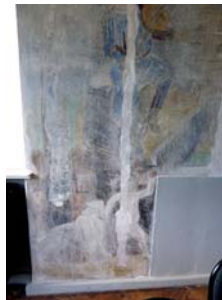
Kat. Nr. 60.4 • Raumansicht, Wandabschnitt A unten, 2015 • Foto: Verfasserin
