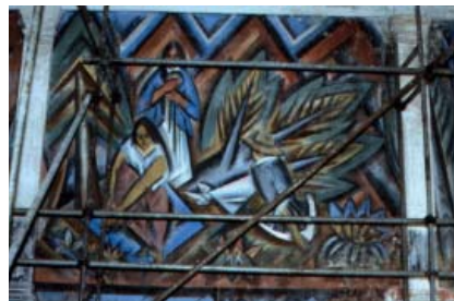
Kat. Nr. 1.5 • Teilansicht Wandbild „Menschen im Glück“, Sanierungsarbeiten 1990er Jahre • Foto: Lindenau-Museum
