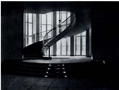
Kat. Nr. 6.2 • Berlin, Haus des Deutschen Metallarbeiter-Verbandes: Raumansicht Eingangs- bereich/Treppenhaus, ca. 1930 • Abb. aus AUSST. KAT. RECKLINGHAUSEN 1989, s.p.
