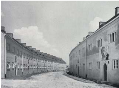
Kat. Nr. 139.1 • Straßenansicht Stürzerstraße, um 1930 • Abb. entnommen aus: BAUKUNST MÜNCHEN 1930 , S. 174
