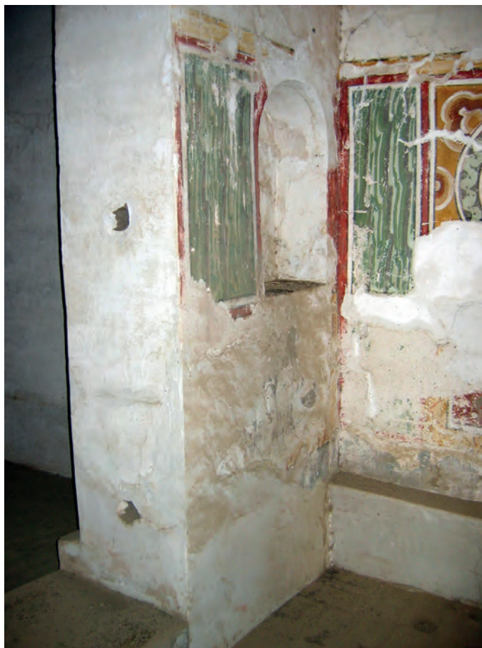
Abb. 16: GB 12, Obergeschoss, 1. Raum, westliche Südwand; 2006
