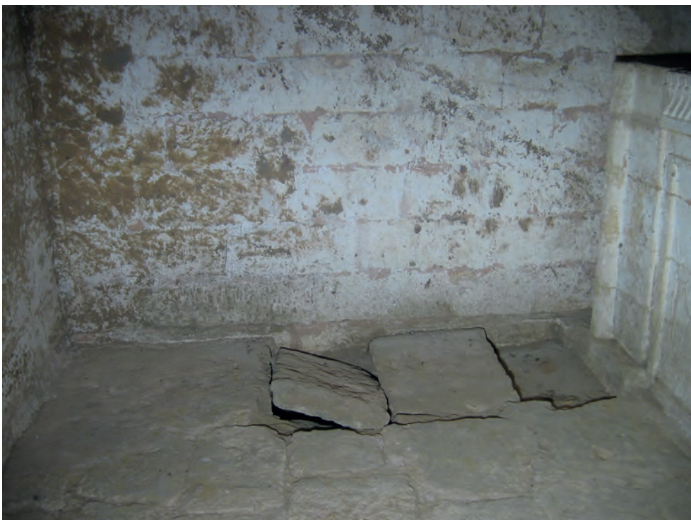
Abb. 15: GB 15, Innenraum, Ostseite mit Estrichresten und Grabgrube; 2007
