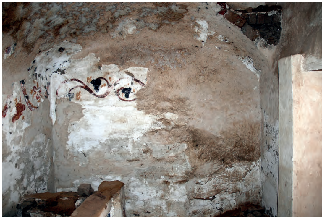
Abb. 14: Erdgeschoss, 2. Raum, Ostwand; 2008
