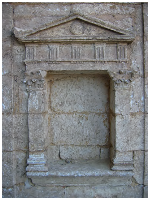
Abb. 9: GB 15, östliche Fassadennische; 2007
