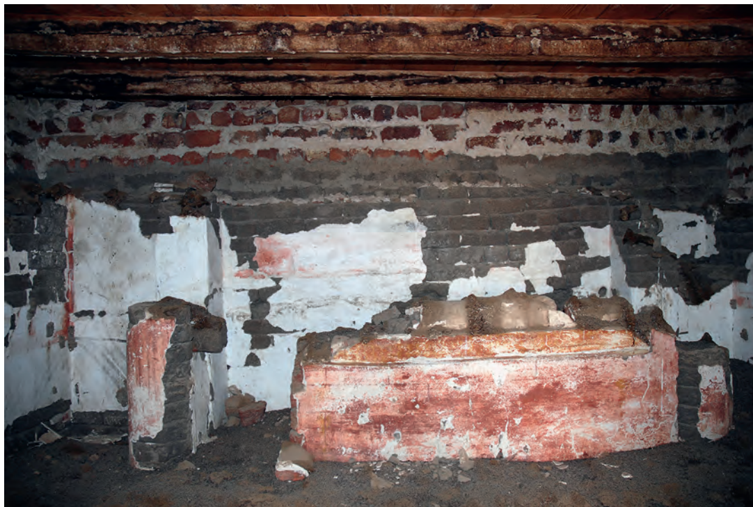
Abb. 19: Obergeschoss, 2. Raum, Nordwand; 2008
