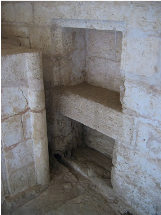
Abb. 16: GB 15, Innenraum, Westseite mit zwei übereinanderliegenden Nischen; 2007
