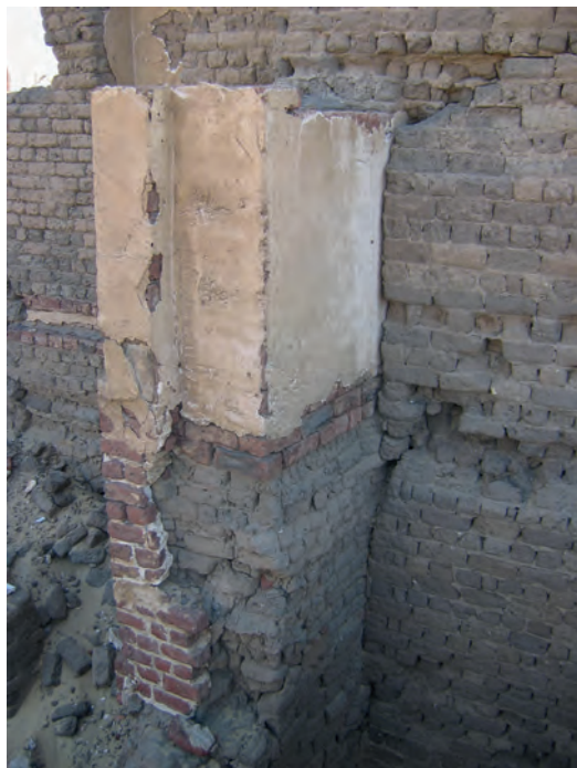
Abb. 4: Doppelstöckige Lehmziegelmauer vor dem Podium von GB 15; 2007
