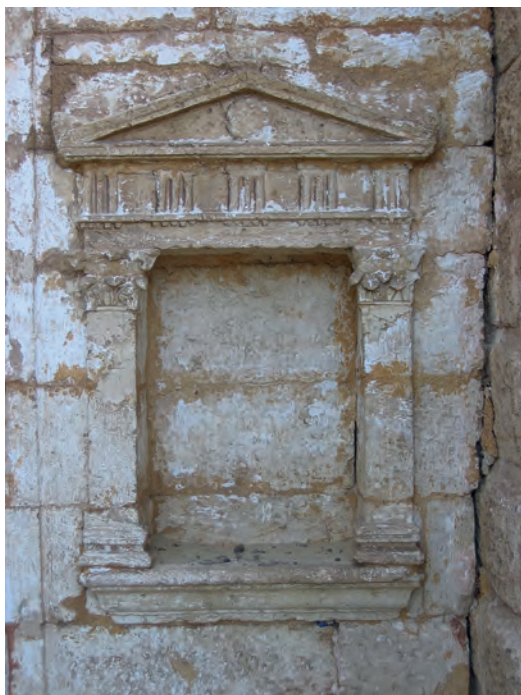
Abb. 8: GB 15, westliche Fassadennische; 2007
