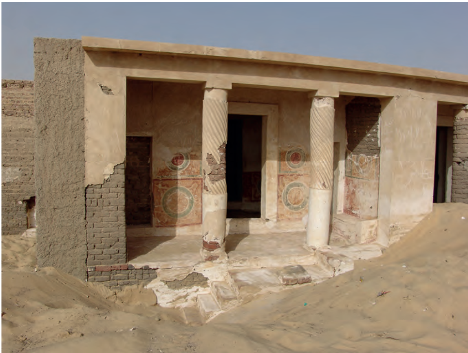
Abb. 7 a: Vorhalle GB 6.2.1; 2007
