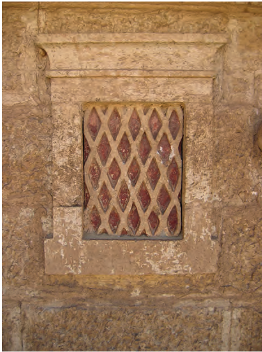
Abb. 6: Fassade, östliches Fenster; 2006
