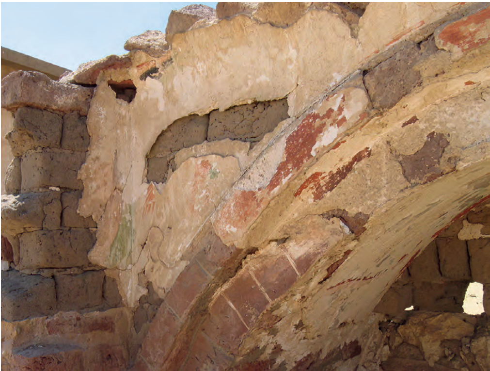
Abb. 21: Südliches Arkosol, südlicher Bogenzwinkel; 2005
