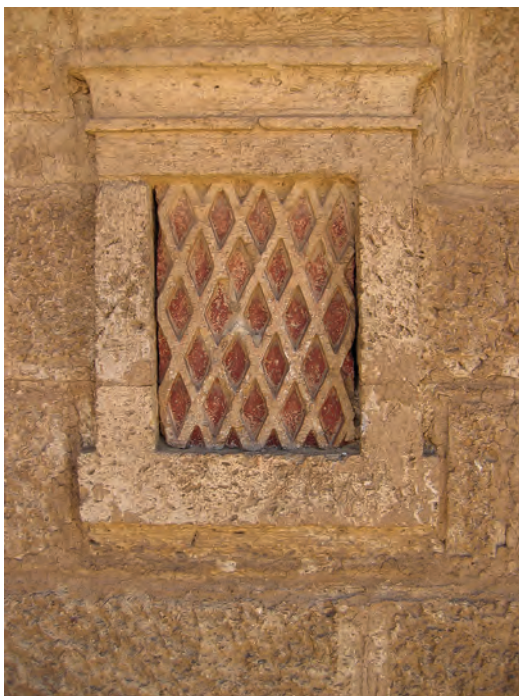
Abb. 8: Fassade, westliches Fenster; 2006
