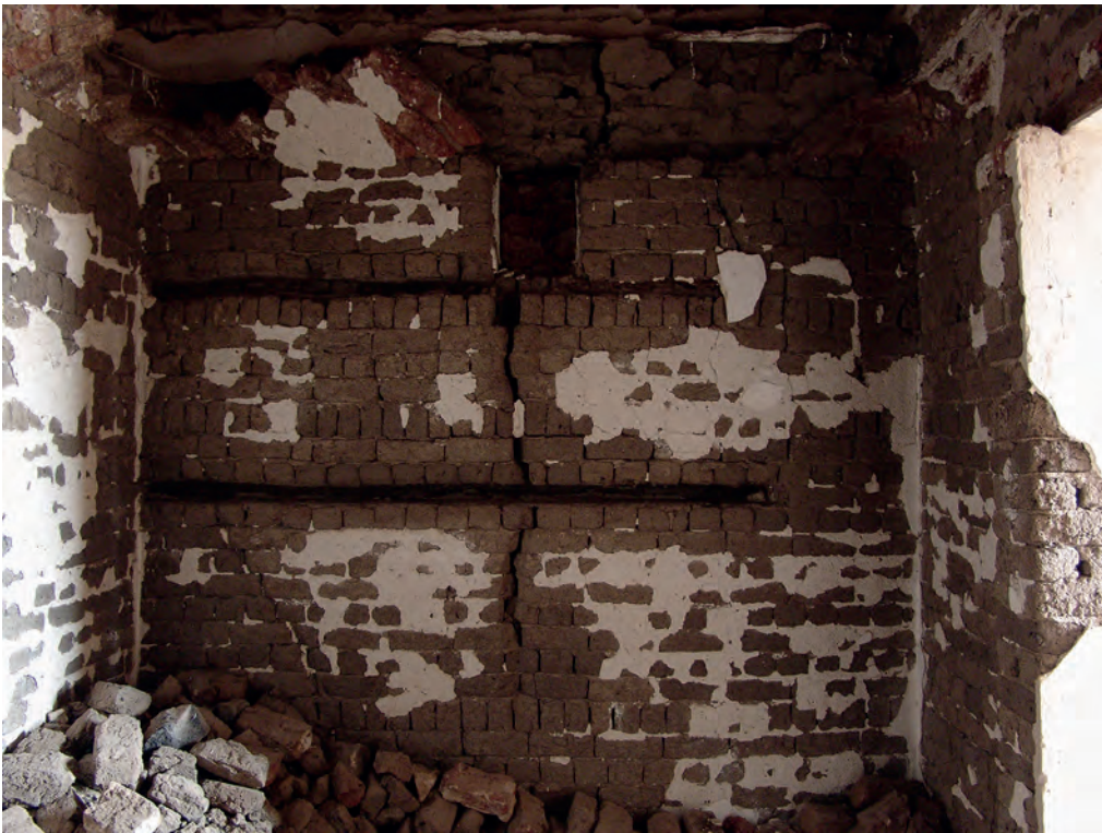
Abb. 26: Raum GB 7.2.3, Holzbewehrung in der Nordwand; 2006
