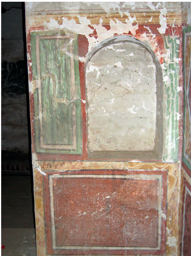
Abb. 9: GB 13, Obergeschoss, 1. Raum, westliche Südwand; 2006
