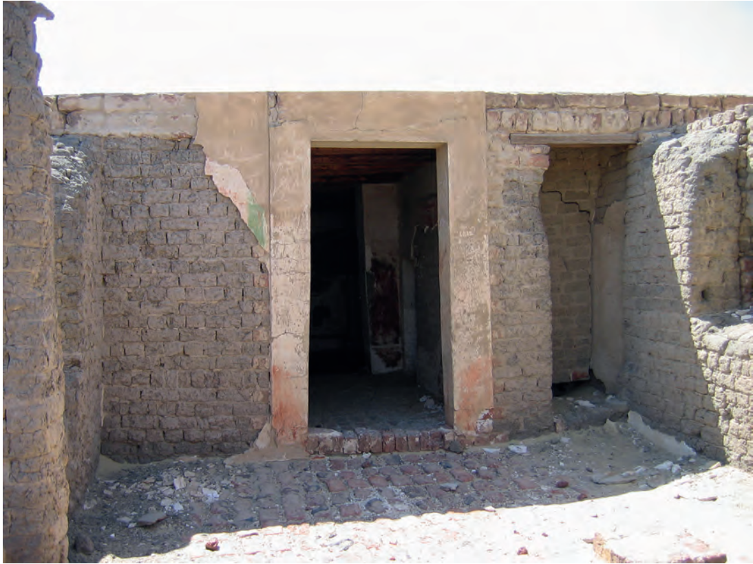
Abb. 1: GB 16, Ansicht des Obergeschosses mit Vorhalle; 2005
