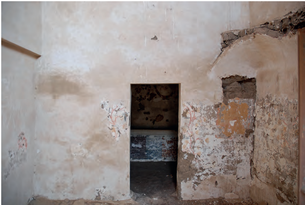
Abb. 21: Erdgeschoss, 1. Raum, Nordwand; 2008
