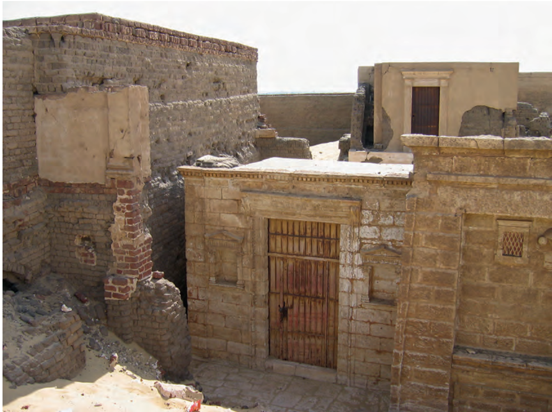
Abb. 1: GB 15, Fassade nach erneuter Freilegung; 2007
