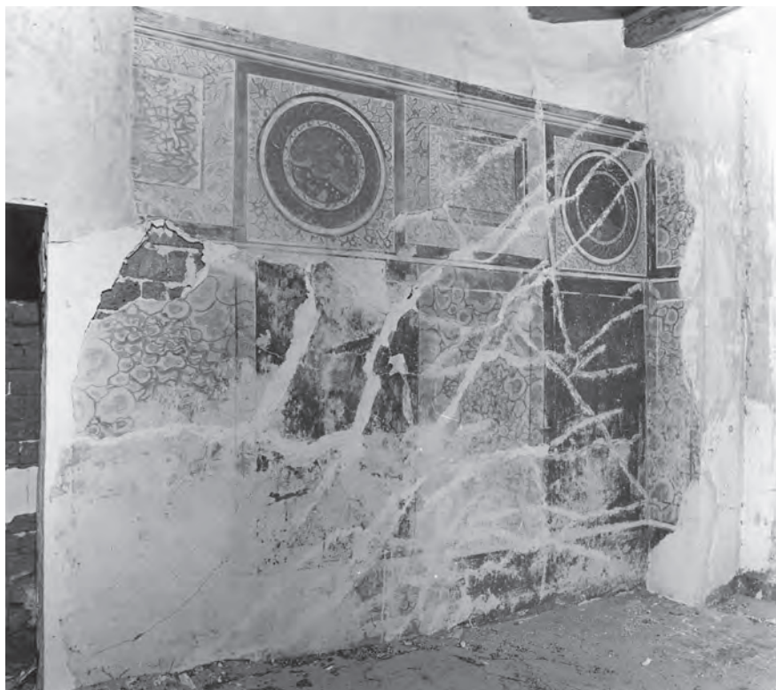
Abb. 3: GB 16, Obergeschoss, erster Raum, Westwand; 1973
