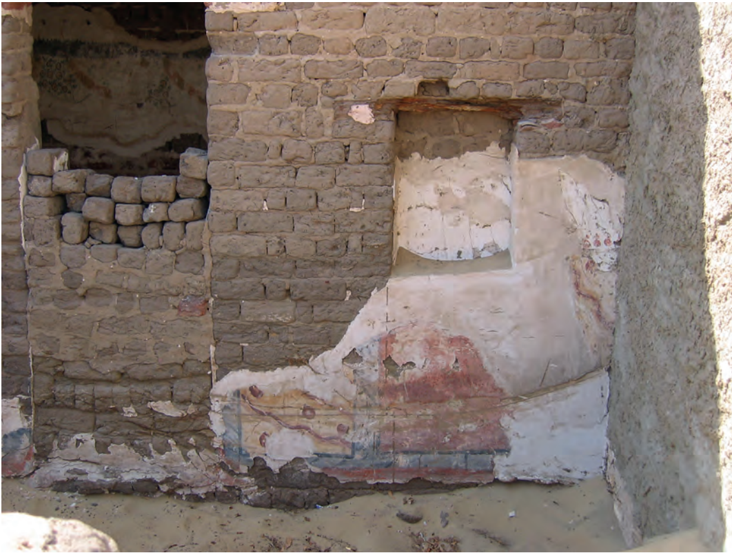
Abb. 22: Raum GB 5.2.1, Westwand mit Resten von Wandmalerei; 2006
