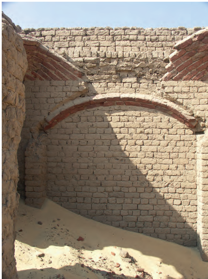
Abb. 12: GB 200.2.2, Westwand, Grablege mit Baldachinkonstruktion in Raum; 2010
