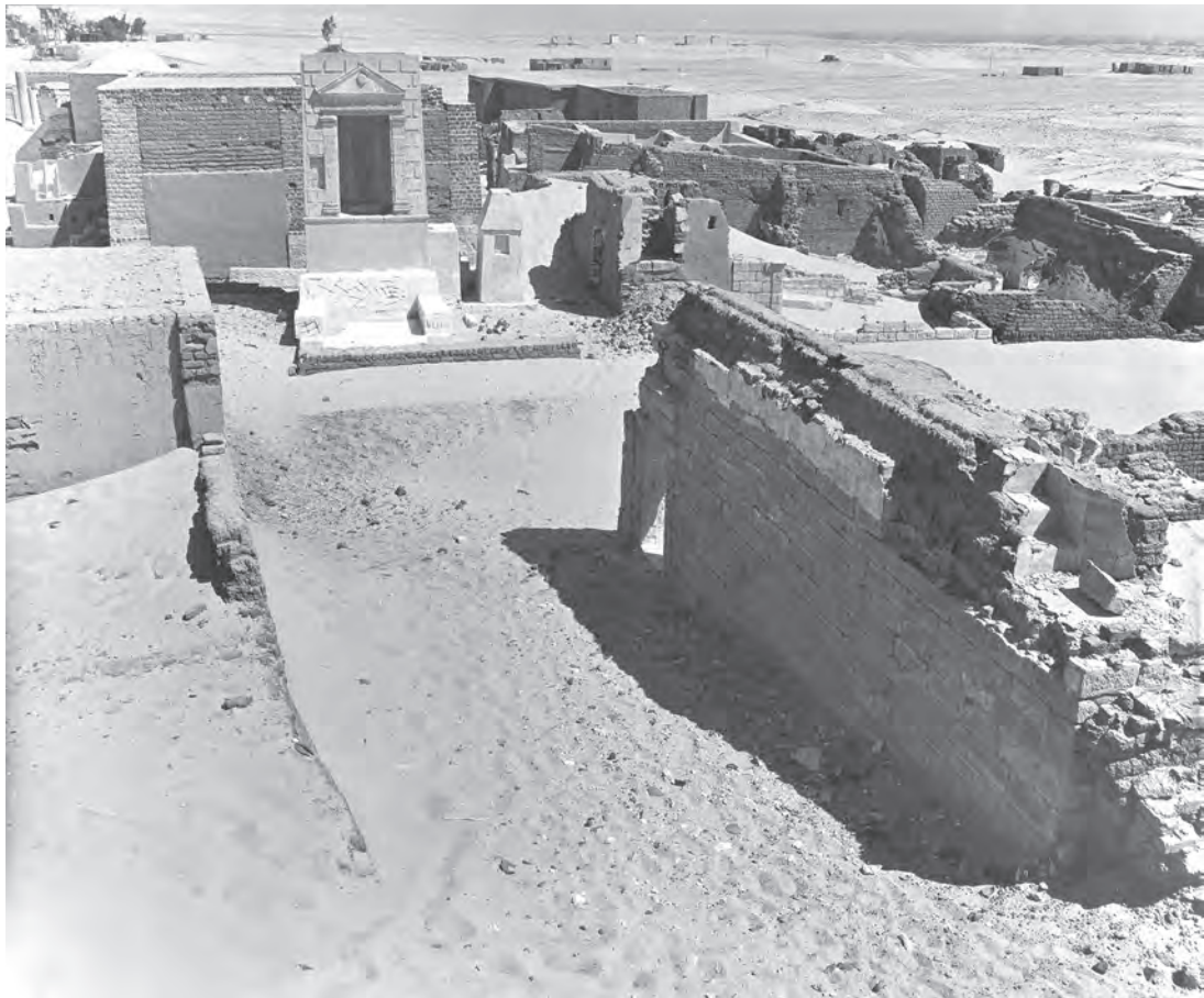
Abb. 23: Westfassade von Südwesten; 1973
