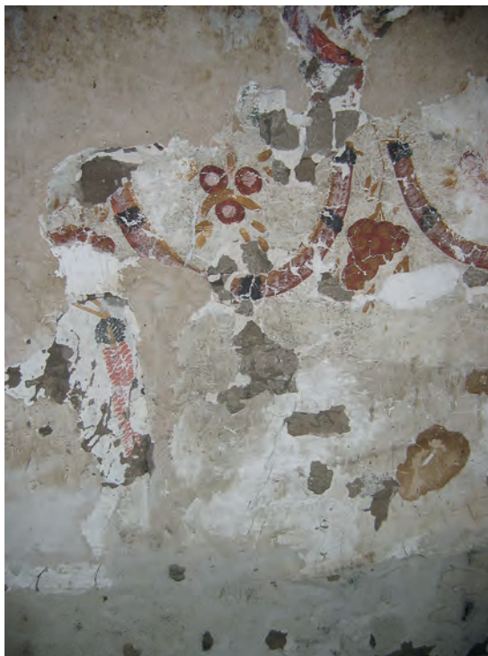
Abb. 23: Erdgeschoss, 2. Raum, Detail Nordwand; 2005
