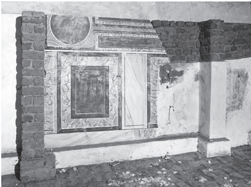
Abb. 46: GB 16, Obergeschoss, zweiter Raum, Südwand; 1973
