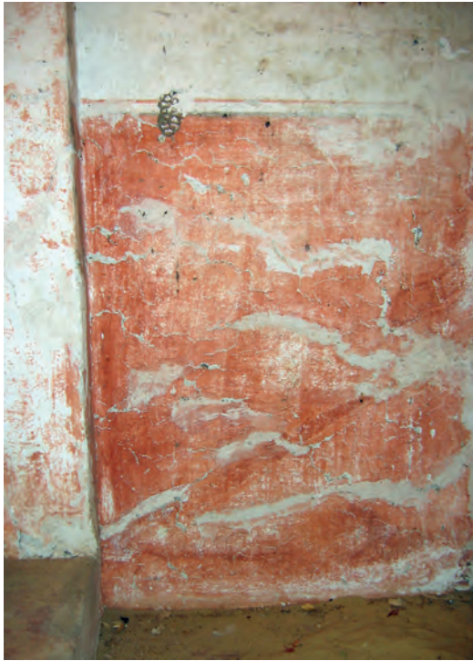
Abb. 23: GB 11, Untergeschoss, Eingangsbereich, Westwand; 2007
