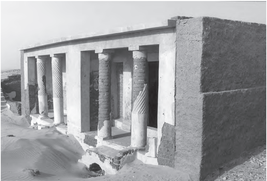
Abb. 5: Ansicht der Vorhallen von GB 6-7, Blick nach Südwesten; 1987
