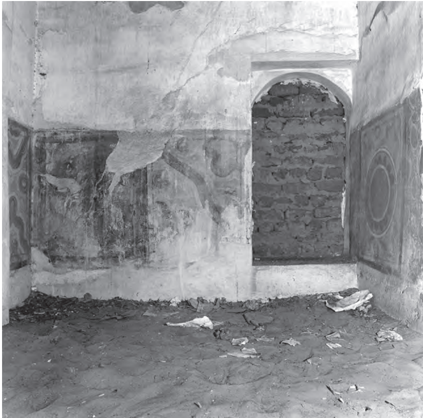
Abb. 24: Südseite von Raum GB 6.2.2; 1987
