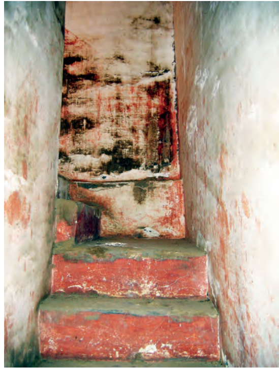
Abb. 24: GB 11, Untergeschoss, Treppe zum Obergeschoss; 2007
