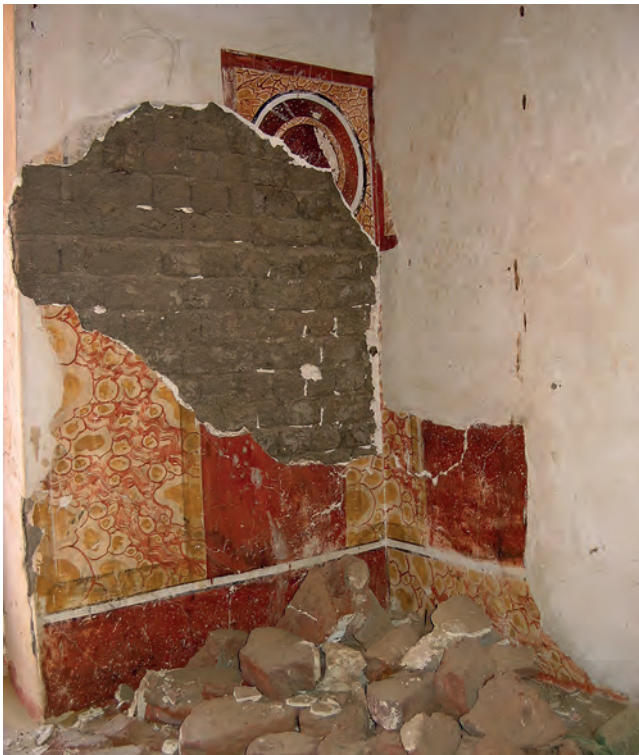
Abb. 33: GB 16, Obergeschoss, erster Raum, Nordostwand; 2005
