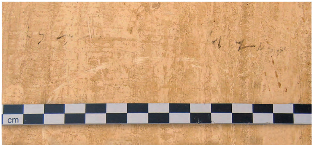
Abb. 29: Raum GB 6.2.2, Detailaufnahme der Graffiti; 2010
