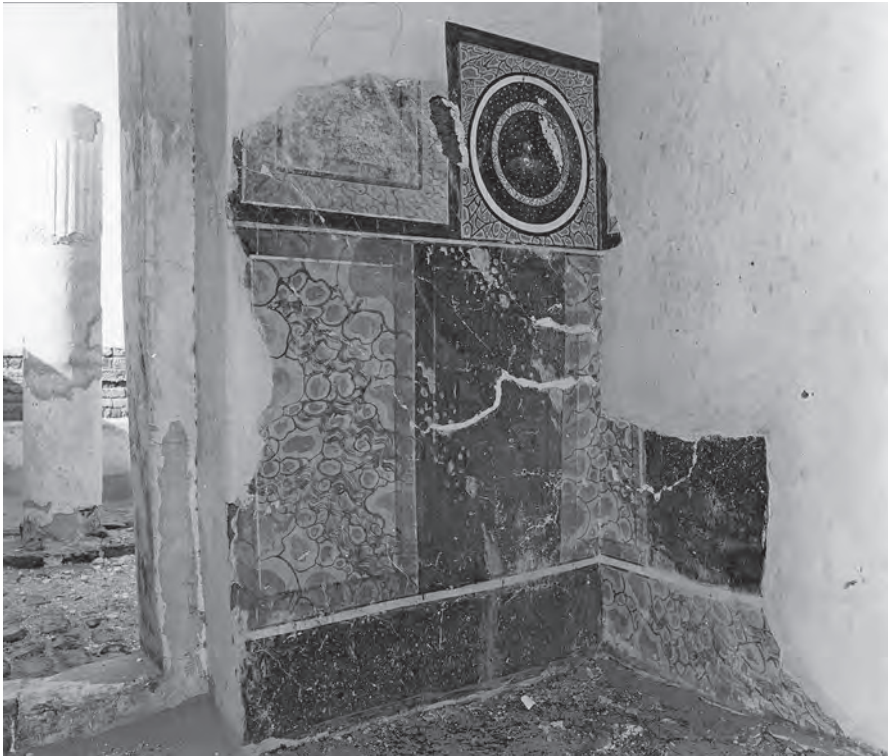
Abb. 32: GB 16, Obergeschoss, erster Raum, Nordostwand; 1973
