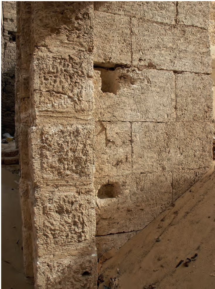
Abb. 12: Verriegelungslöcher in der Eingangstür (östliche Laibung); 2007
