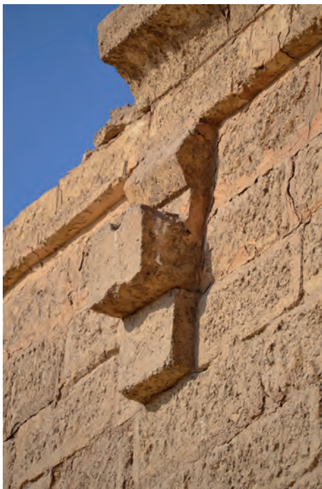
Abb. 6 a: Wasserspeier an GB 48, Seitenansicht; 2021
