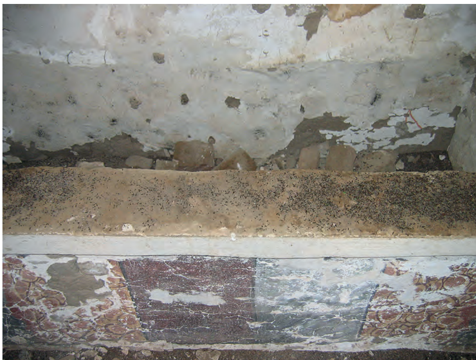
Abb. 24: Erdgeschoss, 2. Raum, Detail Nordwand; 2005
