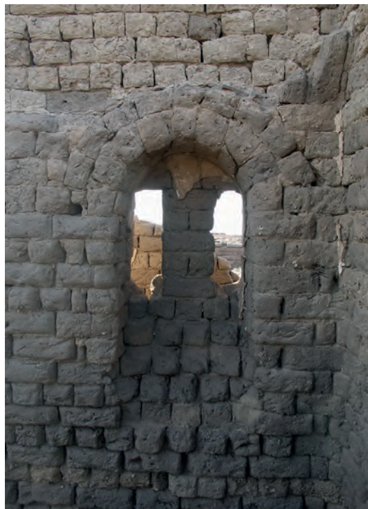
Abb. 31: GB 204.2.4, Rundbognische mit Fensteröffnungen in der Südwand, Innenansicht von Norden; 2010
