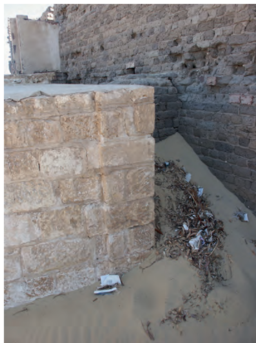
Abb. 10: GB 15, Südostecke mit Pilaster; 2007
