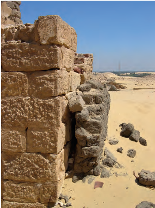
Abb. 9: Mauer aus ungebrannten Ziegeln vor der Südwand; 2005
