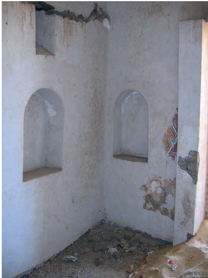
Abb. 20: Blick in die Nordostecke von Raum GB 7.2.2; 2005
