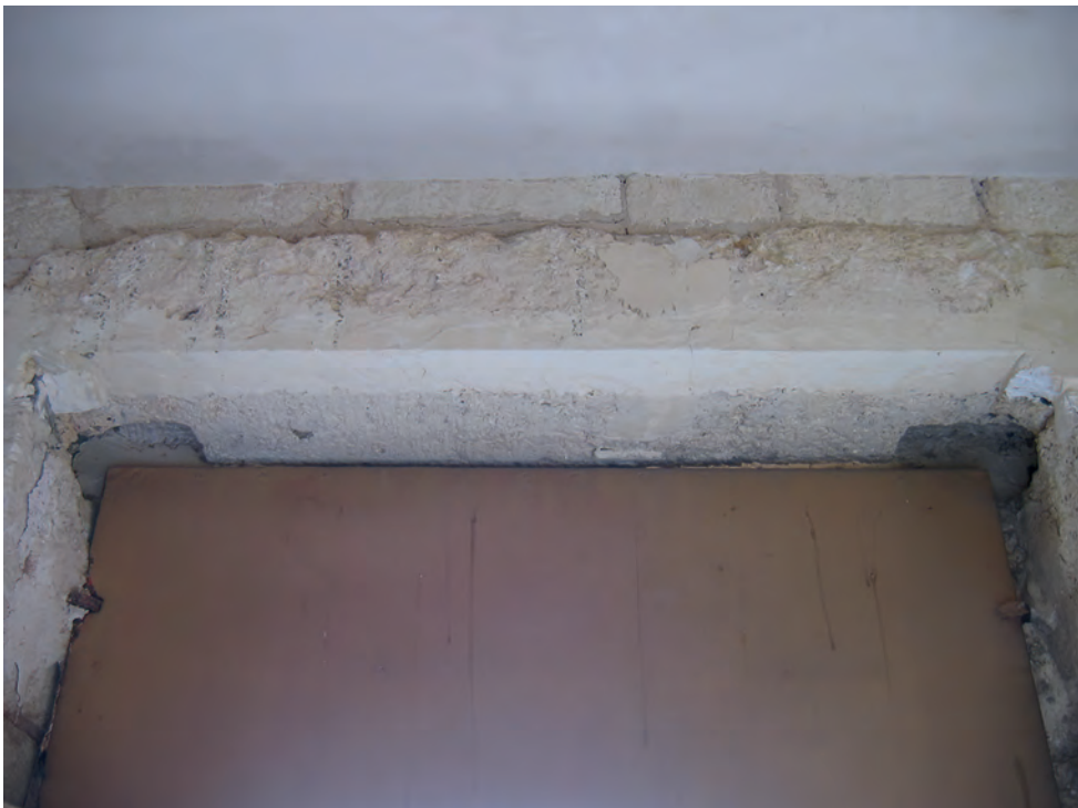
Abb. 13: GB 15, Türsturz mit Einlassungen für das Türgewinde; 2007
