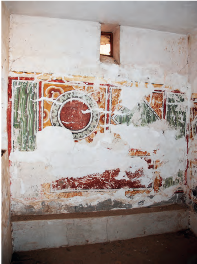
Abb. 15: GB 12, Obergeschoss, 1. Raum, Westwand; 2008
