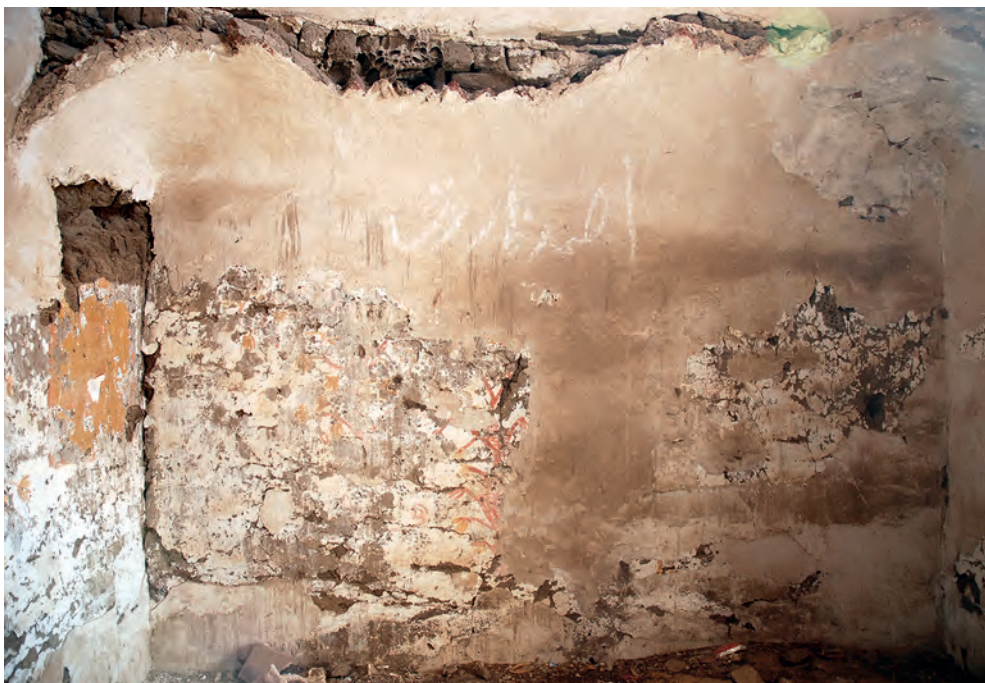
Abb. 8: Erdgeschoss, 1. Raum, Ostwand; 2005
