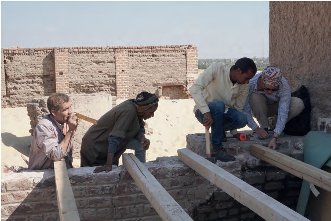
Abb. 5: Gemeinsam mit ägyptischen Architekten und Arbeitern wird das Dach von GB 33 (M 20/SE) erneuert; 2019
