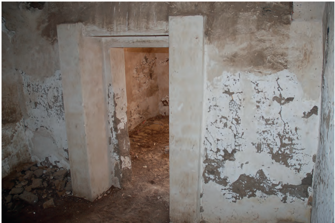
Abb. 12: Erdgeschoss, 2. Raum, Südwand von Westen; 2008
