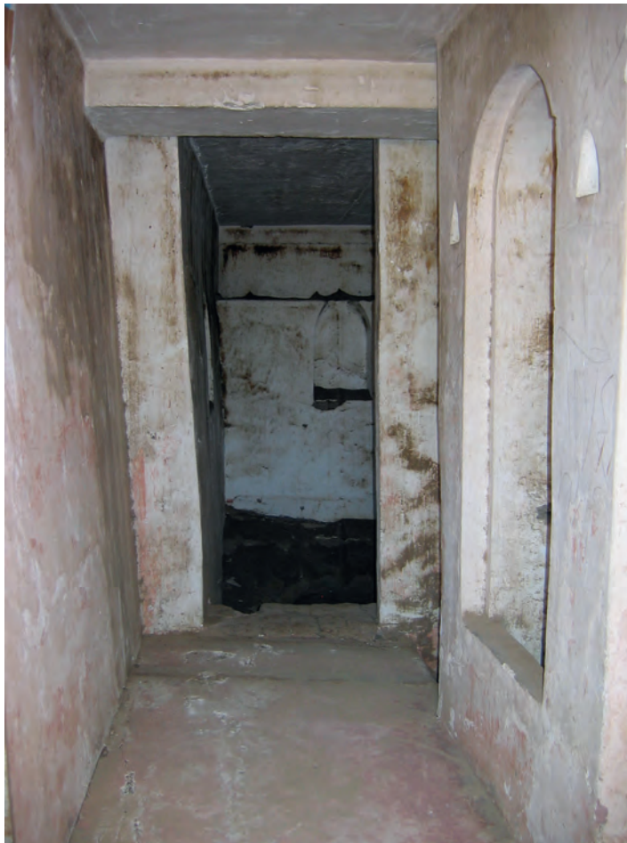
Abb. 20: GB 11, Obergeschoss, Eingangsbereich; 2007
