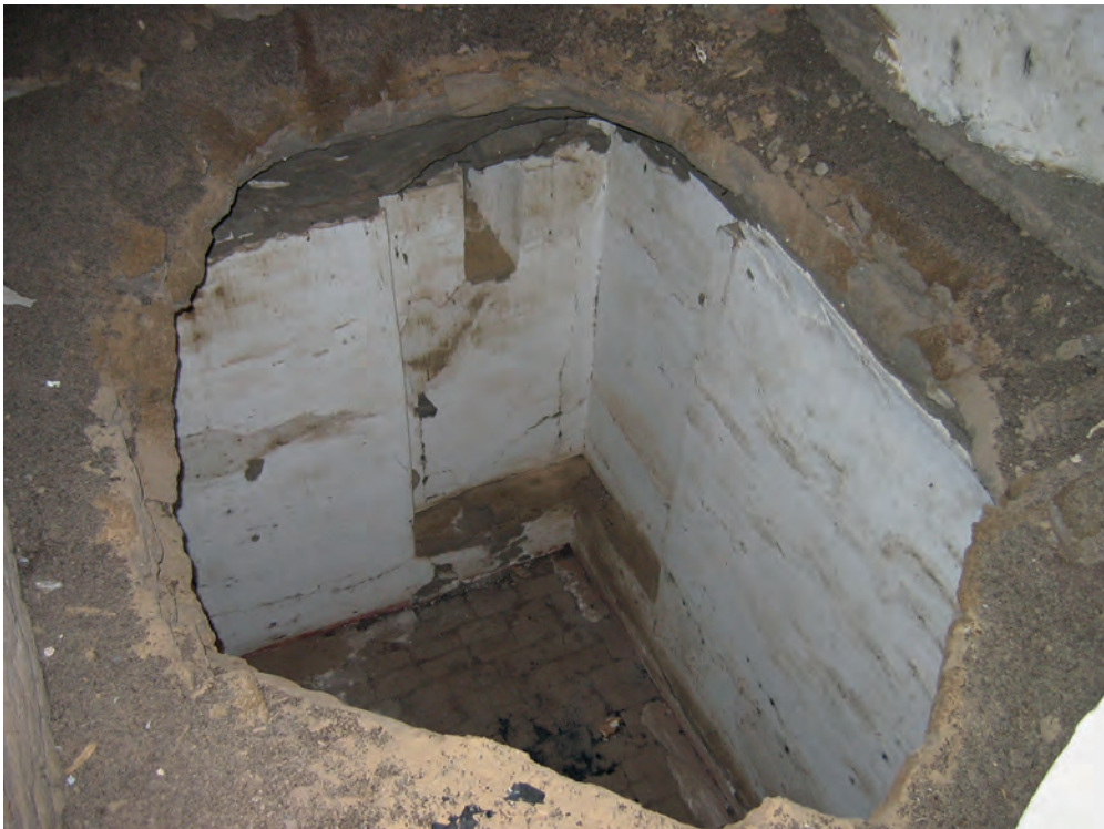
Abb. 25: GB 11, Untergeschoss, Raum; 2007
