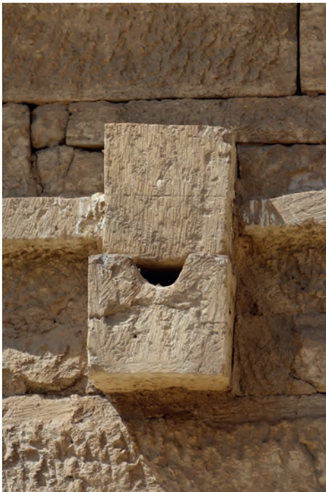
Abb. 5 a: Zweiteiliger Wasserspeier an GB 44, Vorderansicht; 2021
