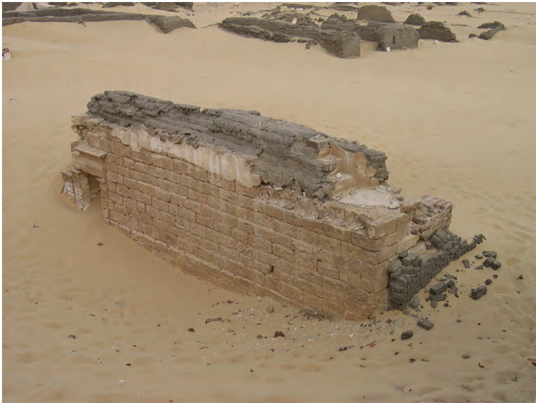
Abb. 10: Ansicht der Westwand von Südwesten; 2006
