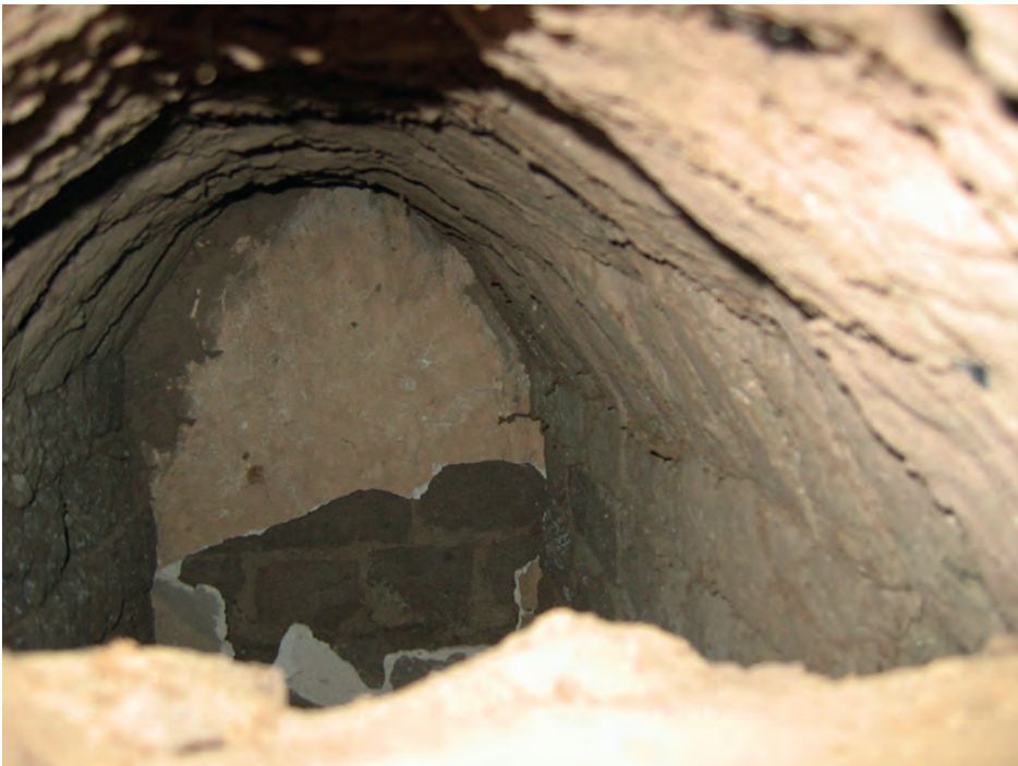
Abb. 9: Vorhalle (GB 5.2.3), Blick in einen Substruktionsbogen; 2007
