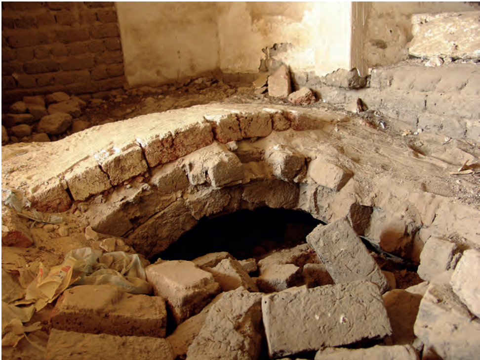
Abb. 8: Gewölbeausbruch im Fußboden in Raum GB 6.2.3; 2006
