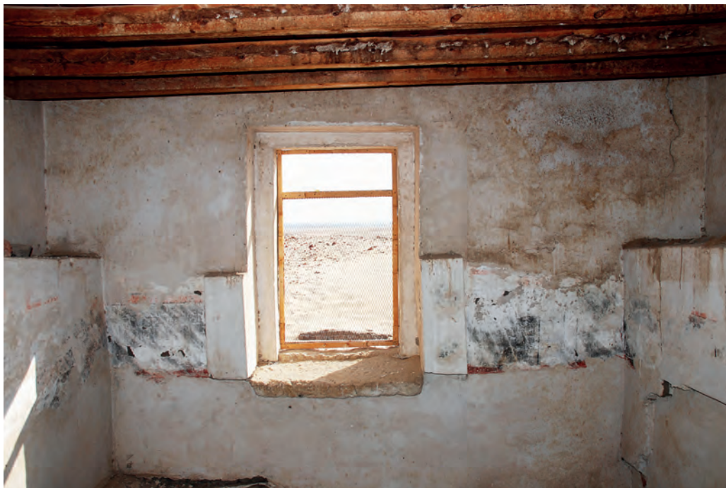
Abb. 16: Obergeschoss, 1. Raum, Südwand; 2008
