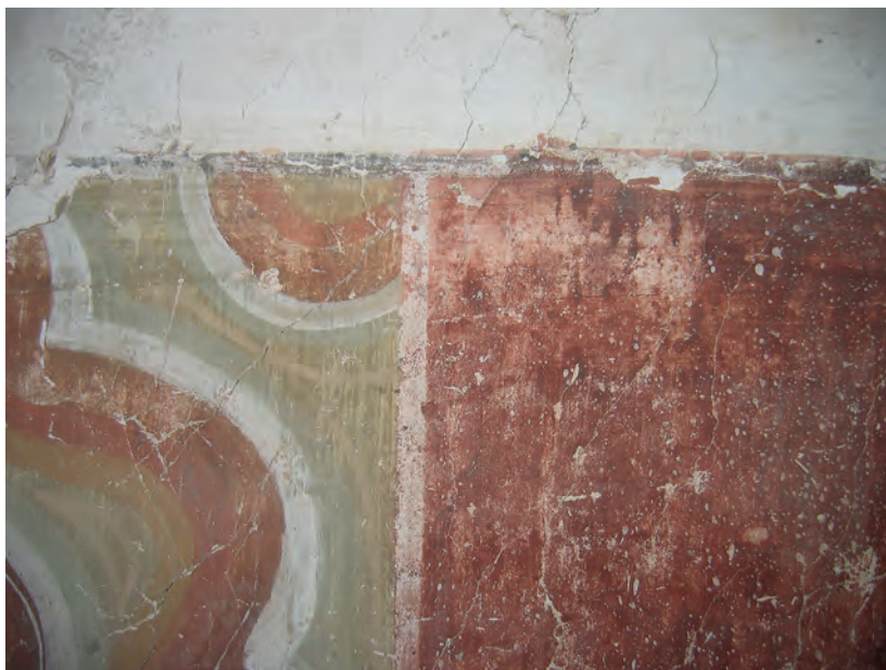
Abb. 8: Vorraum, Nordwand, Detail; 2007
