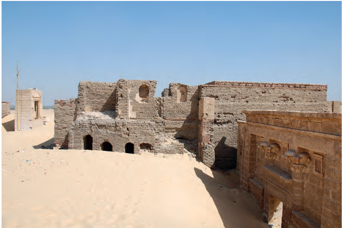
Abb. 25: Ansicht von GB 18 von Westen; 2009
