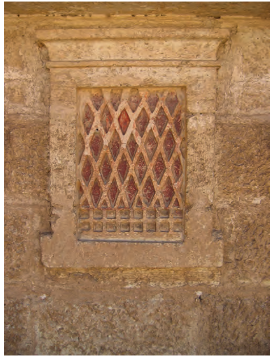
Abb. 7: Fassade, mittleres Fenster; 2006
