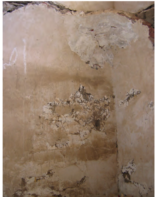
Abb. 11: Erdgeschoss, 1. Raum, Südostecke; 2005
