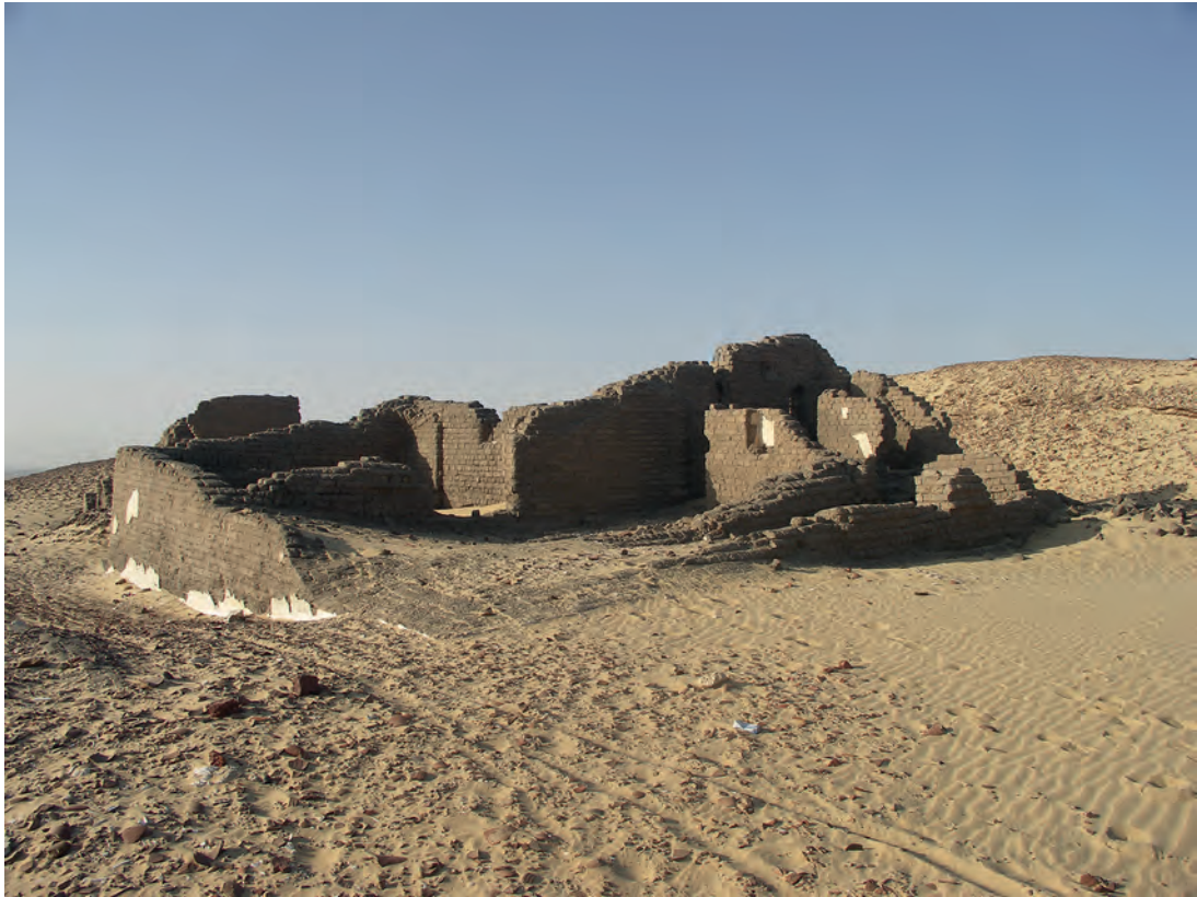
Abb. 26: GB 204, Aufnahme von Nordosten; 2010
