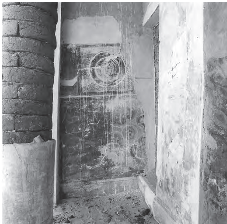
Abb. 41: Südwand der Vorhalle GB 7.2.1; 1987
