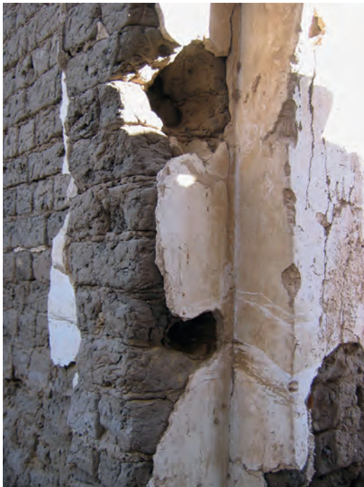
Abb. 11: GB 5.2.1, Haupteingangstür von der Rauminnenseite, östliche Laibung mit zwei unregelmäßigen Riegellöchern; 2006
