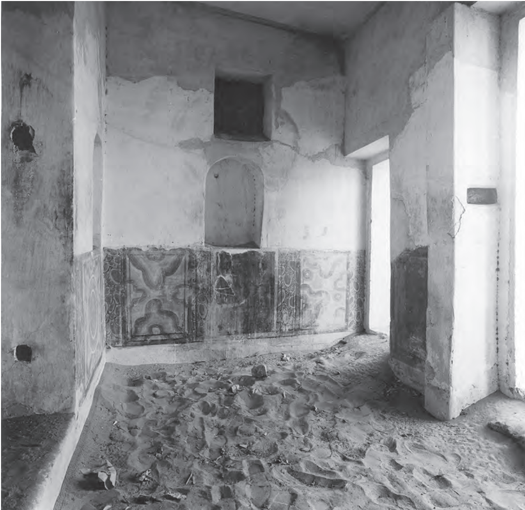
Abb. 18: Nordseite von Raum GB 6.2.2; 1987
