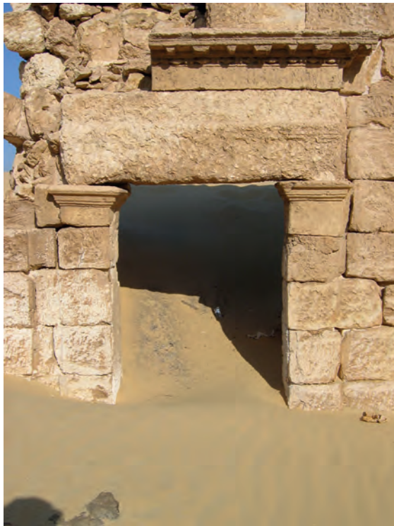
Abb. 11: Tür im nördlichen Bereich der Westwand; 2005
