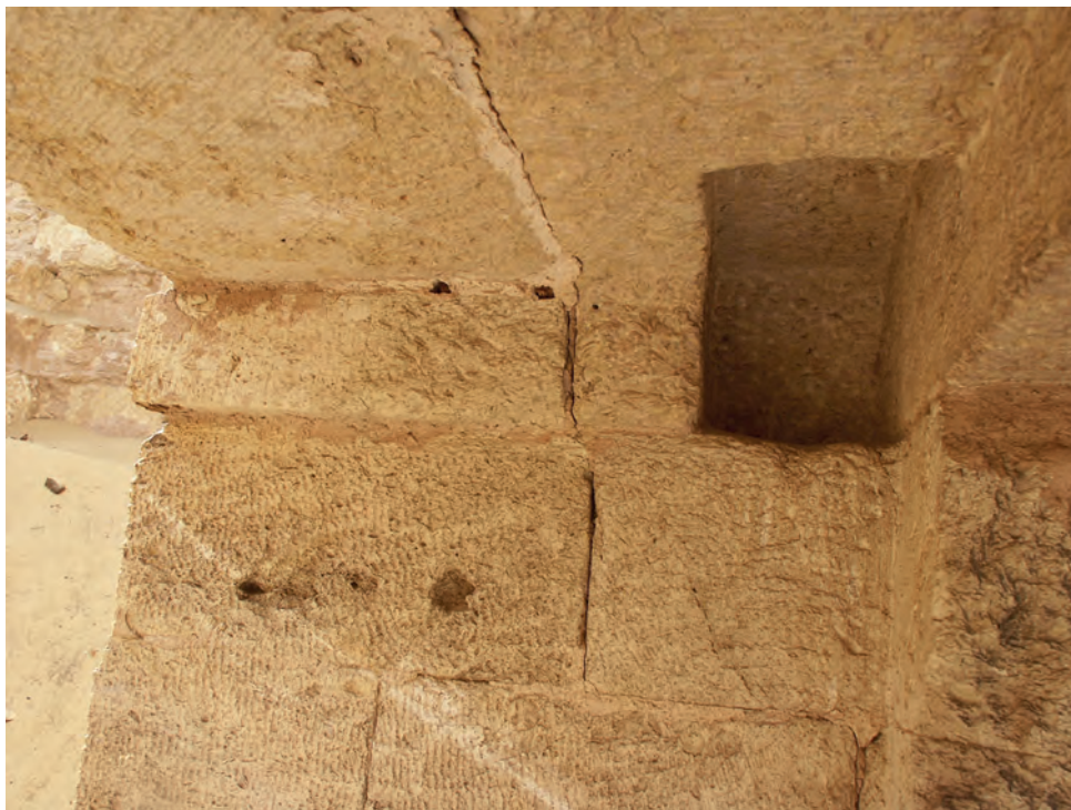
Abb. 13: Angelloch in der westlichen Ecke des Türsturzes; 2007
