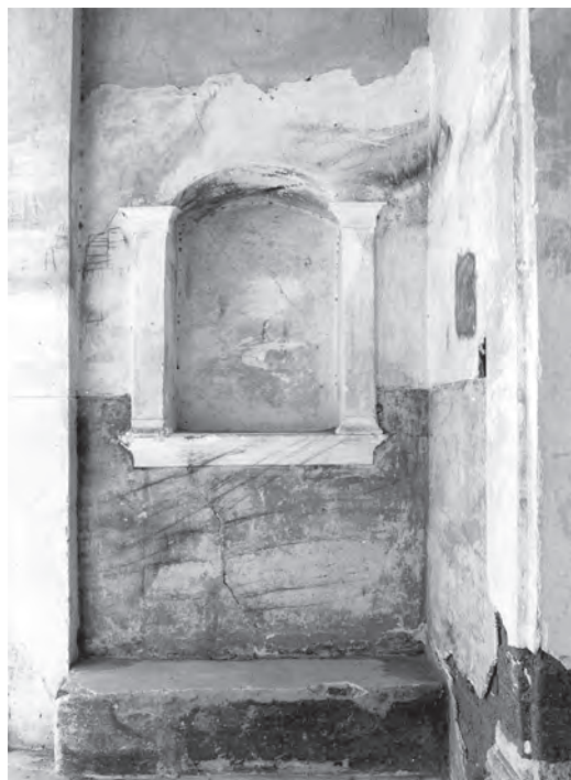
Abb. 3: Vorhalle, Nische in Westwand; 1987
