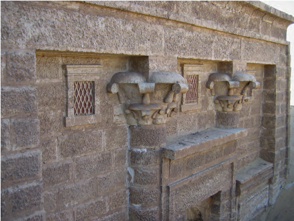
Abb. 4: Oberer Bereich der Fassade von Nordosten; 2007
