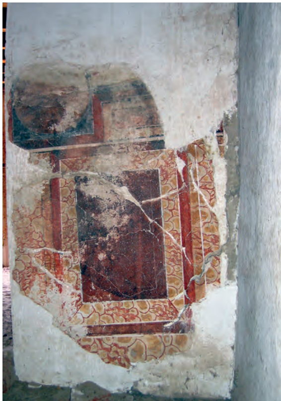
Abb. 41: GB 16, Obergeschoss, zweiter Raum, östliche Nordwand; 2005
