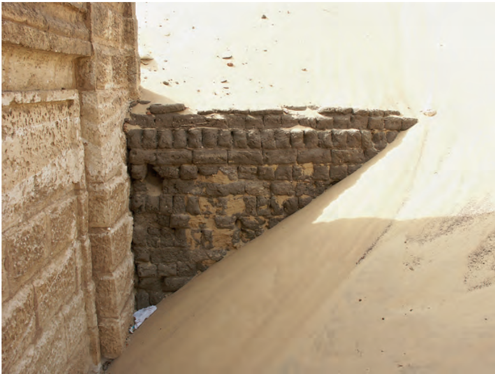
Abb. 14: Nordwestecke der Fassade mit angebauter Lehmziegelmauer; 2007
