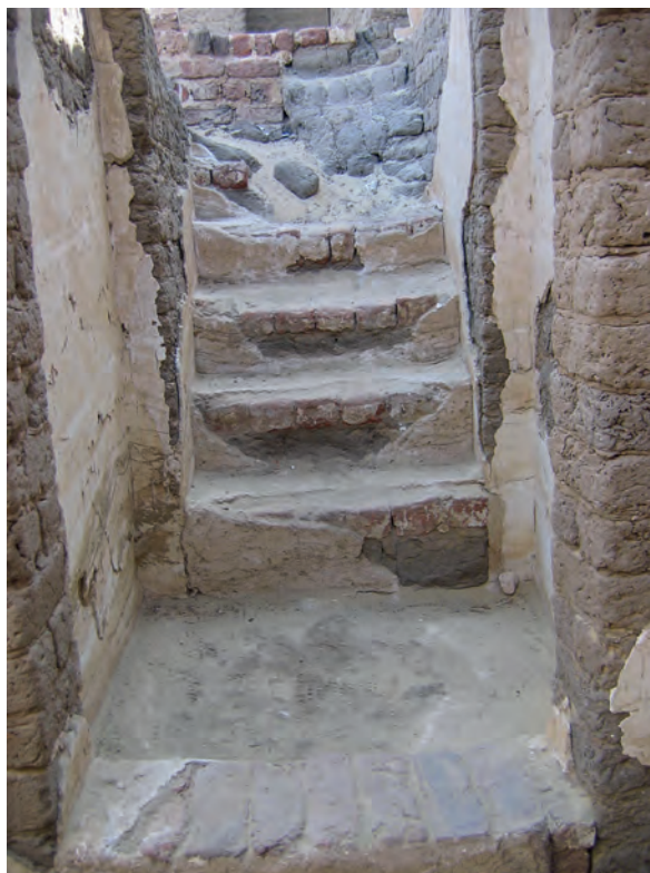
Abb. 21: GB 17, Treppe auf die Terrasse; 2006
