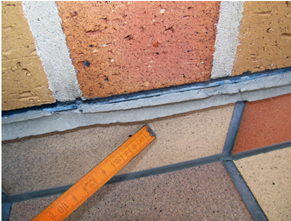
Bild 27 ■ Flankenabriss und Dichtstoffablösung vom Untergrund oberhalb der Sockelfuge
