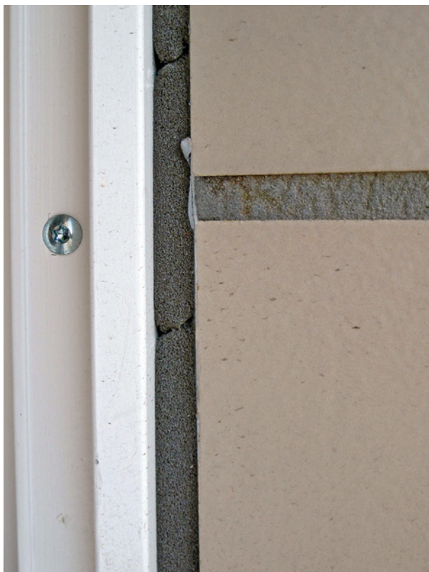
Bild 108 ■ Gestückelte Fugenbänder mit lücken- haften Stoßfugen
