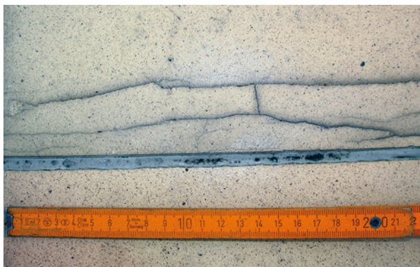
Bild 38 ■ Rissbildungen im Bekleidungsmaterial der Außenwand parallel zur unversehrten Dichtstofffuge
