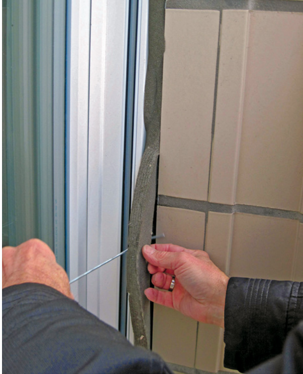
Bild 102 ■ Um 90° gedrehter falscher Einbau des Fugenbandes – Dekomprimierung nicht gegen die Fugenflanken, sondern in die Fugentiefe
