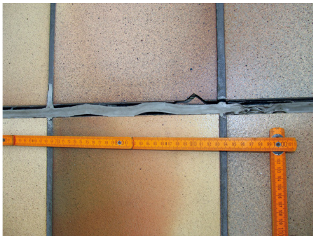
Bild 15 ■ Wechselseitiger Flankenabriss durch falsch dimensionierten Dichtstoff
