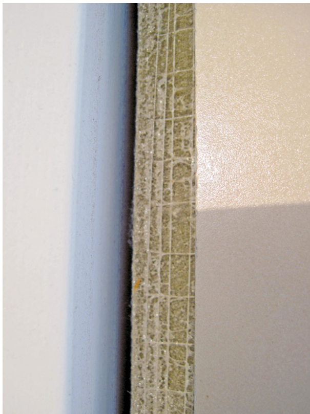
Bild 101 ■ Um 90° gedrehter falscher Ein- bau des Fugenbandes mit »gummierter« Seite nach außen zeigend
