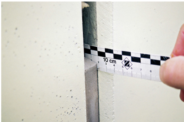
Bild 44 ■ Flankenabriss zwischen zu dick eingebrachtem Dichtstoff und gestrichener Betonflanke
