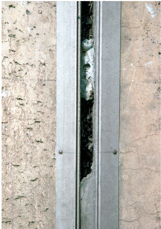
Bild 95 ■ Zerstörung von in Metallzargen eingefassten elastischen Fugenbändern im Gebäudesockelbereich durch Vandalismus
