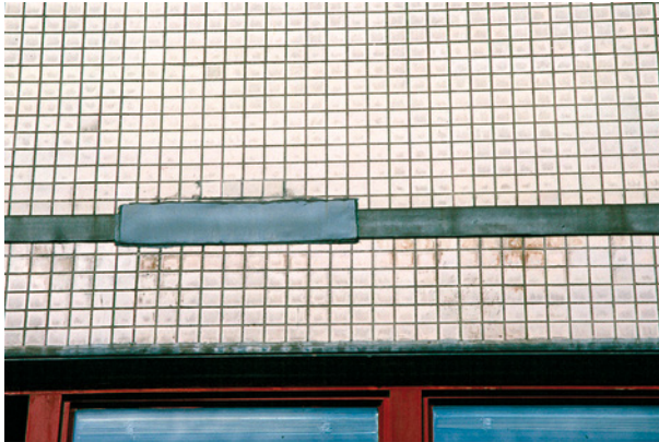
Bild 83 ■ Ausbesserung einer schadhaften Fugenflanke durch Überkleben mit einem breiteren Dichtband
