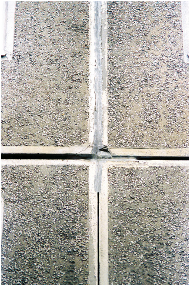
Bild 128 ■ Mit Mörtel teilweise geschlossene konstruktive Fugenausbildung mit Betonabplatzungen im Fugenkreuz
