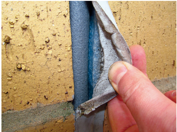
Bild 48 ■ Zu dünne Rundschnur mit Dämmstoffstreifen »ergänzt« – keine fachgerecht ausgerundete Dichtstoffrücklage
