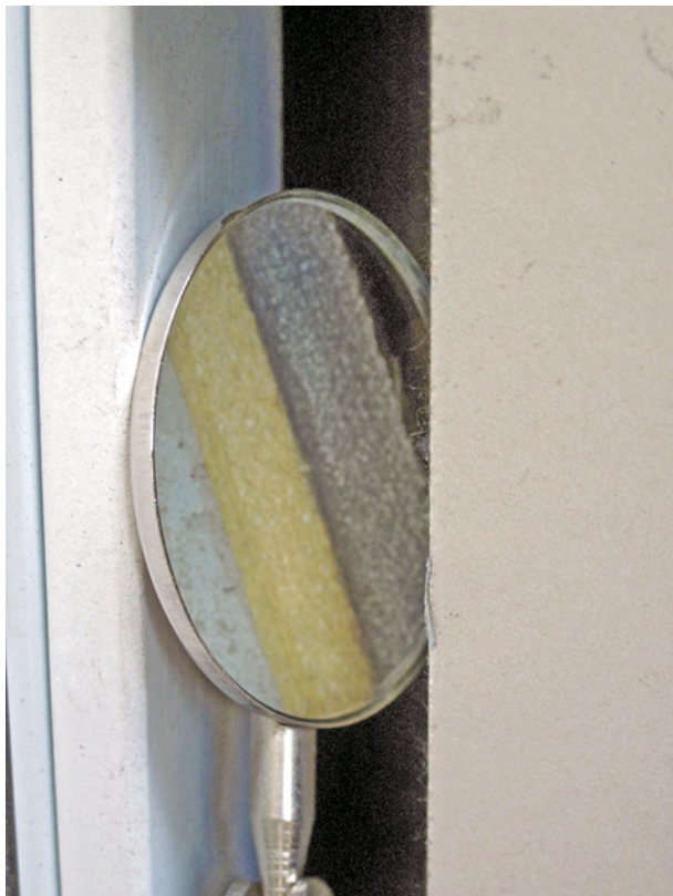
Bild 104 ■ Blick in die zu schmale, verspringende Fugenflanke, bestehend aus den Stirnseiten der Fassadenbekleidung
