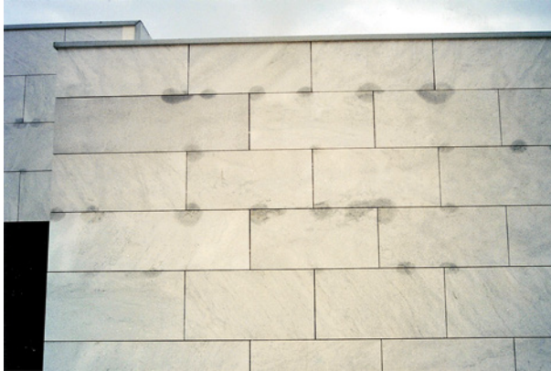
Bild 129 ■ Hinterlüftete Natursteinfassade mit offenen Fugen einige Zeit nach Schlagregenbeaufschlagung
