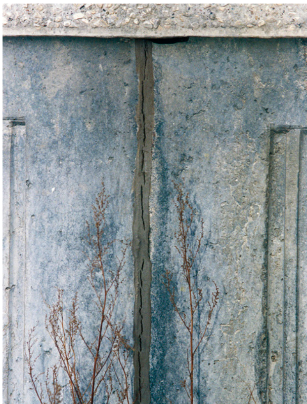
Bild 11 ■ Kohäsionsbrüche im Fugendichtstoff
