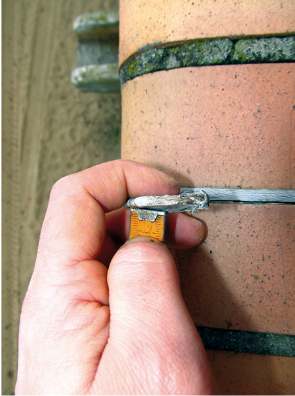
Bild 42 ■ Dichtstoff ohne Hinterfüllprofil satt in Fuge eingebracht
