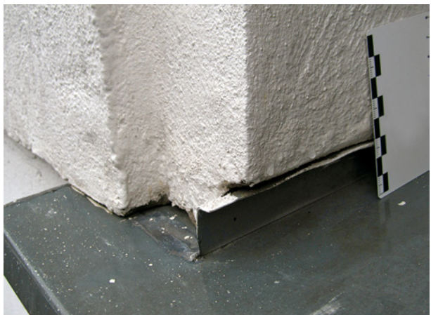
Bild 66 ■ Fensterblech- anschluss an die Fassade ohne Fugenabdichtung
