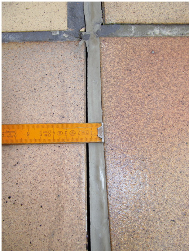
Bild 14 ■ Flankenabriss durch zu dicken, falsch dimensionierten Dichtstoff
