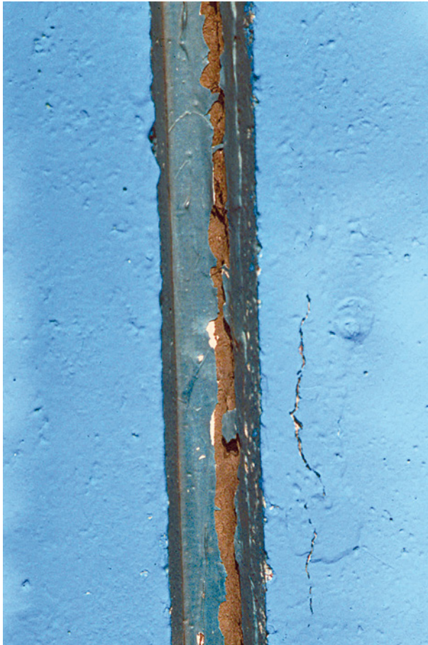
Bild 55 ■ Gerissener und abblätternder Farb- anstrich auf elastischem Fugendichtstoff bei fehlendem Haftverbund zwischen Anstrich und Dichtstoff
