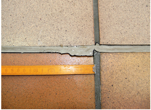
Bild 20 ■ Mit Fugendichtstoff egalisierter Flankenausbruch
