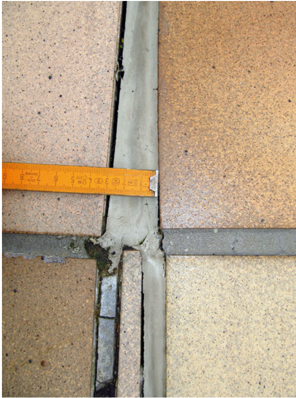
Bild 25 ■ Flankenabriss im Bereich verspringender Fugenbreiten
