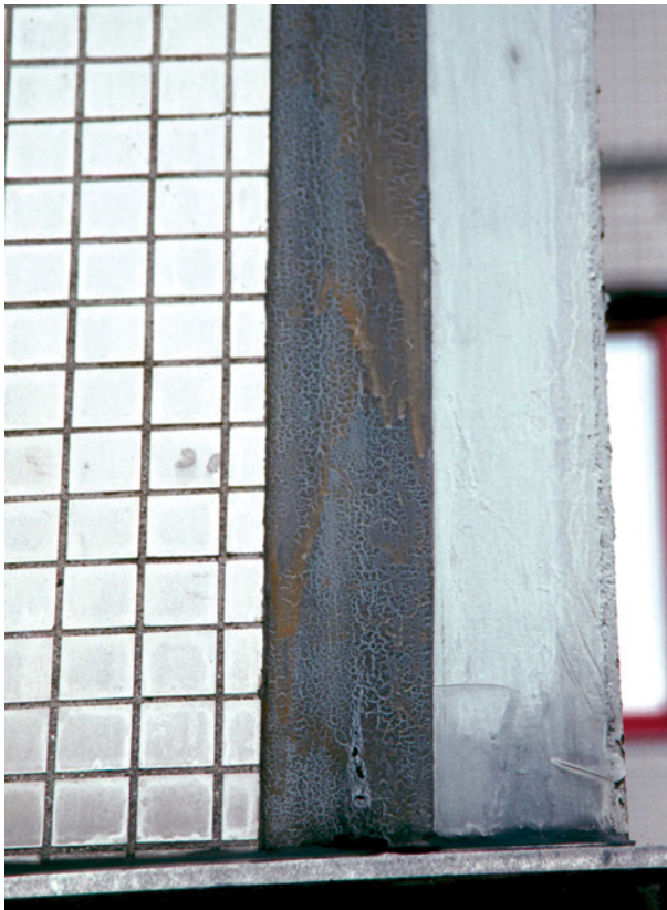
Bild 88 ■ Überaltertes Fugenband mit Rissbildungen in der Dehnzone am unteren Bandende
