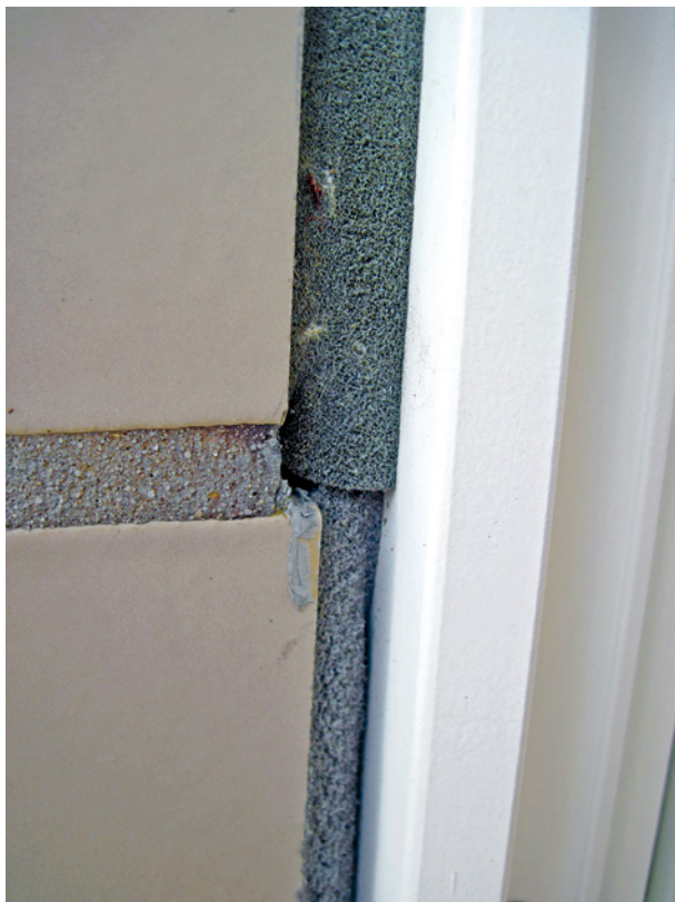
Bild 105 ■ Unzureichende Komprimierung am Versprung der Fugenbreite
