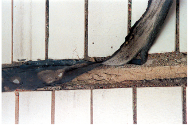
Bild 90 ■ Bewegungsfuge zwischen Fertigteil-elementen kraftschlüssig mit Mörtel ausgefüllt
