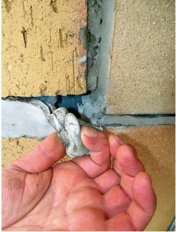
Bild 47 ■ Kein definierter Untergrund – Dichtstoff ohne geometrische Begrenzung eingebracht
