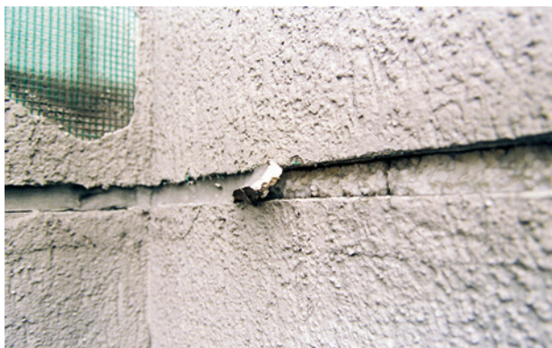
Bild 70 ■ Horizontale Fugenausbildung im Wärmedämmverbundsystem mit elastischem Dichtstoff – Aufwölbungen und Abplatzungen des gewebearmierten Kunstharzputzes an den Rändern
