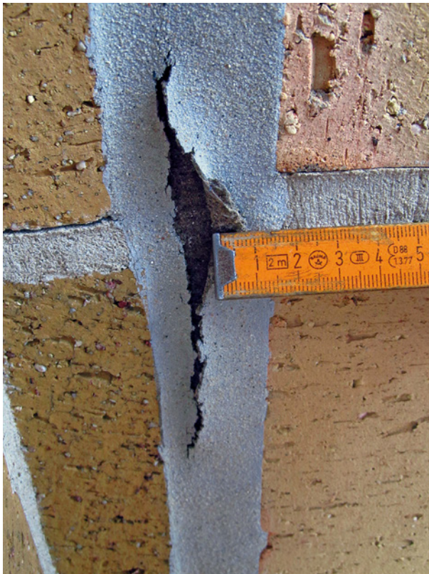
Bild 30 ■ Gerissener Dichtstoff durch zu dünnen Materialauftrag
