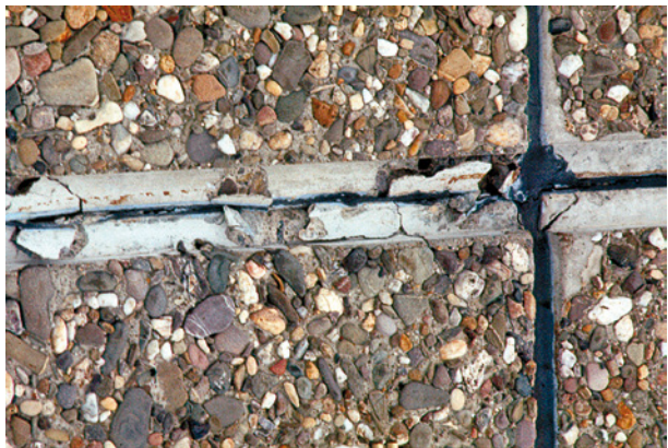
Bild 43 ■ Pressfuge zwischen Stahlbetonfertigteileplatten mit Betonabplatzungen an den Fugenflanken
