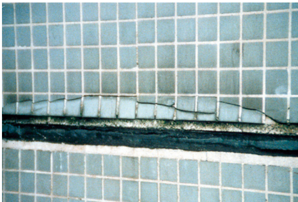
Bild 89 ■ Risse in der Keramikbekleidung von Außenwandplatten aufgrund der Übertragung von Zwängungskräften über die Horizontalfugen
