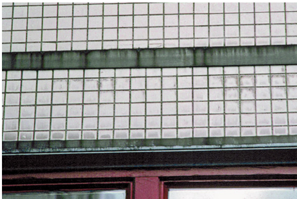
Bild 86 ■ Schmutzläufer auf einer Horizontalfugenabdichtung zwischen Stahlbetonfertigteilelementen
