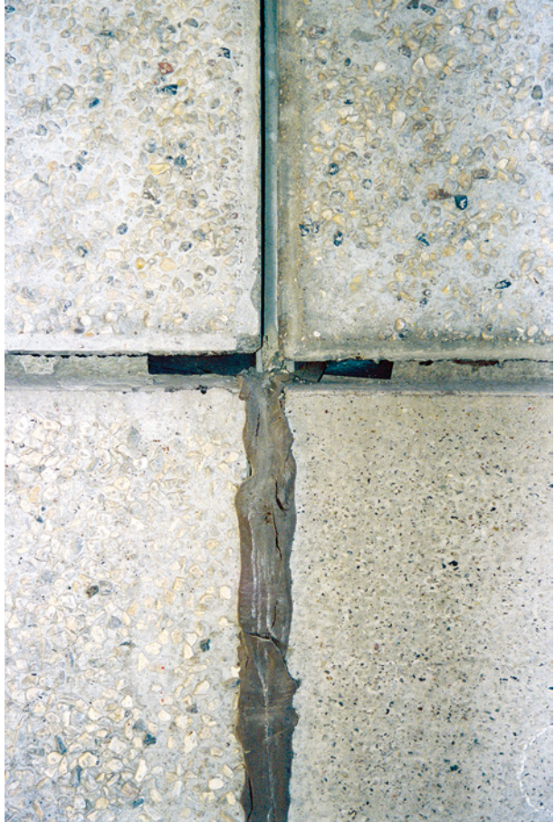
Bild 127 ■ Bereichsweise mit Dichtstoff geschlossene Vertikalfuge innerhalb einer konstruktiven belüfteten Fugenausbildung
