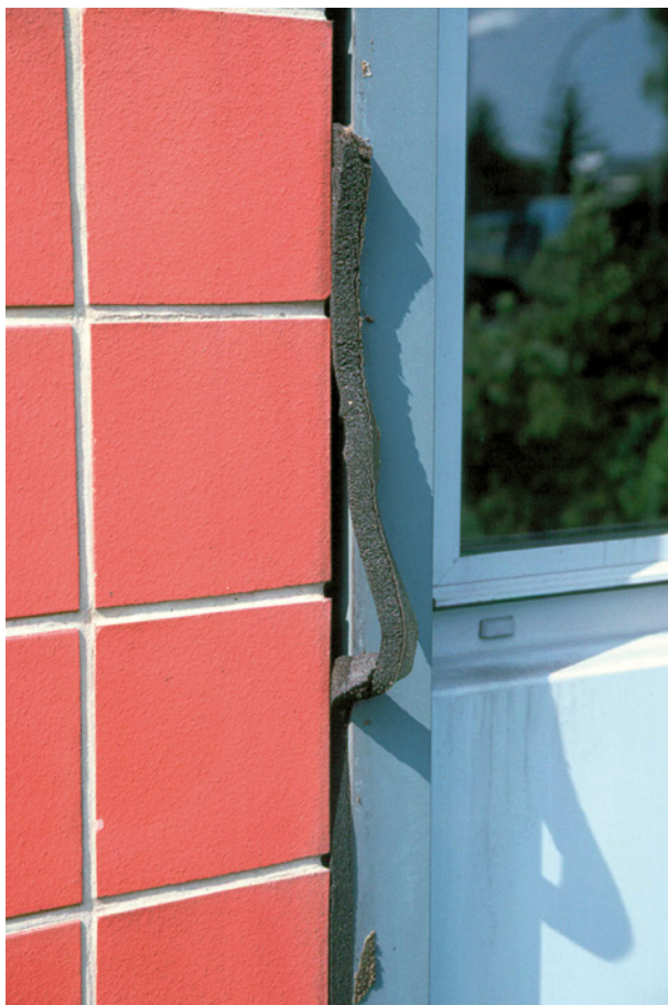
Bild 96 ■ Leicht aus der Fuge herausziehendes, unzureichend komprimiertes Dichtband
