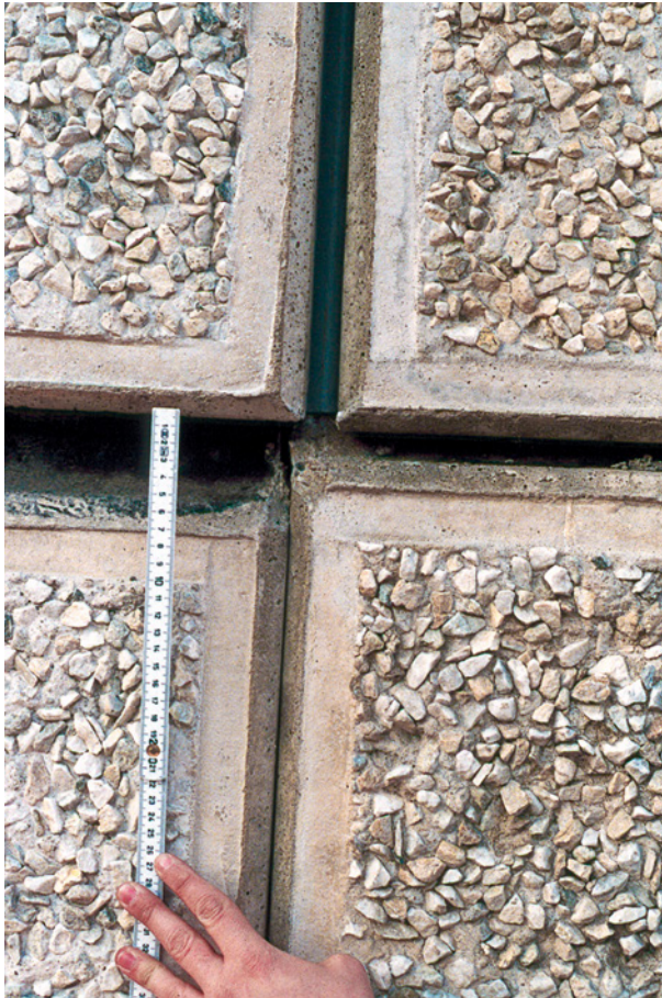
Bild 122 ■ Fugenbreiten zwischen 0 und 6 cm im Bereich eines Fugenkreuzes zwischen Betonfertigteilenelementen
