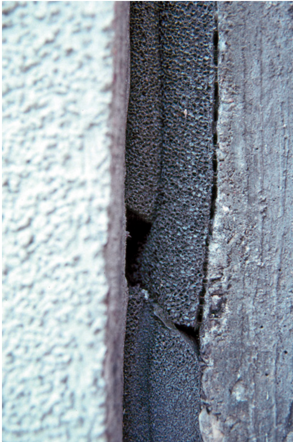
Bild 113 ■ Fugenbandstoß im Bereich aufgedoppelter vorkomprimierter Dichtbänder mit größeren Fehlstellen
