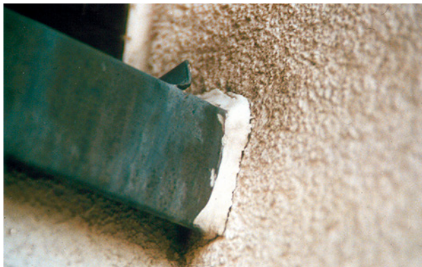
Bild 61 ■ Fensterblechanschluss an den Kunstharzputz eines Wärmedämmverbundsystems – von den Haftflanken abgerissener elastischer Dichtstoff
