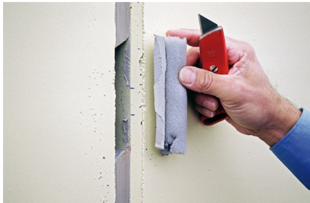
Bild 46 ■ Sichtbare Haft- flanken von Beton und Dichtstoff nach Probe- nahme (deutlich erkenn- bar: nur begrenzt wirk- same Haftflächen)
