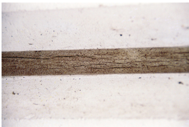
Bild 50 ■ Gerissener Lasuranstrich und Kerbrissbildungen im Dichtstoff an einer überstrichenen Fuge
