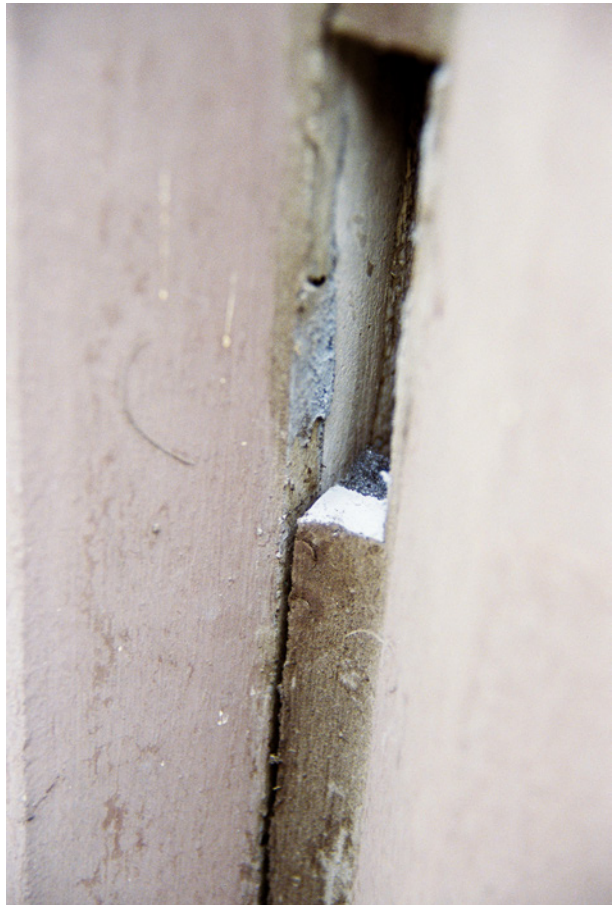
Bild 13 ■ Flankenabriss und fehlende Verjüngung des Dichtstoffes zur Fugenmitte hin
