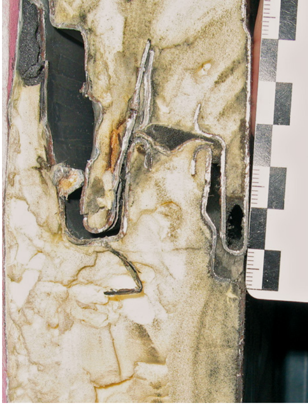
Bild 69 ■ Fugendetail der Elementstöße (außenseitig mit Dichtstoff gefüllt und raumseitig mit offener Fuge)
