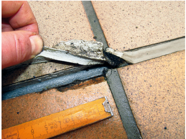
Bild 21 ■ undefinierter Haftgrund für den Dichtstoff (vgl. Bild 20)
