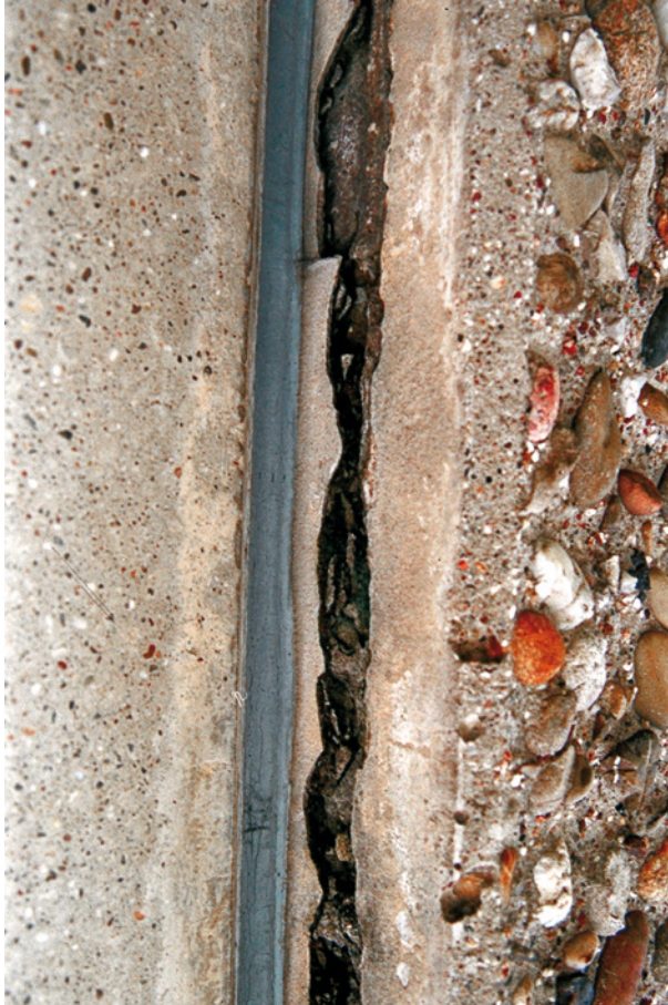
Bild 36 ■ Abriss der Betonflanke neben einer elastisch abgedichteten Bewegungsfuge zwischen zwei Betonbauteilen
