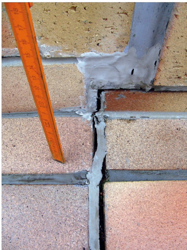
Bild 26 ■ Flankenabriss im Bereich eines Fugen- versprungs
