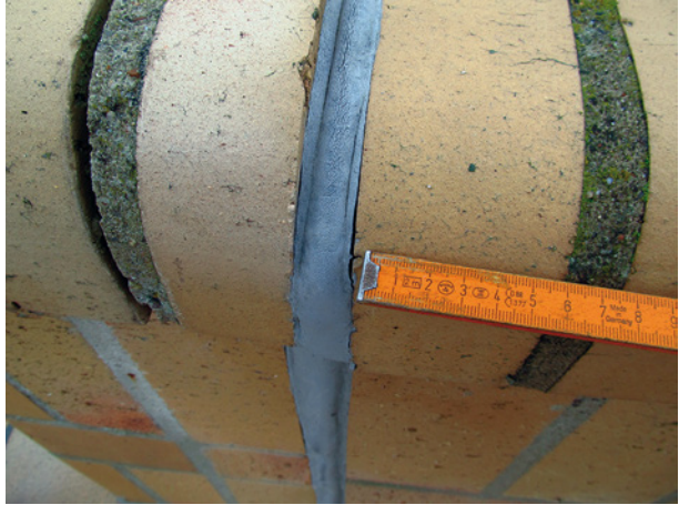
Bild 40 ■ Breite Dehnfuge mit Dichtstoff satt ausgefüllt und Flankenabrisse der benachbarten Mörtelfugen
