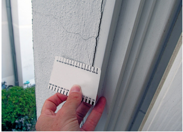
Bild 64 ■ Riss zwischen Blendrahmen und Putz- laibung ohne Fugen- ausbildung
