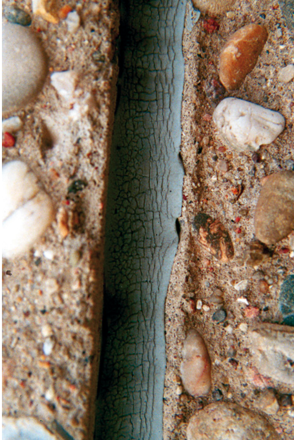
Bild 35 ■ Elastische Fugenabdichtung, ca. zwölf Jahre alt
