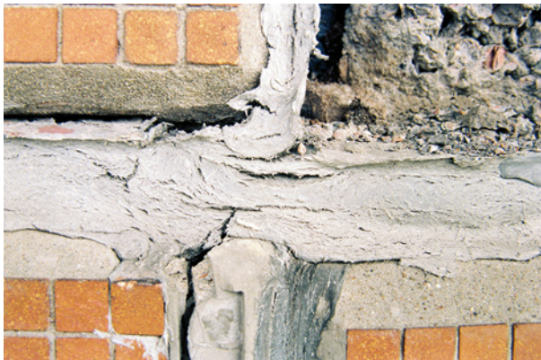
Bild 34 ■ Betonabplatzungen im Fugenflankenbereich neben vollständig ausgehärtetem Morinol-Dichtstoff
