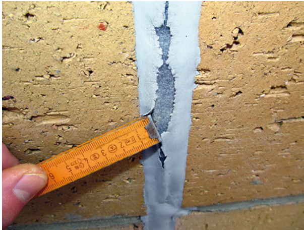
Bild 29 ■ Dichtstoffperforation durch zu dünnen Materialauftrag
