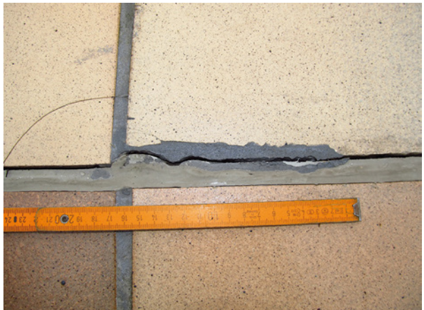
Bild 22 ■ undefinierte Mörtelausbesserung der Haftflanke
