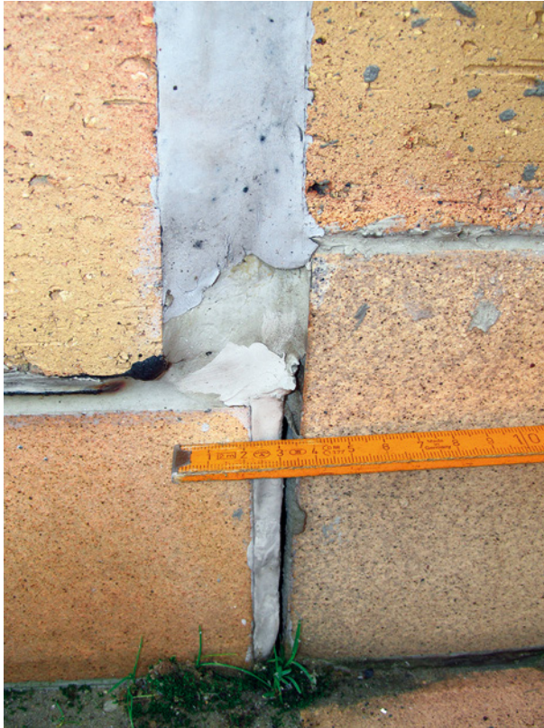
Bild 18 ■ Flankenabriss des Dichtstoffes in einer nur wenige Millimeter breiten Fuge an extremem Fugenversprung
