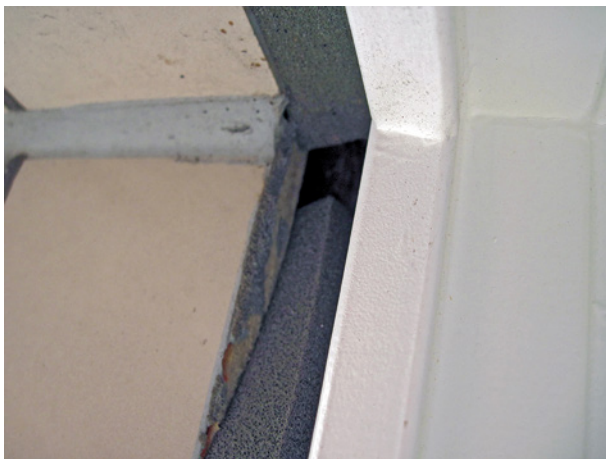
Bild 103 ■ Zu schmale Fugenflanke (kleiner als die Fugenbreite) mit offenem Hohlraum dahinter
