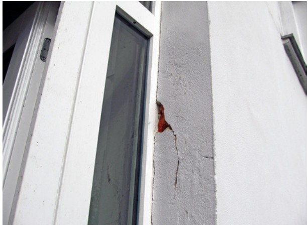
Bild 65 ■ Risse und Putzabplatzungen bei fehlender Fugenaus- bildung zwischen Blend- rahmen und Putzlaibung
