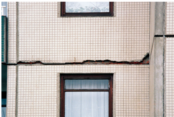
Bild 125 ■ Betonabplatzungen im Bereich der offenen Horizontalfugen infolge korrodierter Bewehrung
