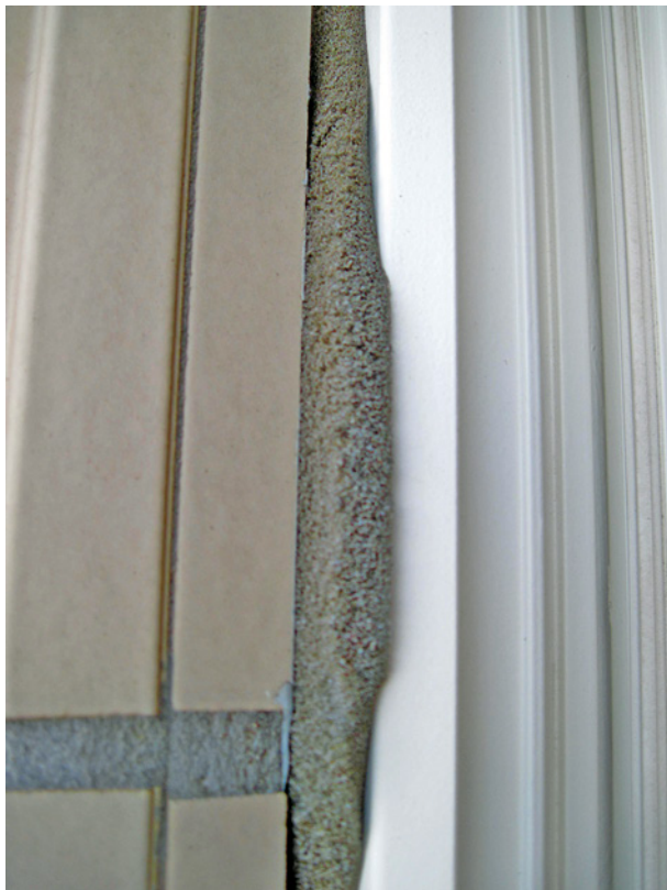
Bild 112 ■ Einbau eines falschen Fugenbandmaterials mit unzureichender Kompression
