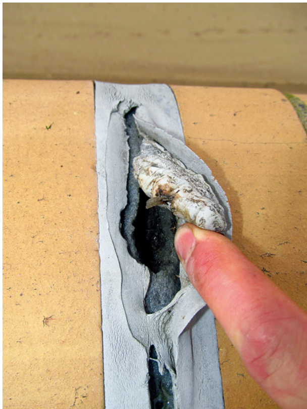
Bild 49 ■ Lückenhaftes Hinterfüllprofil mit Dichtstoff undefiniert ausgefüllt
