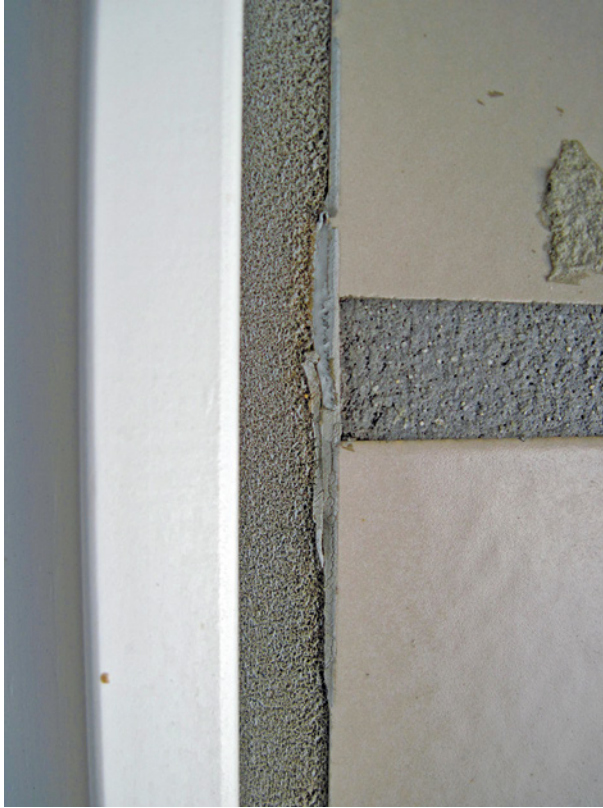
Bild 109 ■ Mit Dichtstoff geflicktes Fugenband an der Flanke
