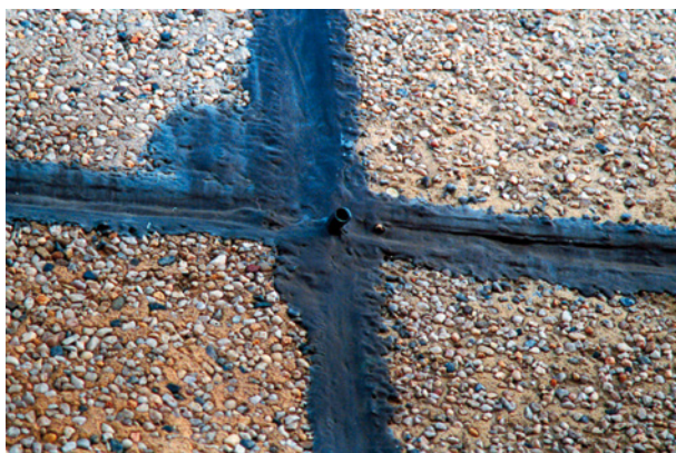
Bild 94 ■ »Entlüftungsröhrchen« im Fugenkreuz zwischen Außenwandelementen
