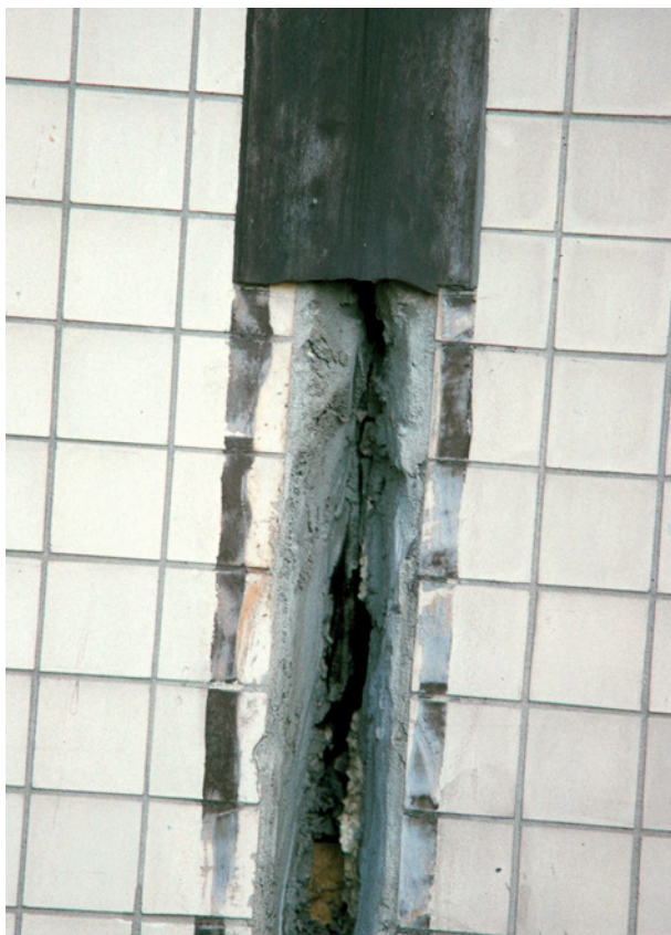
Bild 80 ■ Unzureichende Verklebung eines Fugenbandes mit dem Untergrund
