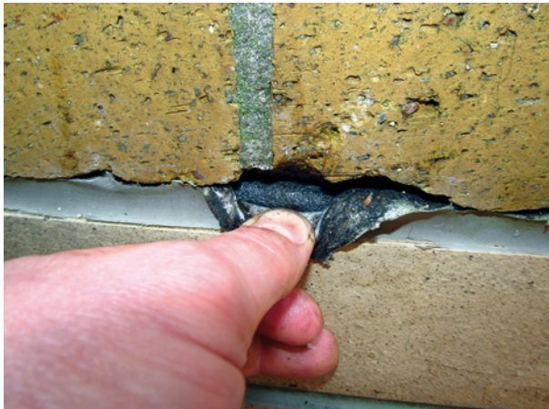
Bild 24 ■ Ausgebrochene Haftflanke (vgl. Bild 23)
