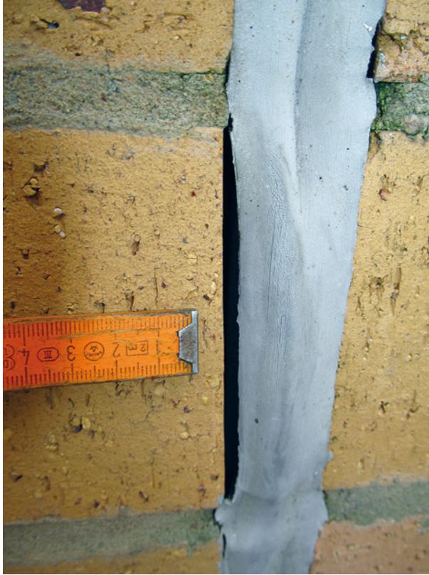
Bild 31 ■ Flankenabriss aufgrund zu dünner Haftflanke
