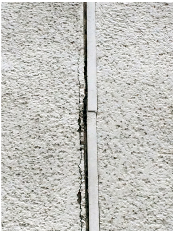
Bild 117 ■ Dehnfugenausbildung in einer Putzfassade mittels Putzabschlussprofilen aus Metall und Versiegelung mit elastischem Dichtstoff – Abriss des Putzprofils von der Putzflanke und Rissbildungen in den Putzflanken
