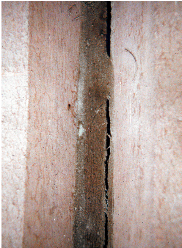
Bild 17 ■ Flankenabriss des Dichtstoffes durch Überdehnung
