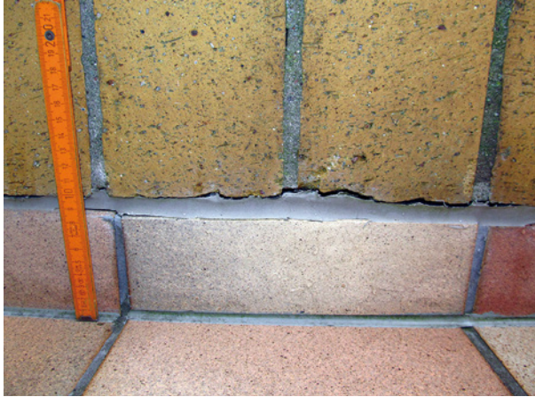
Bild 23 ■ Flankenabriss über Sockelfliese
