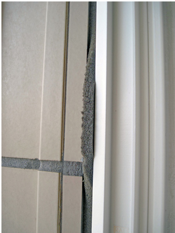
Bild 111 ■ Einbau eines falschen Fugenbandmaterials mit unzureichender Kompression
