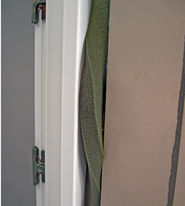
Bild 100 ■ Nach dem Einbau verdrehtes Fugenband aufgrund unzureichender Komprimierung
