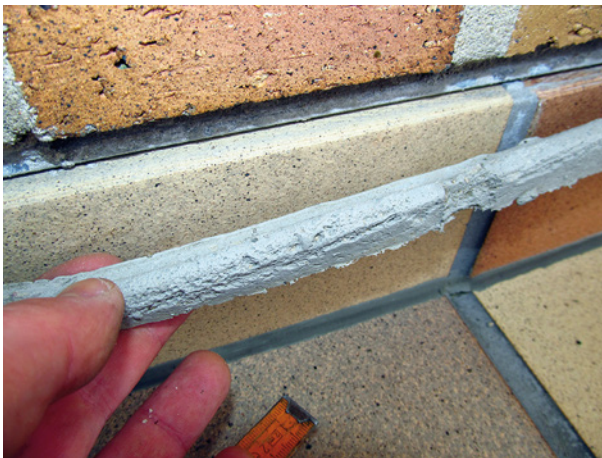
Bild 28 ■ Fehlende Dehnzone (Dreiflankenhaftung) des Dichtstoffes (vgl. Bild 27)
