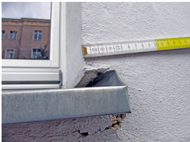
Bild 58 ■ Fehlende Fensterblechabdichtung – Risse und Putzabplatzungen infolge von Zwängungen
