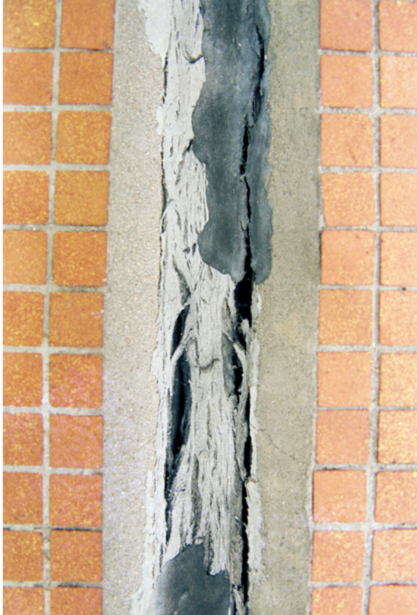
Bild 33 ■ Asbestfaserbewehrte, gerissene, vollständig ausgehärtete Morinol-Dichtungsmasse – bereichsweise erfolglos nachgearbeitet
