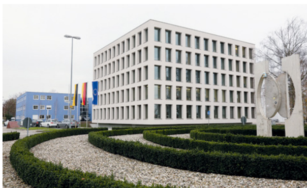
Bild 13: Seminargebäude der Hochschule Offenburg [Quelle: Ulrich Marx]
