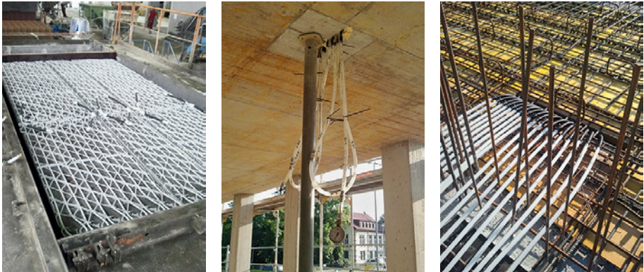
Bild 8: Thermoaktive Bauteilsysteme in der Bauphase 2: vorgefertigte Rohrregister (hier: sechs Stück auf der Schalung für ein Betonfertigteil), Druckprüfung, Deckenan-schluss mit Setzkästen (hier: von oben vor dem Betonieren; in Bild 1 : von unten nach dem Betonieren) [Quelle: Hochschule Offenburg]
