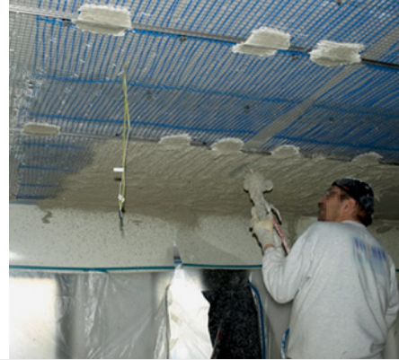
Bild 62: FRAUNHOFER ISE, Sanierung Gebäude I [Quelle: Fraunhofer ISE]
