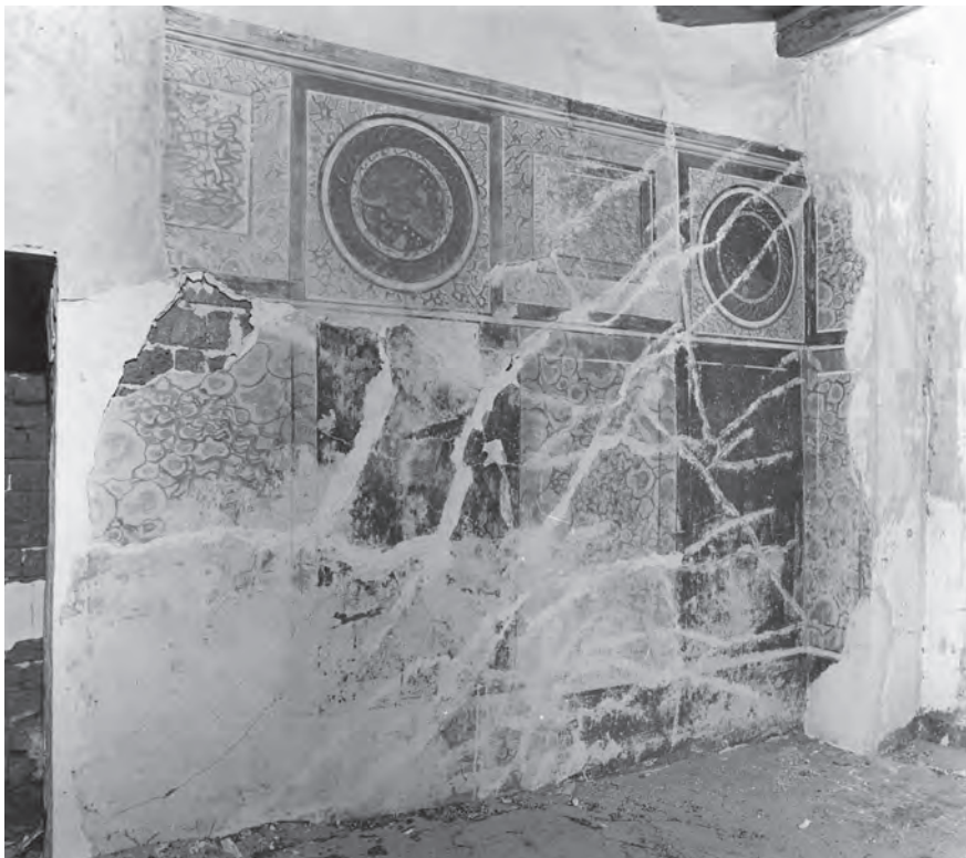
Abb. 3: GB 16, Obergeschoss, erster Raum, Westwand; 1973
