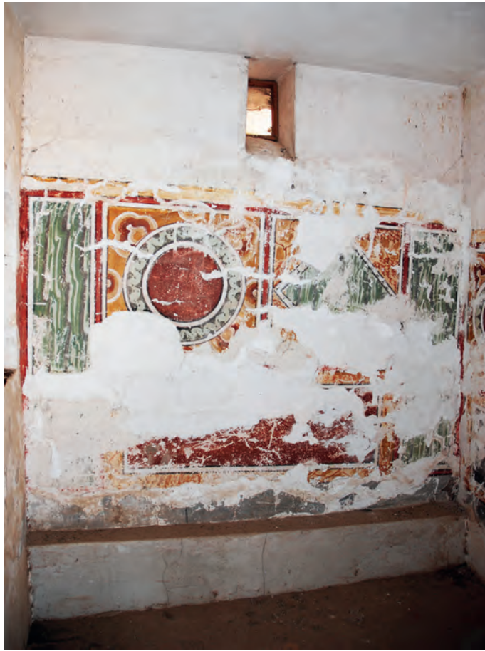
Abb. 15: GB 12, Obergeschoss, 1. Raum, Westwand; 2008
