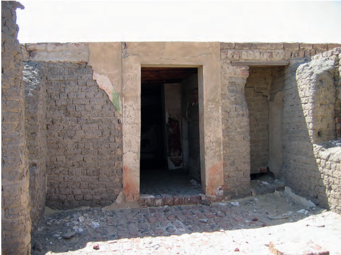
Abb. 1: GB 16, Ansicht des Obergeschosses mit Vorhalle; 2005
