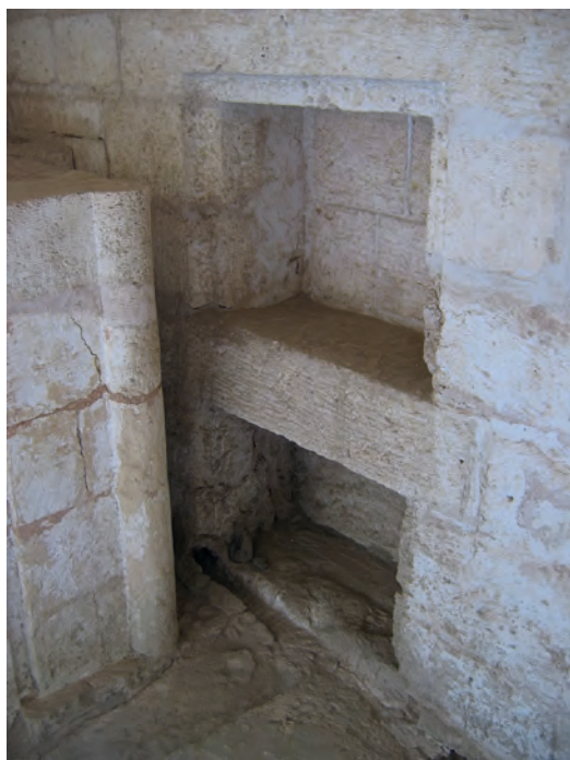
Abb. 16: GB 15, Innenraum, Westseite mit zwei übereinanderliegenden Nischen; 2007
