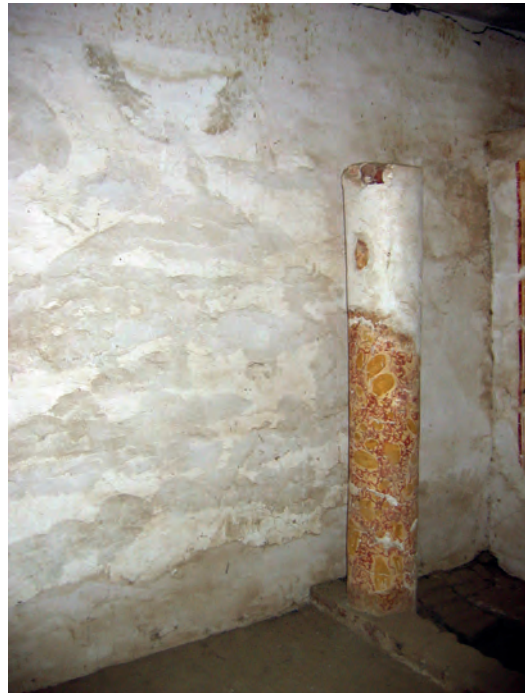
Abb. 27: GB 12, Obergeschoss, 2. Raum, Ostwand mit Girlande; 2006
