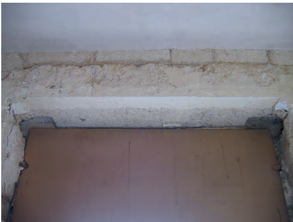
Abb. 13: GB 15, Türsturz mit Einlassungen für das Türgewinde; 2007
