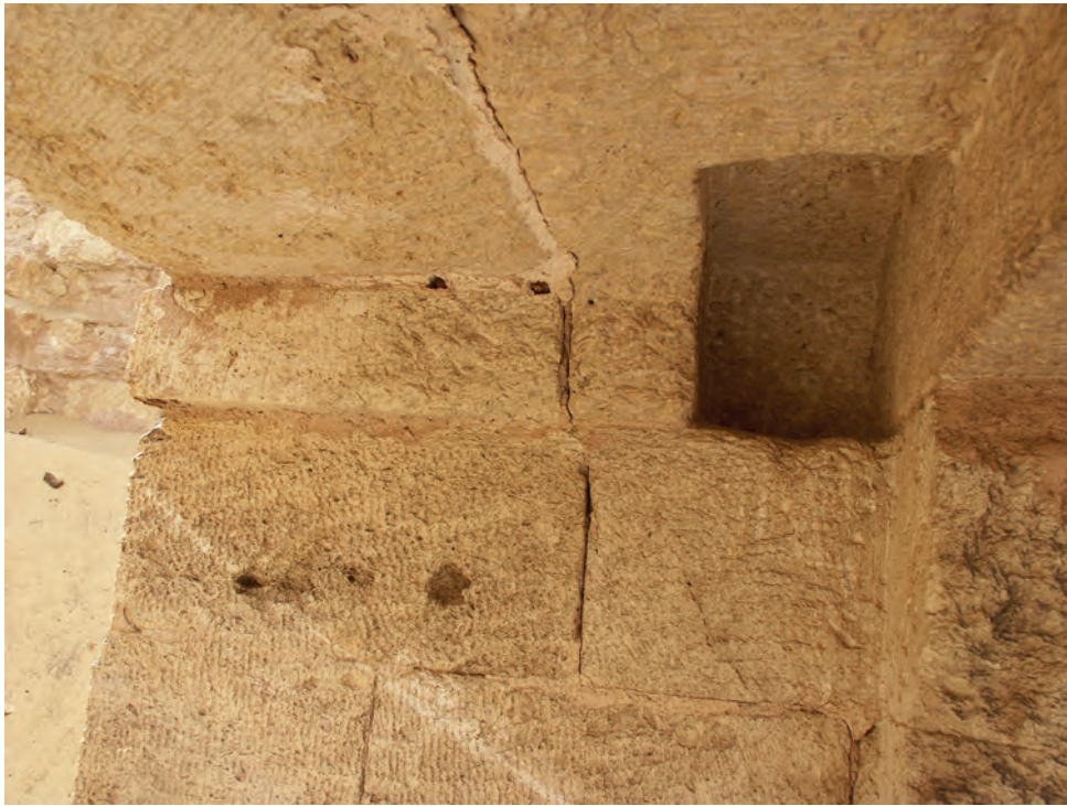
Abb. 13: Angelloch in der westlichen Ecke des Türsturzes; 2007
