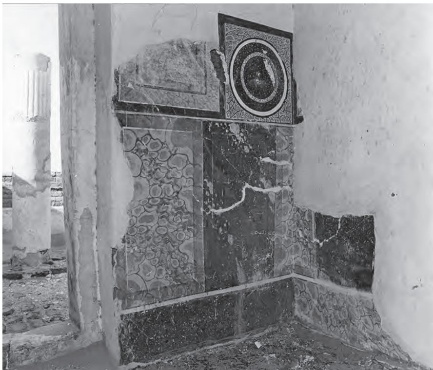
Abb. 32: GB 16, Obergeschoss, erster Raum, Nordostwand; 1973
