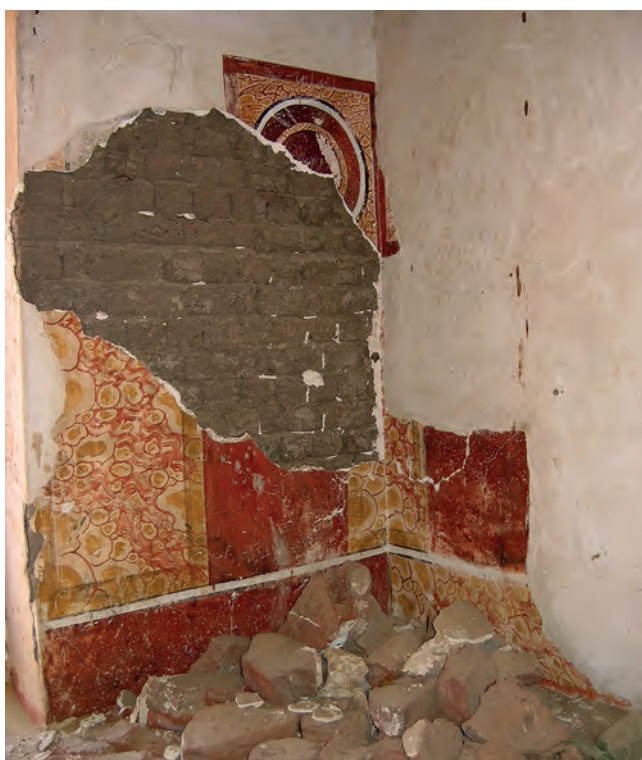
Abb. 33: GB 16, Obergeschoss, erster Raum, Nordostwand; 2005
