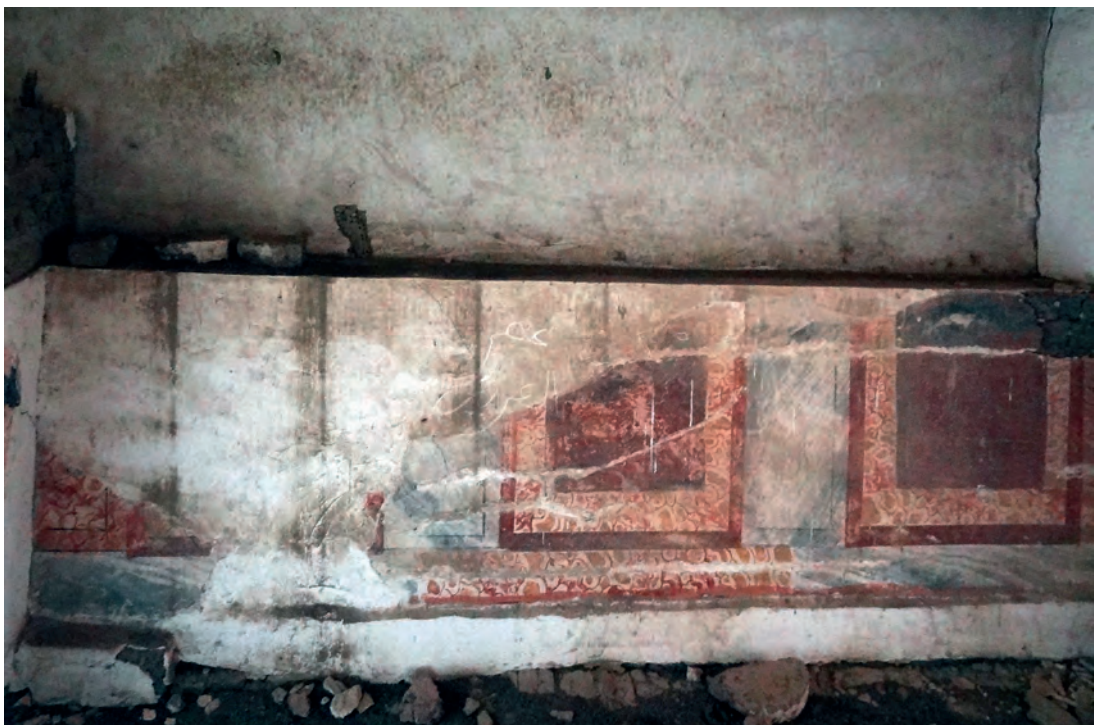
Abb. 43: GB 16, Obergeschoss, zweiter Raum, Westwand; 2019
