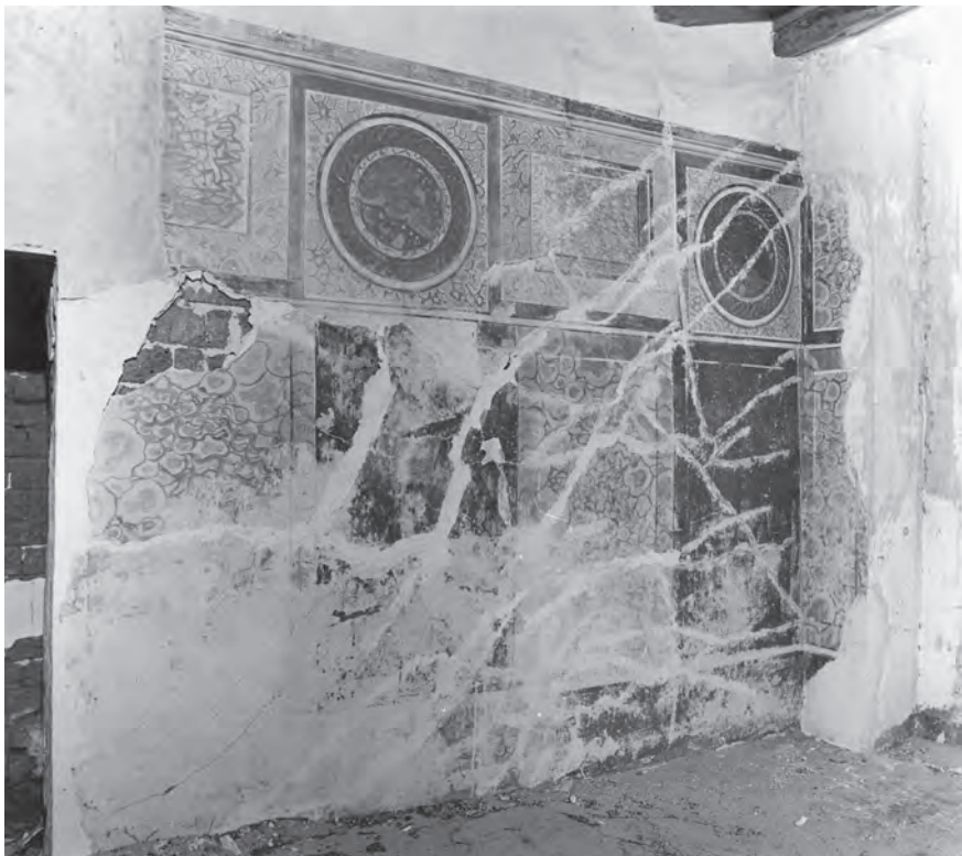
Abb. 3: GB 16, Obergeschoss, erster Raum, Westwand; 1973
