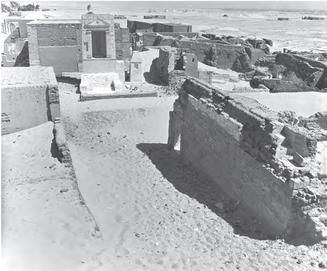
Abb. 23: Westfassade von Südwesten; 1973
