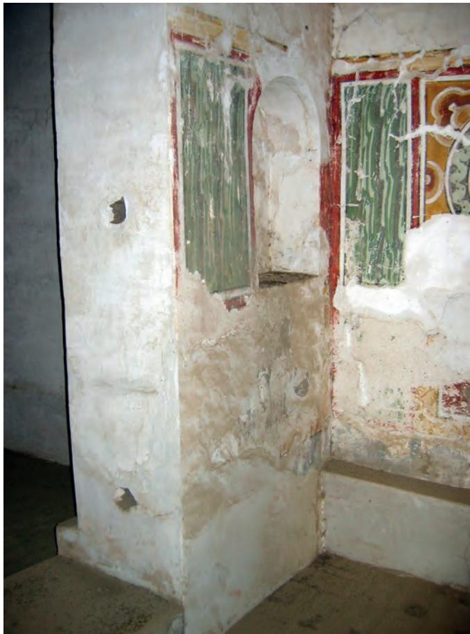
Abb. 16: GB 12, Obergeschoss, 1. Raum, westliche Südwand; 2006
