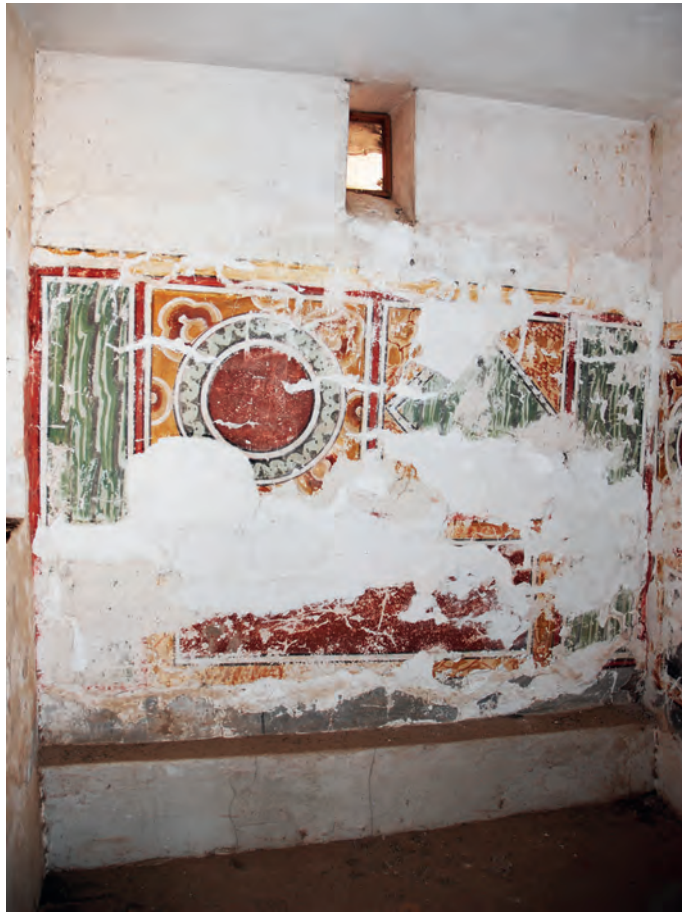
Abb. 15: GB 12, Obergeschoss, 1. Raum, Westwand; 2008
