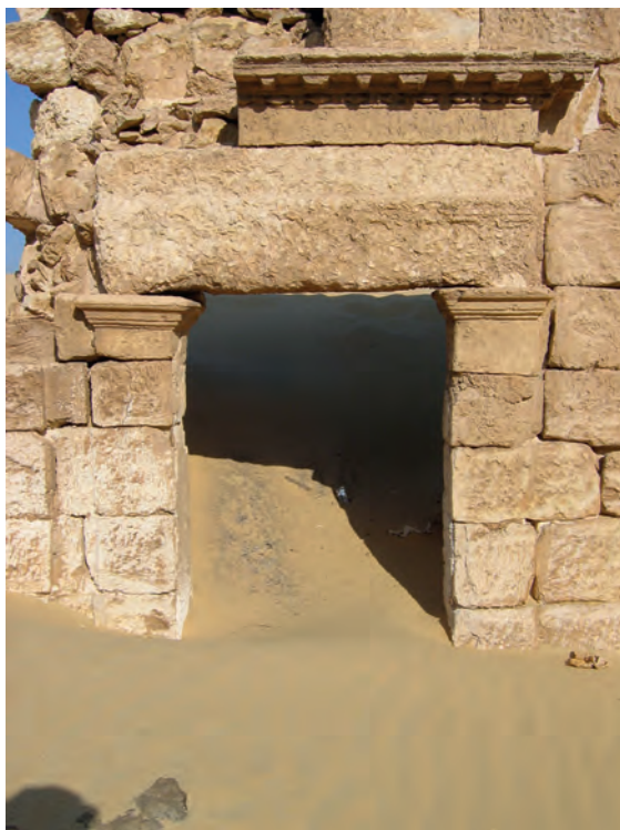
Abb. 11: Tür im nördlichen Bereich der Westwand; 2005
