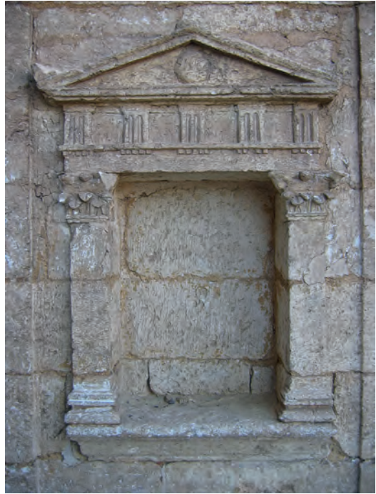
Abb. 9: GB 15, östliche Fassadennische; 2007
