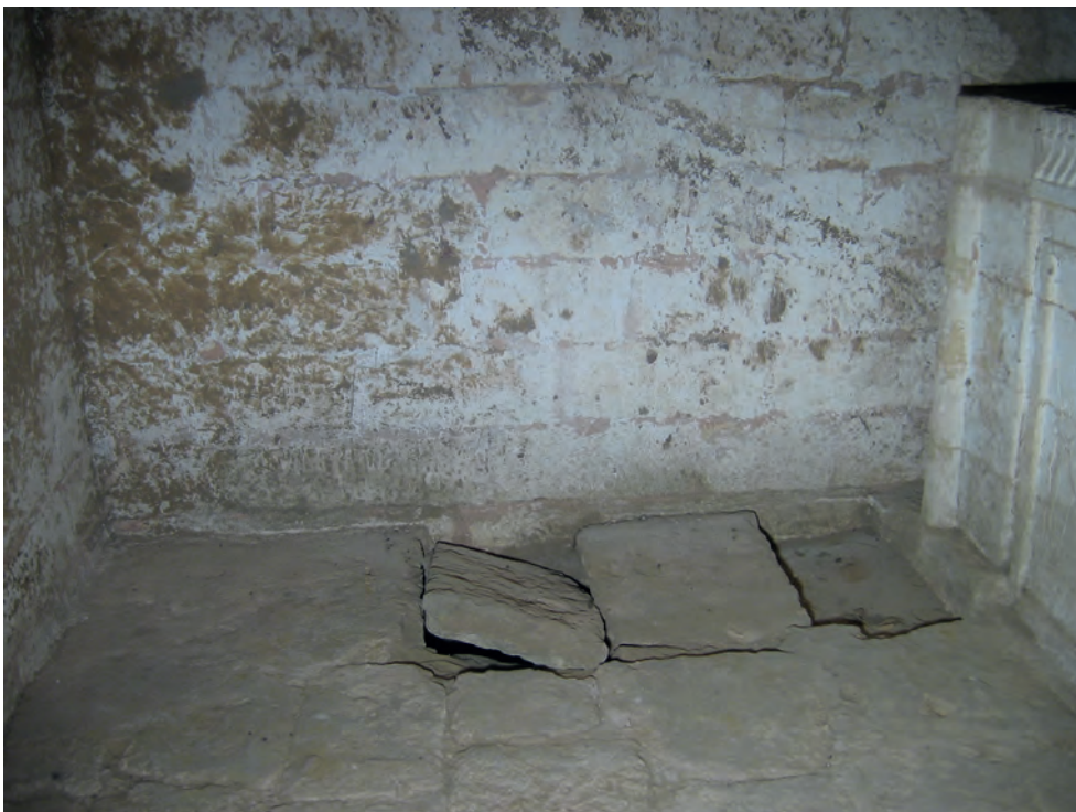
Abb. 15: GB 15, Innenraum, Ostseite mit Estrichresten und Grabgrube; 2007
