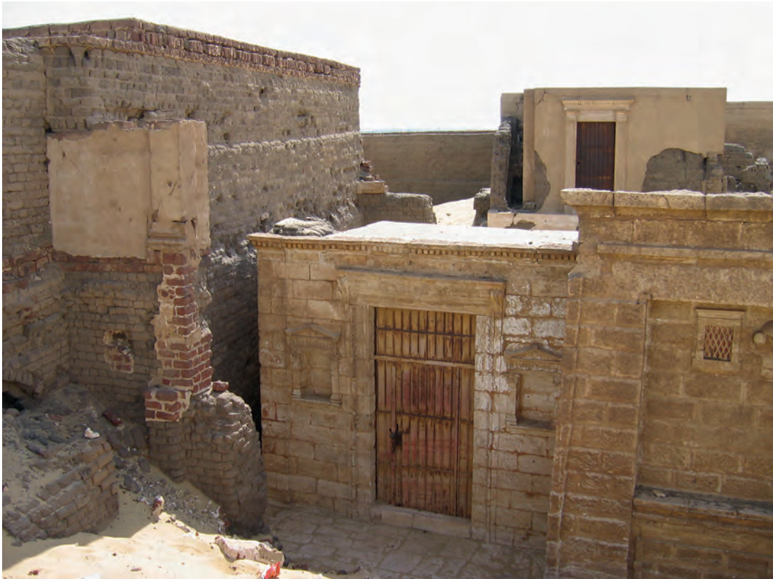
Abb. 1: GB 15, Fassade nach erneuter Freilegung; 2007
