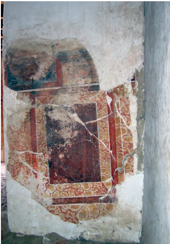
Abb. 41: GB 16, Obergeschoss, zweiter Raum, östliche Nordwand; 2005
