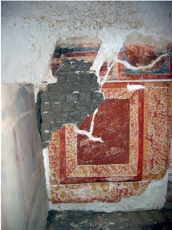
Abb. 40: GB 16, Obergeschoss, zweiter Raum, westliche Nordwand; 2005
