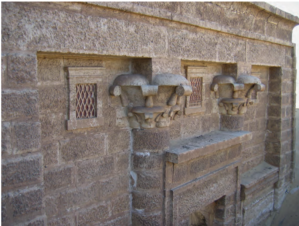
Abb. 4: Oberer Bereich der Fassade von Nordosten; 2007
