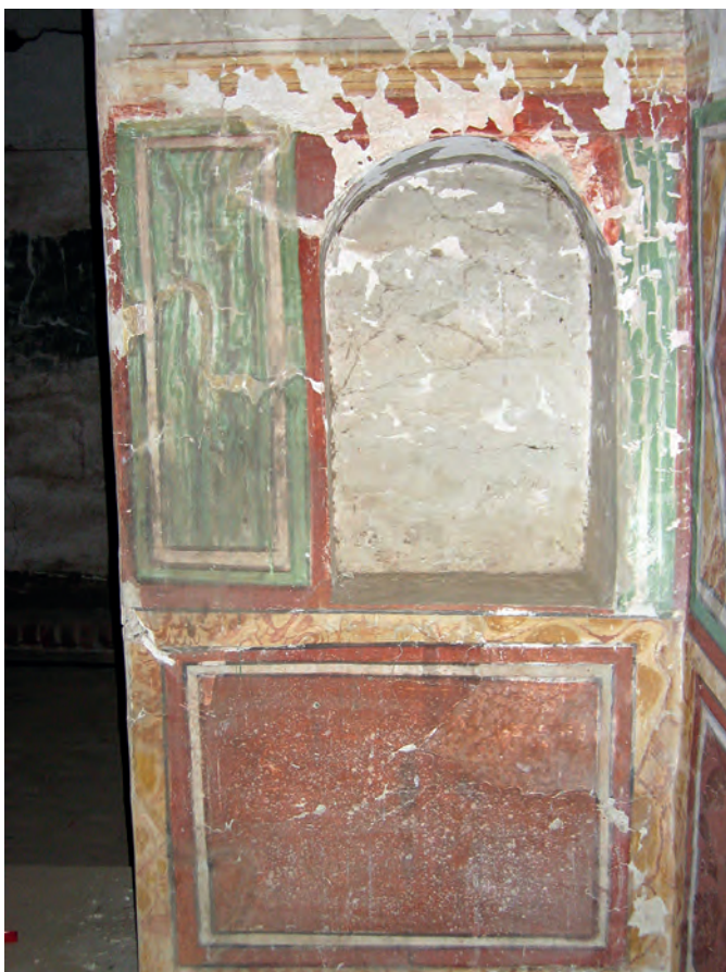
Abb. 9: GB 13, Obergeschoss, 1. Raum, westliche Südwand; 2006
