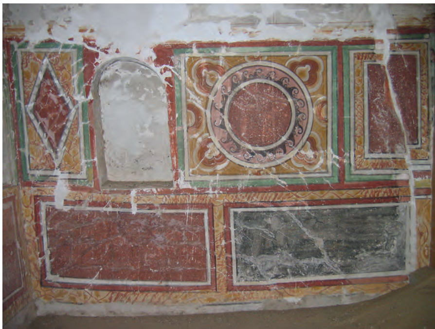
Abb. 8: GB 13, Obergeschoss, 1. Raum, Westwand; 2006
