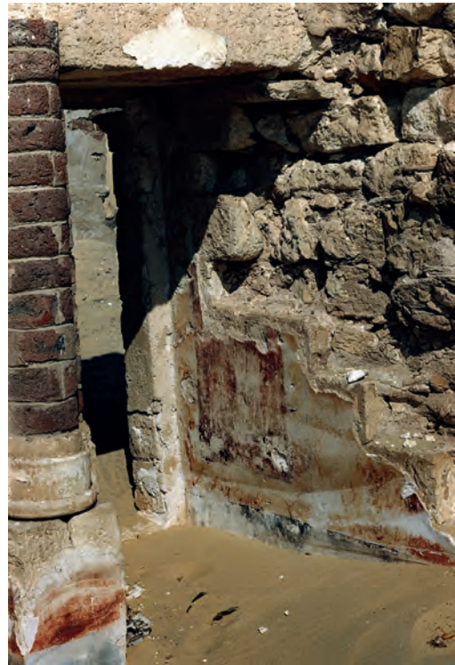
Abb. 12: Türbereich von Südosten; 1988
