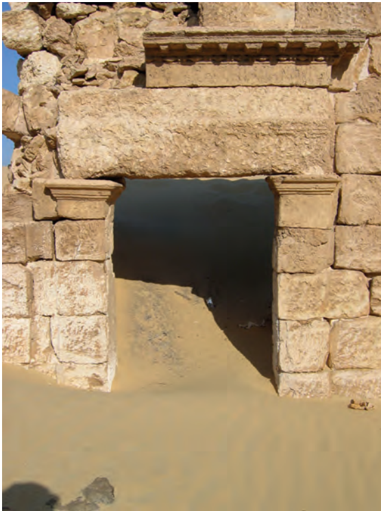
Abb. 11: Tür im nördlichen Bereich der Westwand; 2005
