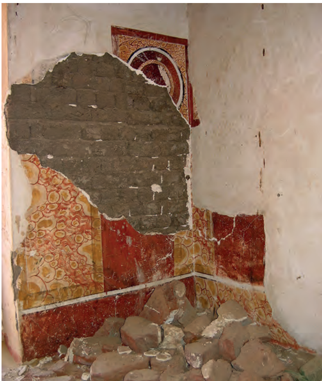
Abb. 33: GB 16, Obergeschoss, erster Raum, Nordostwand; 2005
