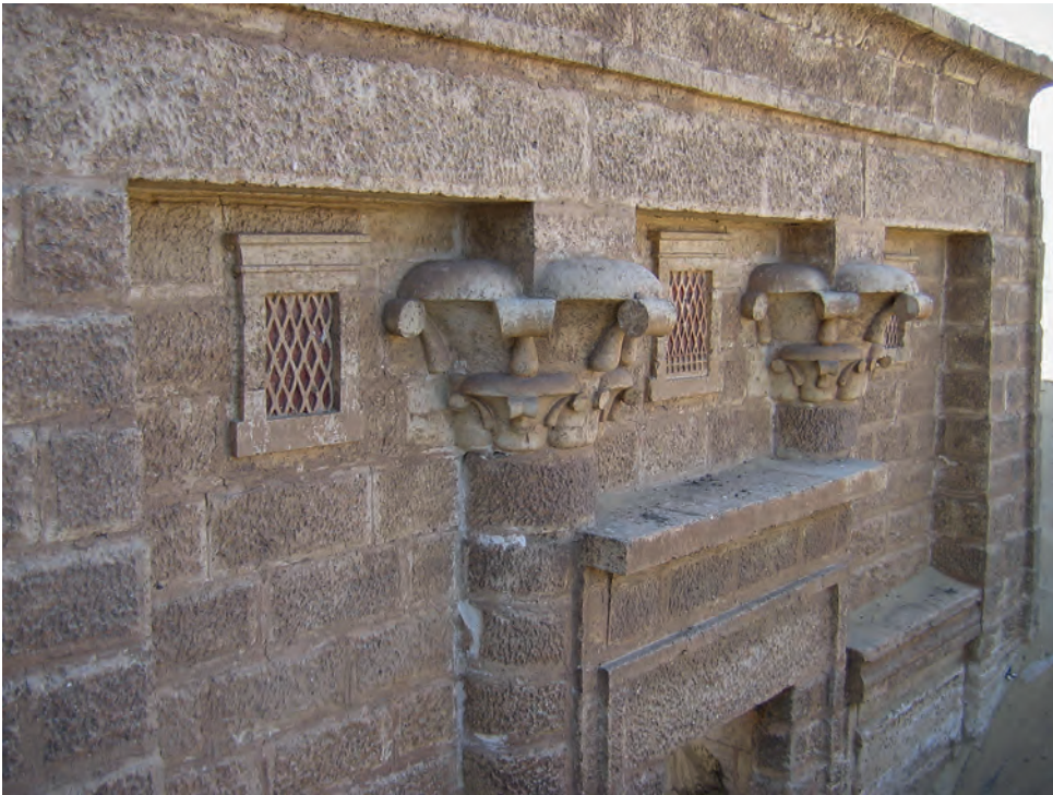
Abb. 4: Oberer Bereich der Fassade von Nordosten; 2007
