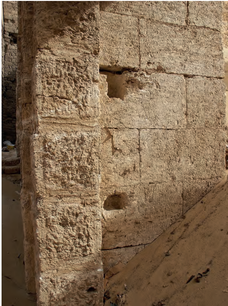
Abb. 12: Verriegelungslöcher in der Eingangstür (östliche Laibung); 2007
