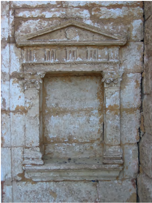
Abb. 8: GB 15, westliche Fassadennische; 2007
