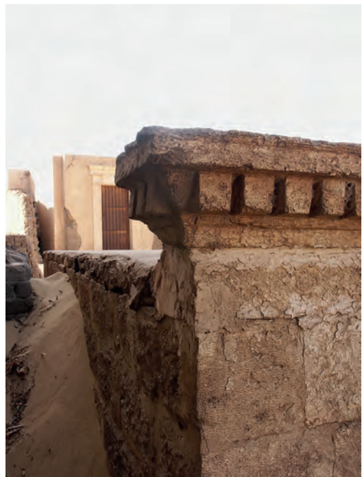
Abb. 11: GB 15, Nordostecke mit Zahnschnitt; 2007
