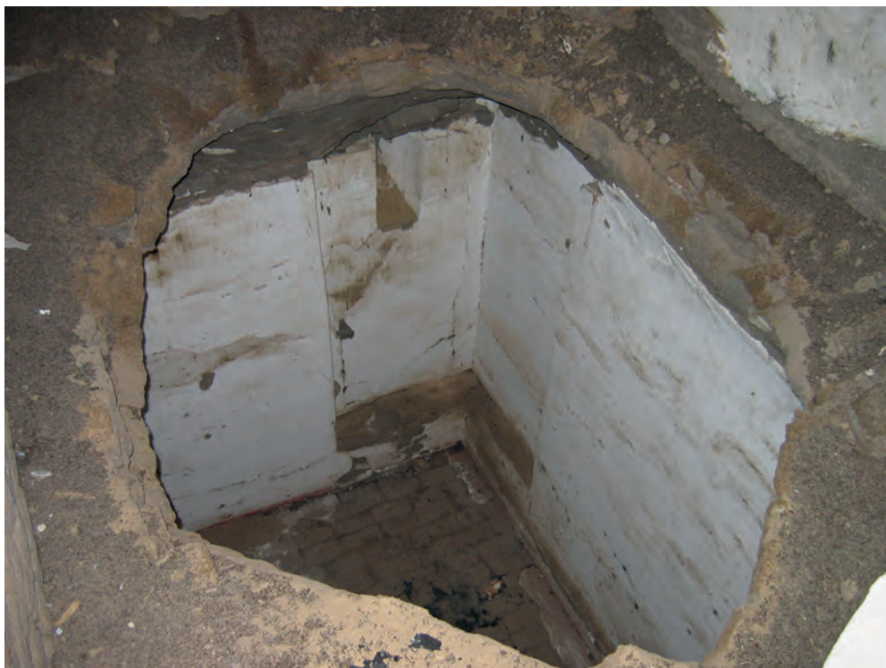
Abb. 25: GB 11, Untergeschoss, Raum; 2007
