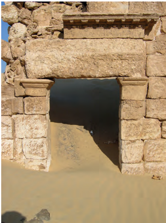
Abb. 11: Tür im nördlichen Bereich der Westwand; 2005
