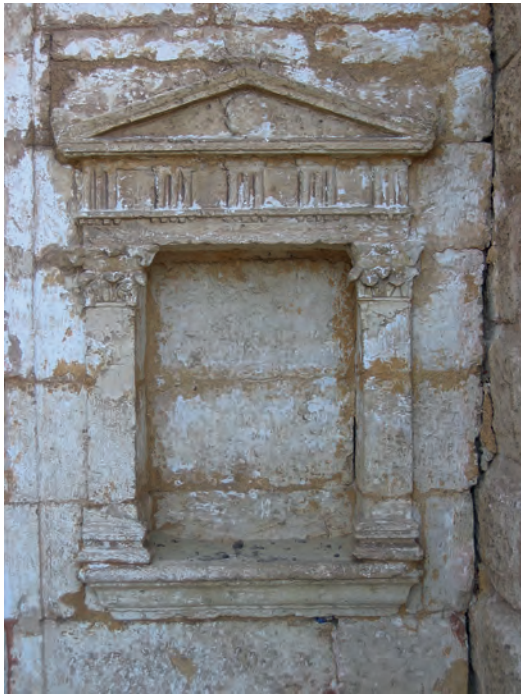
Abb. 8: GB 15, westliche Fassadennische; 2007
