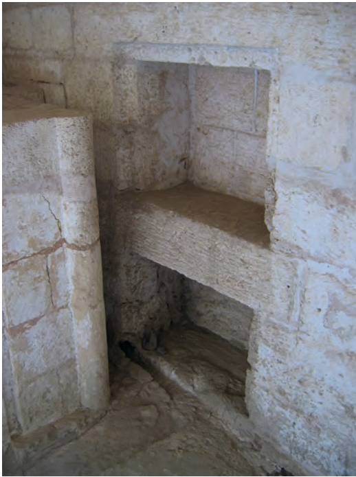
Abb. 16: GB 15, Innenraum, Westseite mit zwei übereinanderliegenden Nischen; 2007
