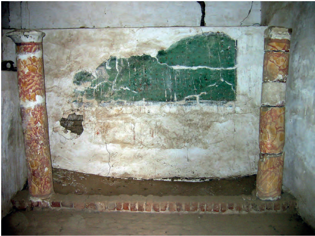
Abb. 12: GB 13, Obergeschoss, 2. Raum, Südwand mit Hauptgrablege; 2006
