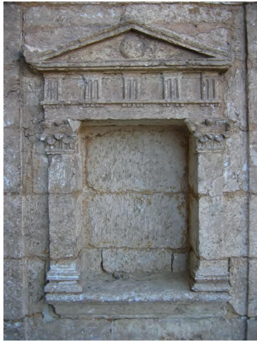
Abb. 9: GB 15, östliche Fassadennische; 2007
