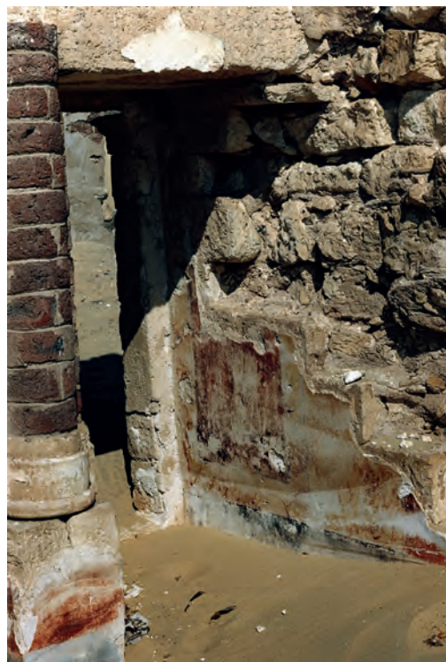
Abb. 12: Türbereich von Südosten; 1988
