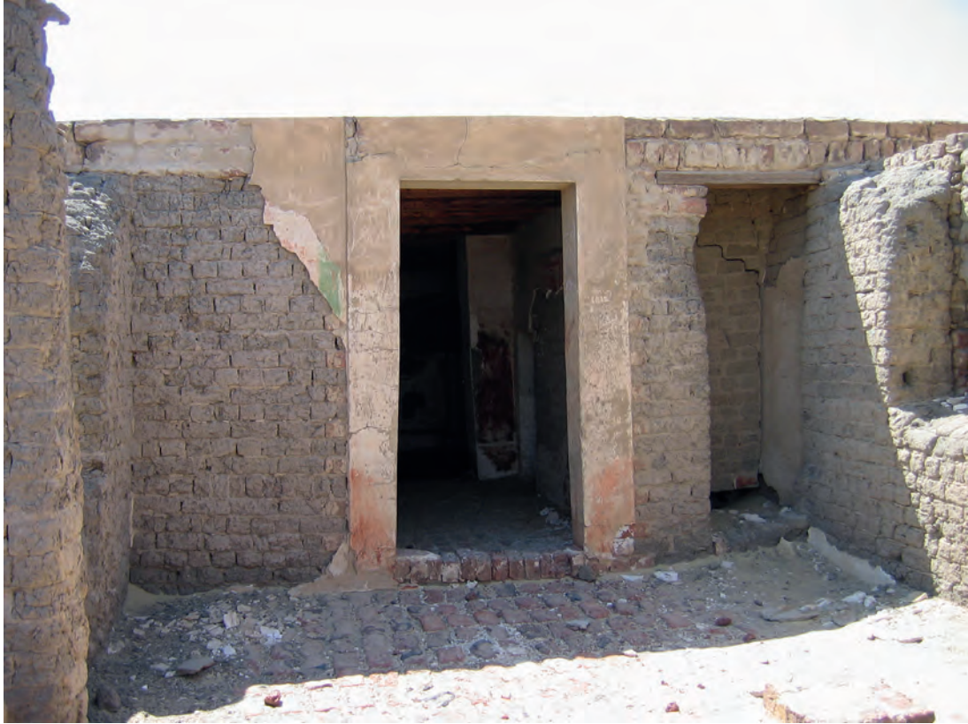
Abb. 1: GB 16, Ansicht des Obergeschosses mit Vorhalle; 2005
