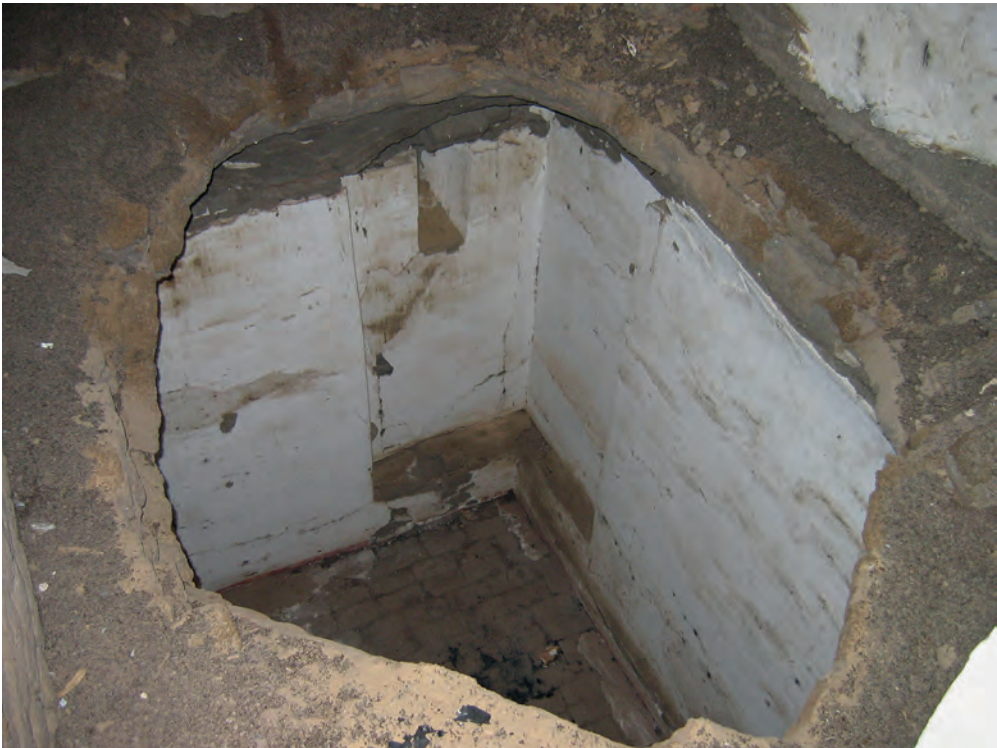
Abb. 25: GB 11, Untergeschoss, Raum; 2007
