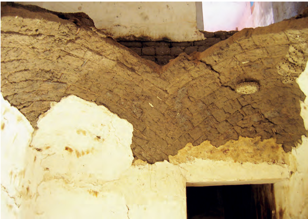
Abb. 26: GB 11, Untergeschoss, Raum mit Gewölbeansatz; 2007
