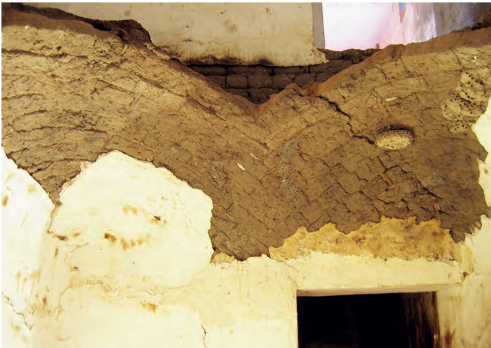
Abb. 26: GB 11, Untergeschoss, Raum mit Gewölbeansatz; 2007
