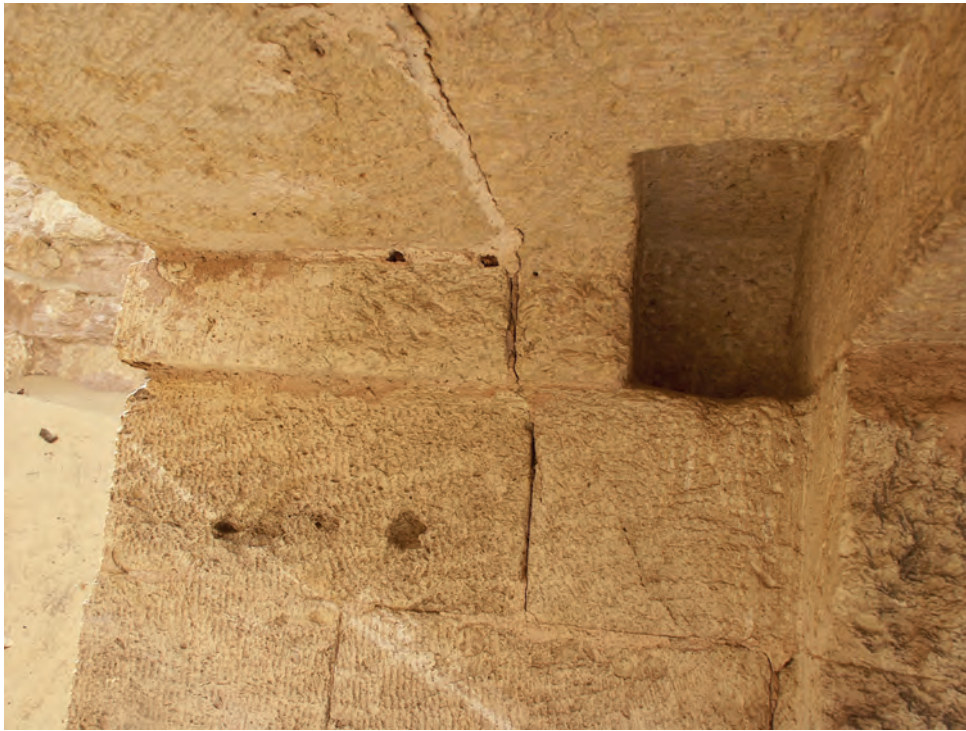
Abb. 13: Angelloch in der westlichen Ecke des Türsturzes; 2007
