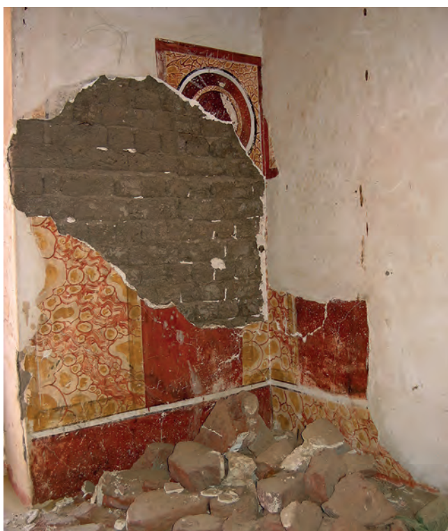
Abb. 33: GB 16, Obergeschoss, erster Raum, Nordostwand; 2005
