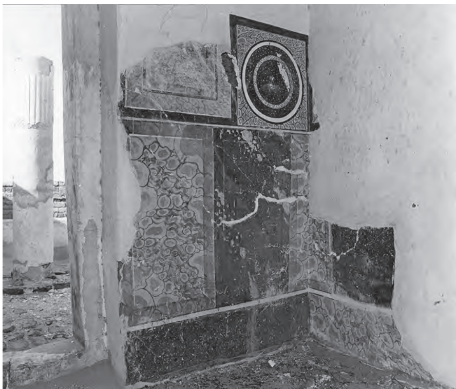
Abb. 32: GB 16, Obergeschoss, erster Raum, Nordostwand; 1973
