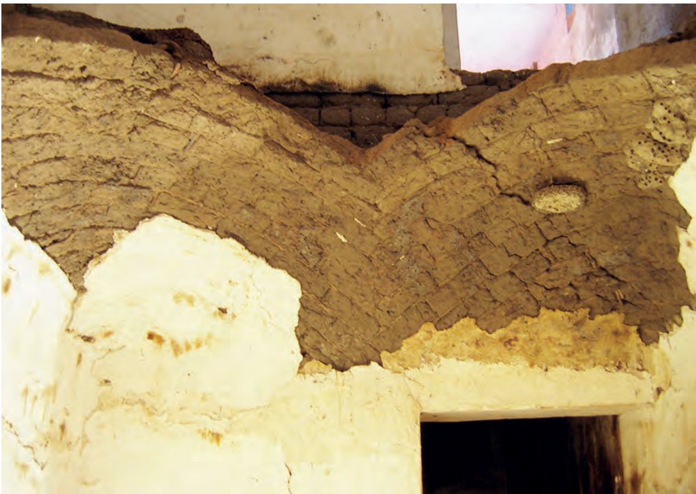
Abb. 26: GB 11, Untergeschoss, Raum mit Gewölbeansatz; 2007
