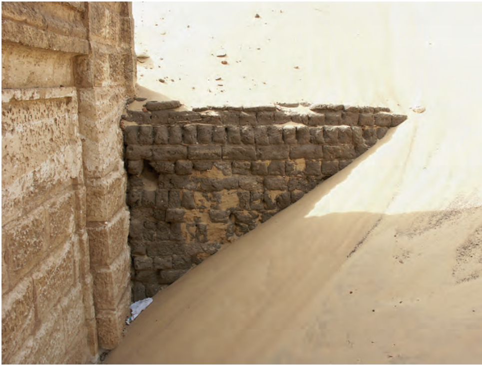
Abb. 14: Nordwestecke der Fassade mit angebauter Lehmziegelmauer; 2007
