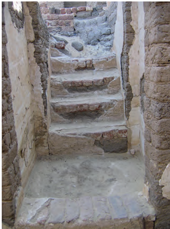
Abb. 21: GB 17, Treppe auf die Terrasse; 2006
