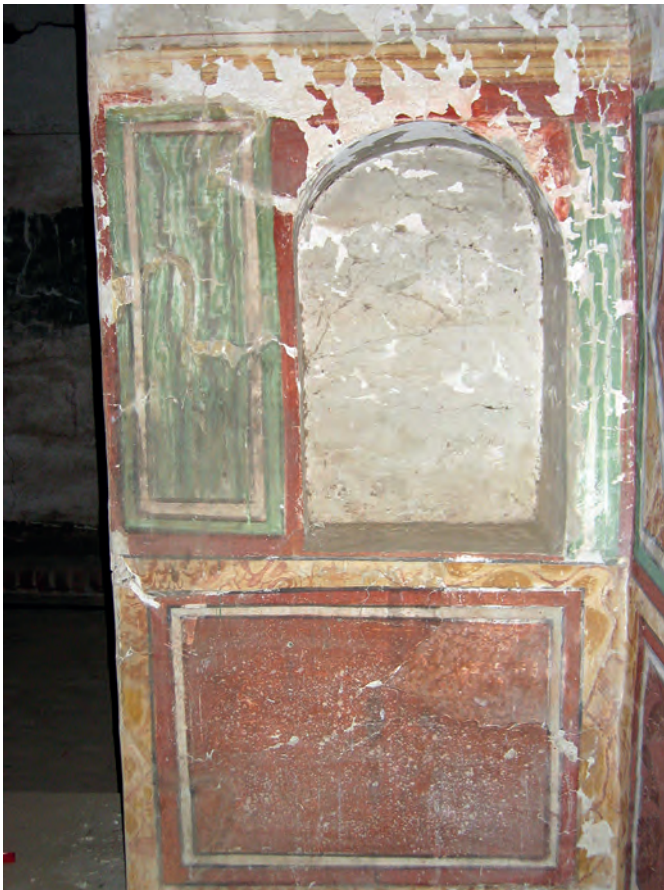
Abb. 9: GB 13, Obergeschoss, 1. Raum, westliche Südwand; 2006
