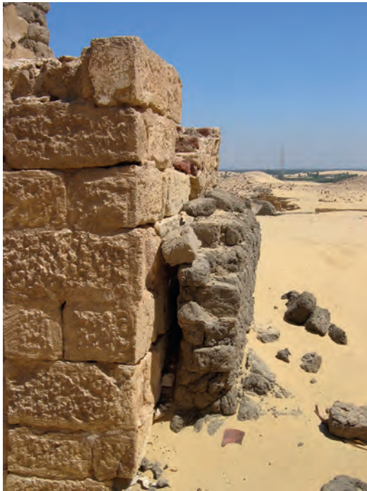
Abb. 9: Mauer aus ungebrannten Ziegeln vor der Südwand; 2005
