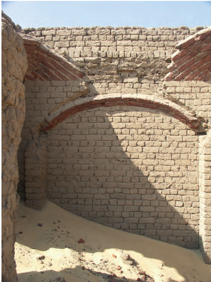
Abb. 12: GB 200.2.2, Westwand, Grablege mit Baldachinkonstruktion in Raum; 2010
