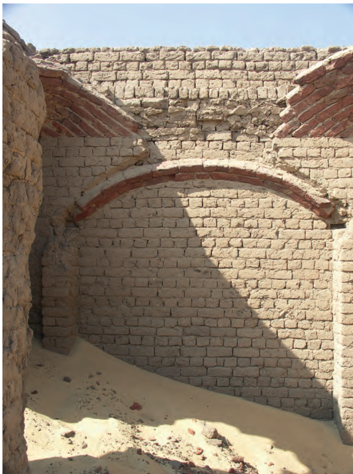
Abb. 12: GB 200.2.2, Westwand, Grablege mit Baldachinkonstruktion in Raum; 2010
