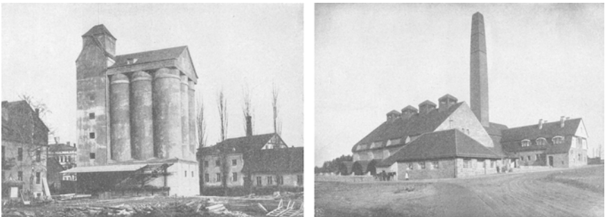
Abb. 20 Beispiele für im Sinne des »Bundes Heimatschutz« gelungene Lösungen moderner Bauaufgaben (aus: Schultze-Naumburg 1905). Maschinenzentrale in Bad Nauheim (links); Getreide-Silo in Landshut (rechts)
