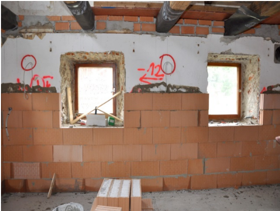
Bild 8: Beispiel eines kondensattolerierenden Innendämmsystems [Quelle: Fa. Schlagmann Baustoffwerke GmbH & Co. KG, Zeilarn]
