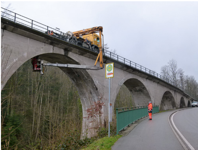
Abb. 1: Bauwerksprüfung
