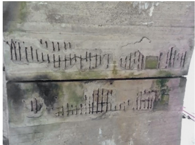
Abb. 2: Bogen 6; Scheitel – freiliegende Gelenkbewehrung
