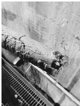
Bild 6: Ablagerungen auf dem Schutzrohr
