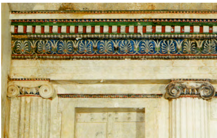
Abb. 15: Vergina, Sogenanntes Grab der Eurydike, Innenfassade, Detail
