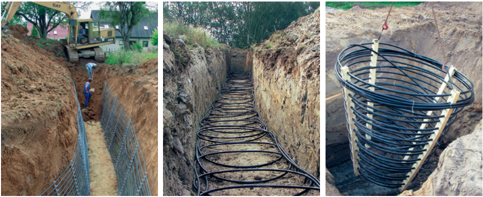
■ Abb. 43: Ausführungsbeispiele für verschiedene Sonderbauformen von Erdkollektoren: Grabenkollektor, Künnettenkollektor, Erdkorb (von links nach rechts)
