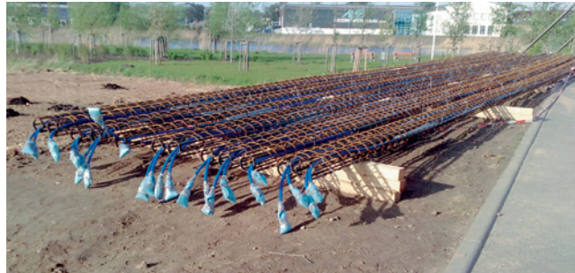
■ Abb. 45: Ausführungsbeispiele für Energiepfähle
