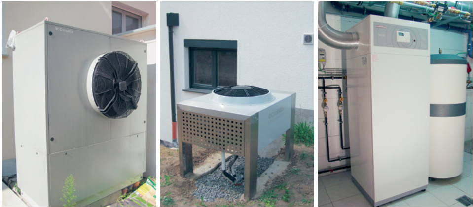
■ Abb. 51: Varianten verschiedener Aufstellungen von Luft/Wasser-Wärmepumpen. Links: außen aufgestelltes Gerät mit integriertem Heizungsanschluss. Mitte: Split-Wärmepumpe mit vertikal durchströmtem Verdampfer. Rechts: Innenaufstellung eines Lüftungsgerätes mit integrierter Wärmepumpe zur Trinkwarmwassererzeugung.
