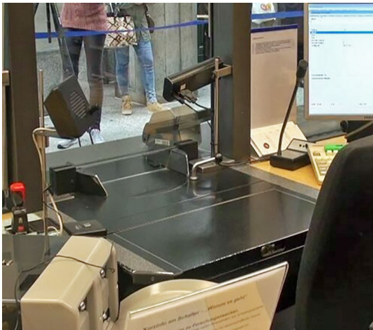
Abb. 24: Drehscheibe mit Hebel als Durchreich- und Austauschvorrichtung (Quelle: Hausendorf und Mondada 2017)
