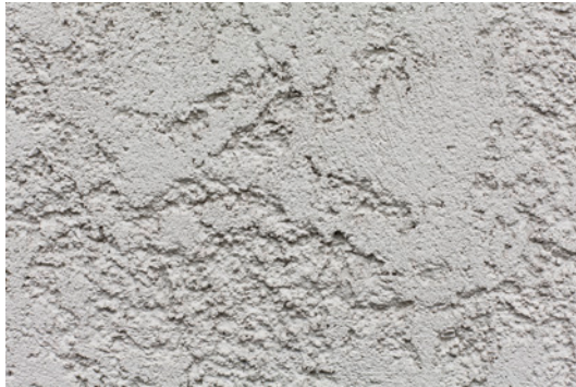
Bild 5: Nesterputz (Rajasil EP WD Altdeutscher Putz mittel) Kornbereich: 0–3,2 mm Putzdicke: ca. wie Größtkorn
