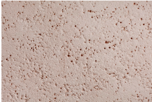
Bild 14: Besenstipp (Rajasil EP WD Scheibputz fein) Kornbereich: 0–1,5 mm Putzdicke: 3–4 mm
