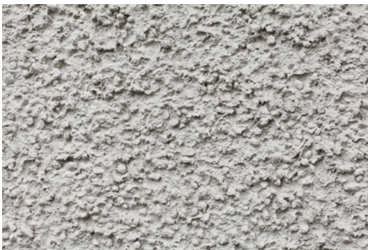
Bild 9: Kellenwurf (Rajasil EP WD Kellenwurf grob) Kornbereich: 0–8 mm Putzdicke: 3–10 mm
