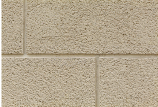
Bild 10: Nutenputz (Quaderung) (Rajasil Sanierputz 035 zum Kratzen) Kornbereich: 0–3,5 mm Putzdicke: ca. 15 mm Einzelne feine Haarrisse in den Nuten – nur bei Nahansicht erkennbar –, die aber nicht in den Armierungsputz übertagen werden.
