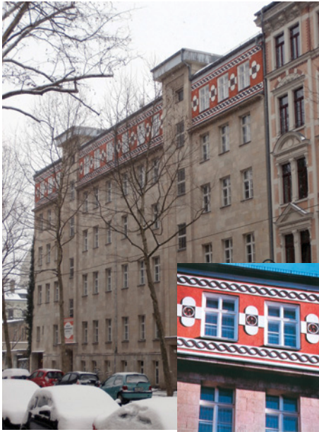
Bild 15: Gesamt- und Teilansicht des Gebäudes Leipzig, Feuerbachstraße 17/17 a. Die Putzfassade des obersten Geschosses hat folgenden Aufbau: 80 mm Mineralwolle, gewebearmierter Grundputz, Oberputz mit mineralischem Edelputz (P 1c). Putzweise Kratzputz mittelfein in Rot und Schwarz. Die weißen Bereiche in den Ornamenten wurden mit mineralischem Renovierputz behandelt.
