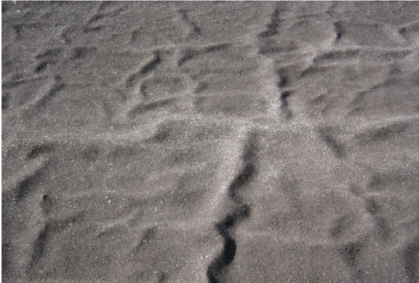
Bild 41: Beispiel für die Verbindung zweier Stoffe mit sehr unterschiedlichen hygrothermischen Eigenschaften und geringem Haftverbund: Dachpappe auf Holzschalung mit einem Bitumenkleber verbunden
