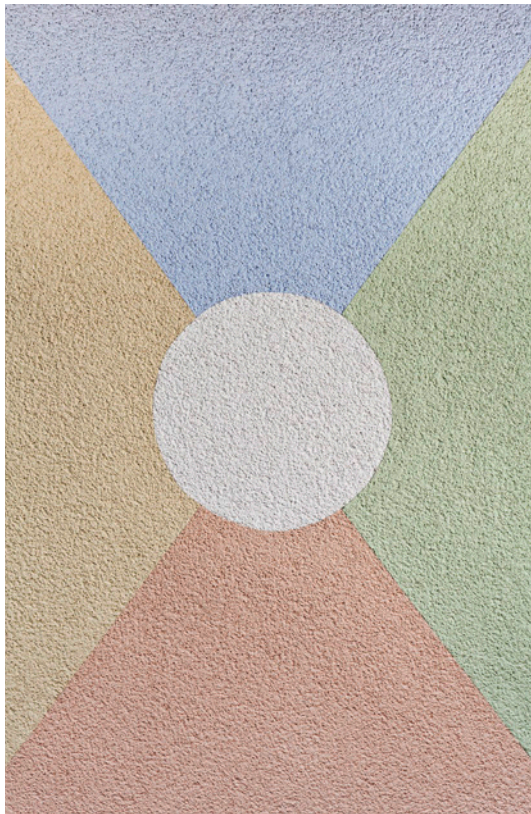
Bild 3: Intarsien Kratzputz, Gesamtansicht (Rajasil EP WD) Kratzputz mittel) Kornbereich: 0–4 mm Putzdicke: ca. 10 mm
