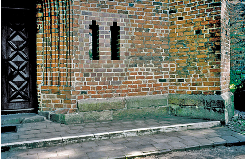
Bild 7: Fundamentbereich der aus Ziegelmauerwerk um 1250 erbauten St. Marienkirche in Parchim/Mecklenburg. Als Sperrschicht gegen aufsteigende Feuchte dienten großformatige Granitsteine.
