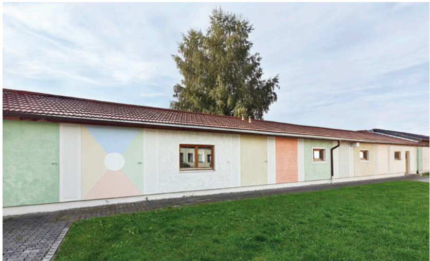
Bild 1: Ansicht des ehemaligen eingeschossigen Versuchsbaus mit verschiedenen historischen Putzweisen auf EPS-Hartschaum (WDV-System)
