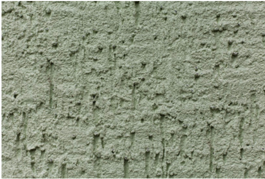
Bild 8: Ziehputz (Rajasil EP WD Altdeutscher Putz mittel) Kornbereich: 0–3,2 mm Putzdicke: ca. wie Größtkorn
