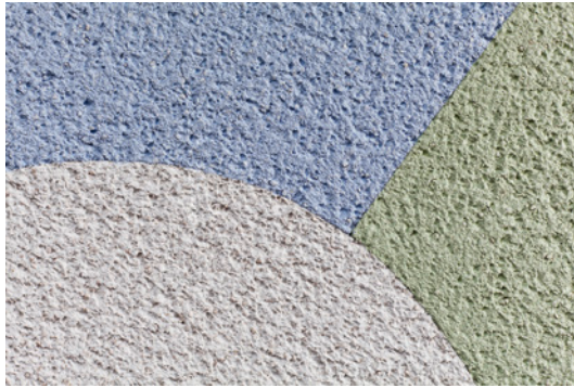
Bild 4: Intarsien Kratzputz, Detailansicht Der Kratzputz war eine beliebte Oberflächenstruktur, weil durch das Kratzen die bindemittelreichere und daher schwindanfällige Außenschicht abgetragen wurde.
