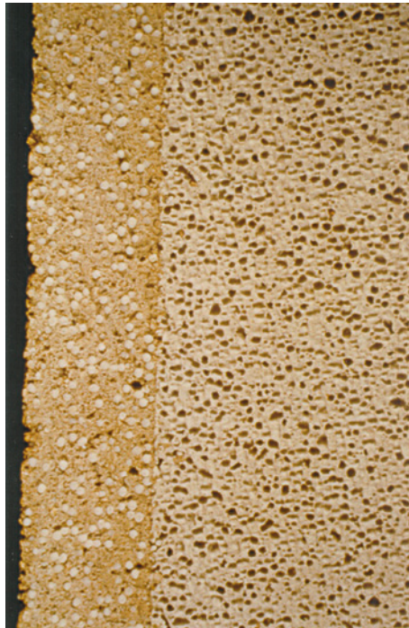
Bild 11: Schnitt durch Porenbeton mit aufgebrachtem Leichtputz. Die Strukturähnlichkeit zwischen dem Putzgrund Porenbeton und dem Putz ist optisch erkennbar.
