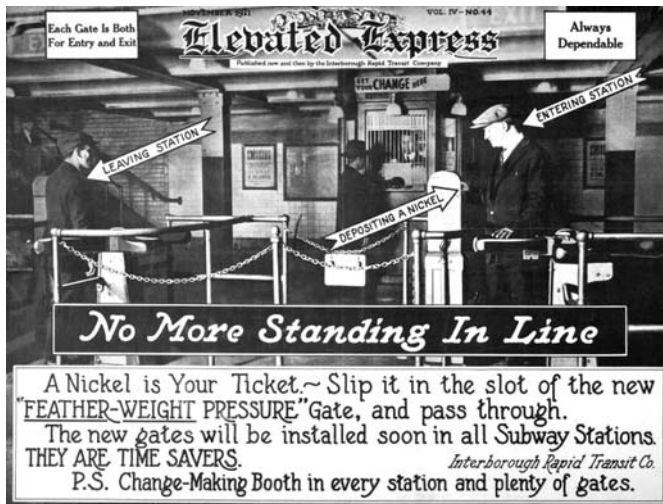
Abb. 4: Aushang vom November 1921, der den Passagieren der Subway den richtigen Umgang mit den Drehkreuzen beibringen sollte. Quelle: Elevated Express, 4/44 (NYTMA: File: Poster Collection: Elevated Express/Subway Sun)
