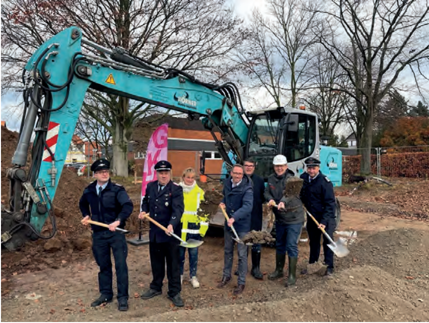
Abb. 9: Feuerwehren im ländlichen Raum sind nicht frei von Zukunftssorgen. Rheden, ein Ortsteil der Stadt Gronau im Landkreis Hildesheim, kann sich jedoch über ein neues Feuerwehrhaus freuen (Foto: kwg)
