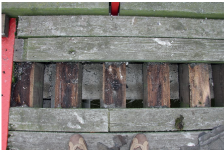
Abb. 23: Balken unter der Pappe
