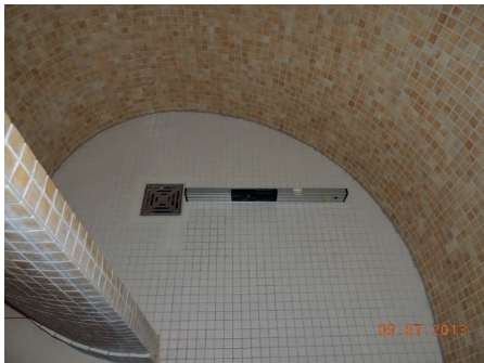
Bilder 4 und 5: Bodenfläche in der Dusche des Saunabereichs eines Hotels: Statt des erforderlichen Gefälles von 3 % betrug das Bodengefälle nur 1,2 %.
