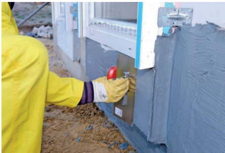
Bild 6: Abdichtung Türanschluss Reaktivabdichtung weber.tec Superflex D 24 [4]
