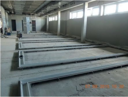
Bild 11: Über 350 m 2 großer, zu einer Waschkäue (Neubau) gehörender Duschbereich mit den bereits eingebauten Bodenrinnen vor Einbau des Verbundestrichs
