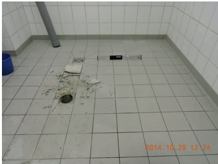
Bilder 2 und 3: Bodenfläche in der Dusche eines öffentlichen Schwimmbads: Statt des erforderlichen Gefälles von 3 % betrug das Bodengefälle nur 0,7 %.
