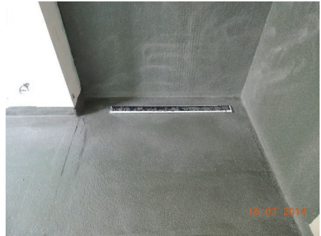
Bilder 25 und 26: Einbau der vliesarmierten Reaktionsharzabdichtung Kemperol 2K-PUR in einem Wohnungsbad mit bodengleicher Dusche
