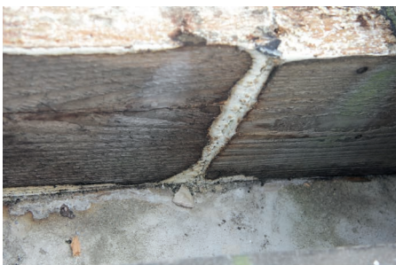
Abb. 25: Pilzmyzel an der Stoßstelle
