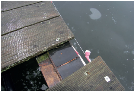
Abb. 12: abgesehen von der Breite der Folie auch keine Überlappung
