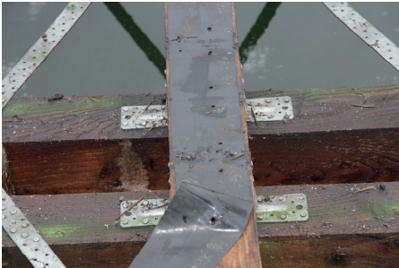
Abb. 6: Mauersperrbahn zwischen Belag und Träger, zu schmal und durchbohrt
