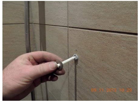
Bilder 53 und 54: Details des Rahmendübels und der Unterlegscheibe sowie des anschließenden Einbaus (1)
