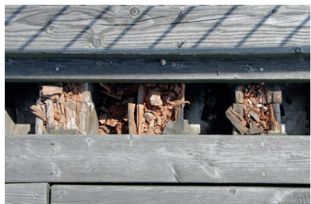
Abb. 26: Völlige Zerstörung am Stoß
