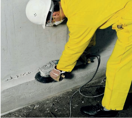
Bild 7: Untergrundvorbereitung Bodenplatte fräsen [4]
