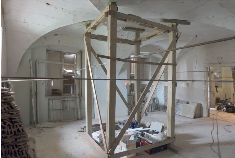
Bild 4: Heutiger Zustand innen im Erdgeschoss mit Stützkonstruktionen und Verspannungen auf Augenhöhe
