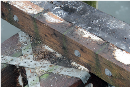
Abb. 10: keine Abdeckung der Querträger und Pfahlköpfe, alles stumpf miteinander verbunden
