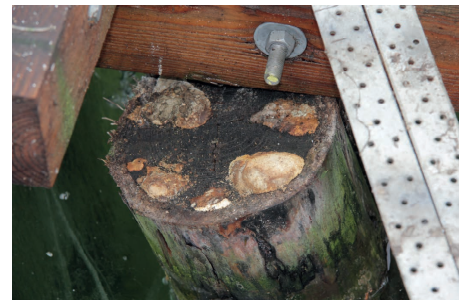
Abb. 9: üppiger Pilzbewuchs auf den ungeschützten Pfahlköpfen
