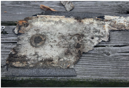
Abb. 27: Pilzmyzel unter der Pappe
