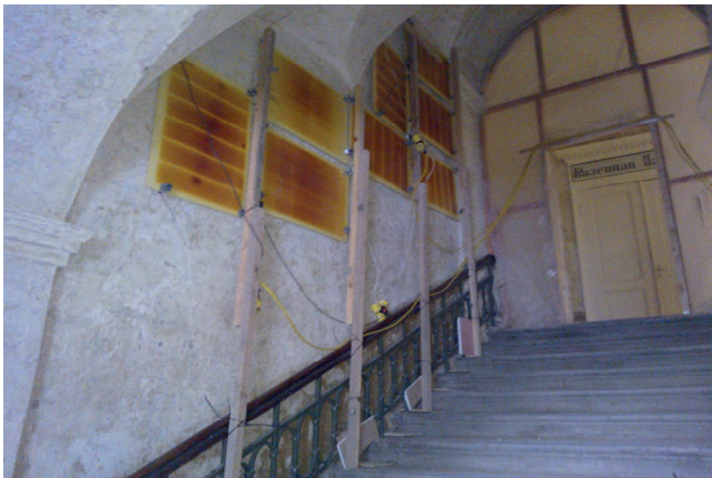
Bild 13: Infrarottrocknung im Treppenhaus
