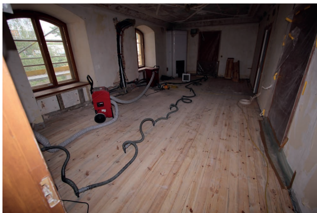
Bild 14: Trocknung der Holzbalkenlagen
