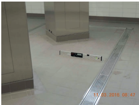
Bilder 12 und 13: Fertiggestellte Bodenflächen der Waschkäue im Duschbereich mit ausreichendem Gefälle: Bei der Ausführung hielt man sich an die Regeln für nassbelastete Barfußbereiche, welche für Duschen ein Gefälle von mindestens 3 % fordern.
