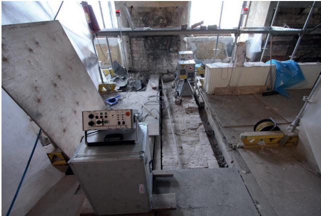
Bild 12: Mikrowellentrocknung des Mauerwerks
