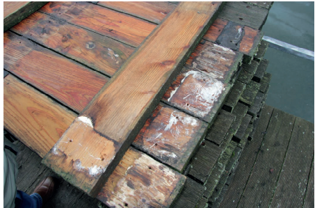
Abb. 7: Resultat: Weißer Porenschwamm und Braunftäule an den Bohlen
