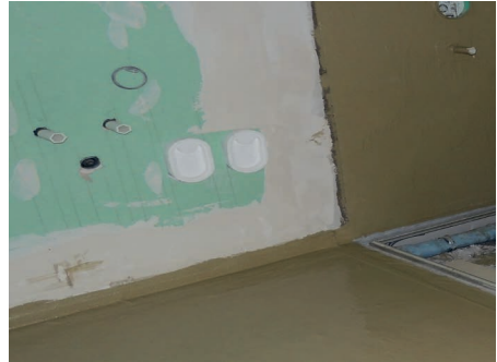
Bilder 43 und 44: Einbau von Verstärkungseinlagen einer vliesarmierten Reaktionsharzabdichtung im Bereich von Wandabschnitten bei indirekter Beanspruchung des Bodens in einem Wohnungsbad
