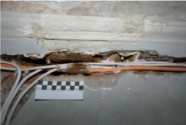
Bild 17: Ausbreitung des EHS im Kabelkanal
