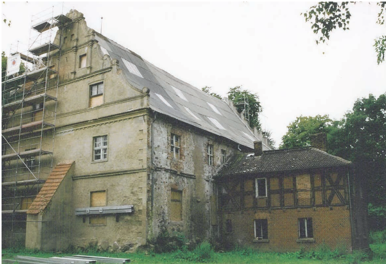
Bild 3: Zustand 2002 kurz vor Abbruch der Maßnahmen. Im Erdgeschoss werden gerade die Notverspannungen montiert. Im Vordergrund liegen noch Stahlträger für die übrigen Fenster bereit. Nachfolgend wurde noch der Küchenanbau des 19. Jahrhundert abgebrochen und das Dach der Nordseite neu gedeckt
