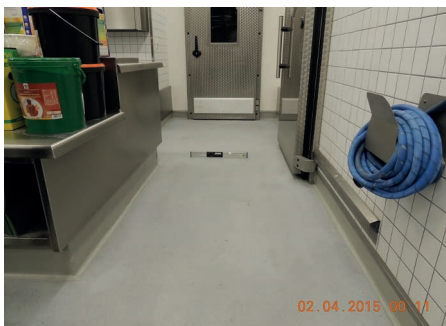
Bilder 6 und 7: Mit einer Beschichtung (keine Abdichtung!) versehene Bodenfläche in der Großküche eines Bürogebäudes: Entgegen [5] und [7] wurde ein Gefälle weder geplant noch ausgeführt.
