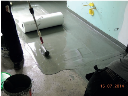
Bilder 25 und 26: Einbau der vliesarmierten Reaktionsharzabdichtung Kemperol 2K-PUR in einem Wohnungsbad mit bodengleicher Dusche
