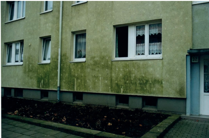
Bild 1: WDVS-Fassade mit Algenbewuchs und sich abzeichnenden Dübelköpfen
