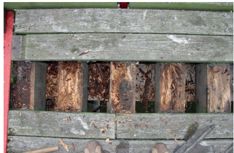
Abb. 24: Balken nach dem Bebeilen
