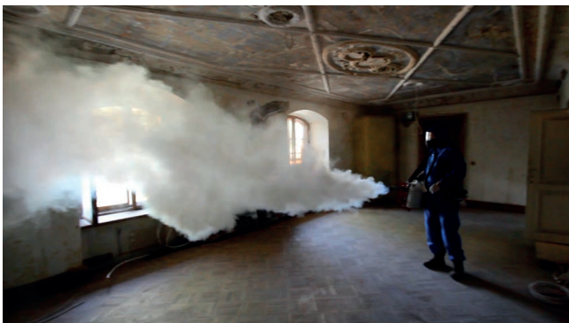
Bild 7: Fogging zur Schimmelbekämpfung
