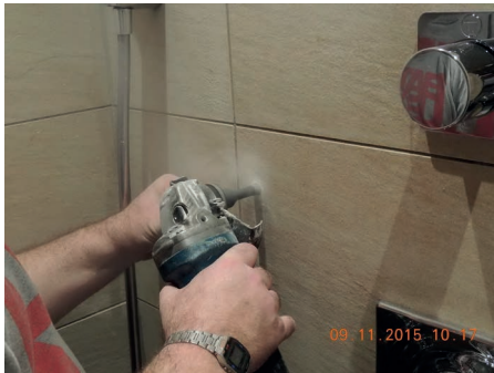
Bilder 49 und 50: Für die erste Bohrung kam eine Diamant-Fliesen-Trockenbohrkrone zum Einsatz. Für die zweite Bohrung reichte ein normaler, für mineralische Untergründe geeigneter Bohrer.
