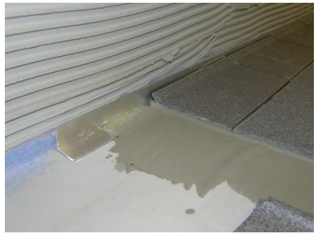
Bilder 35 und 36: Beispiele eines eingebauten Schutzstreifens in Verbindung mit einem schwimmenden Estrich (linkes Bild; © Architekt 2011) und eines Schutzwinkels in Verbindung mit einem Verbundestrich (rechtes Bild)
