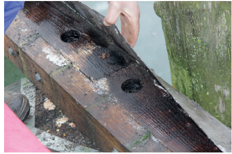
Abb. 11: und unter der Abdeckung eine ungeschützte Holzverbindung und tief versenkte Schraubenköpfe
