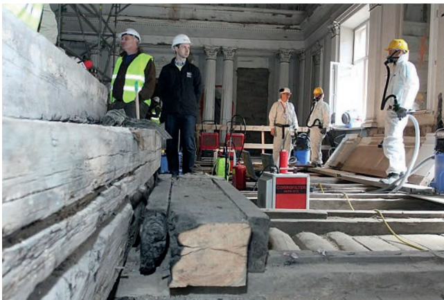
Bild 9: Absaugen der Schimmelsproren in der weißen Halle
