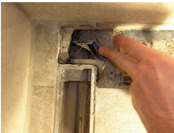
Bild 1: Dichtband einer AIV ohne jeden Verbund mit dem nur ca. 15 mm breiten Flansch einer Duschrinne
