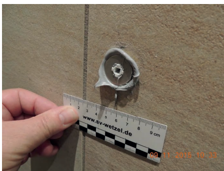
Bilder 57 und 58: Fertig eingebauter Rahmendübel
