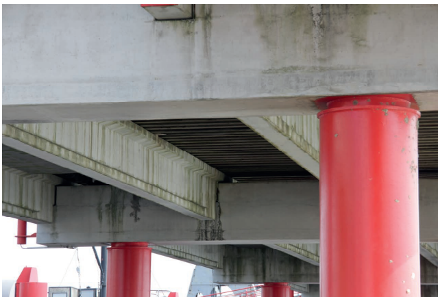
Abb. 17: Ansicht von unten mit Joch, Stahlbetonträger und Holzbalken
