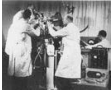
Abbildung 12: Anordnung zur Zeitdehnungsaufnahme mit 3.000–4.000 B/s, 1963
