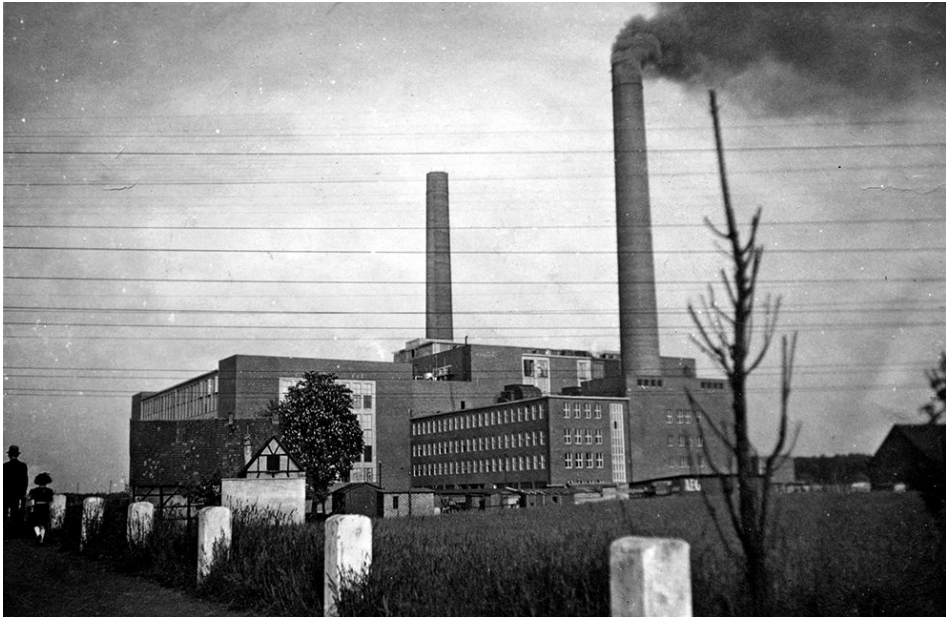
Abb. 27: Das Steag-Kraftwerk Lünen, 1940 234
