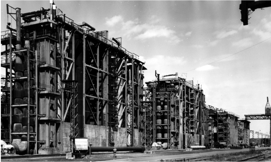
Abb. 18: Die Kammerstraße des Hydrierwerks Scholven, 1938 202
