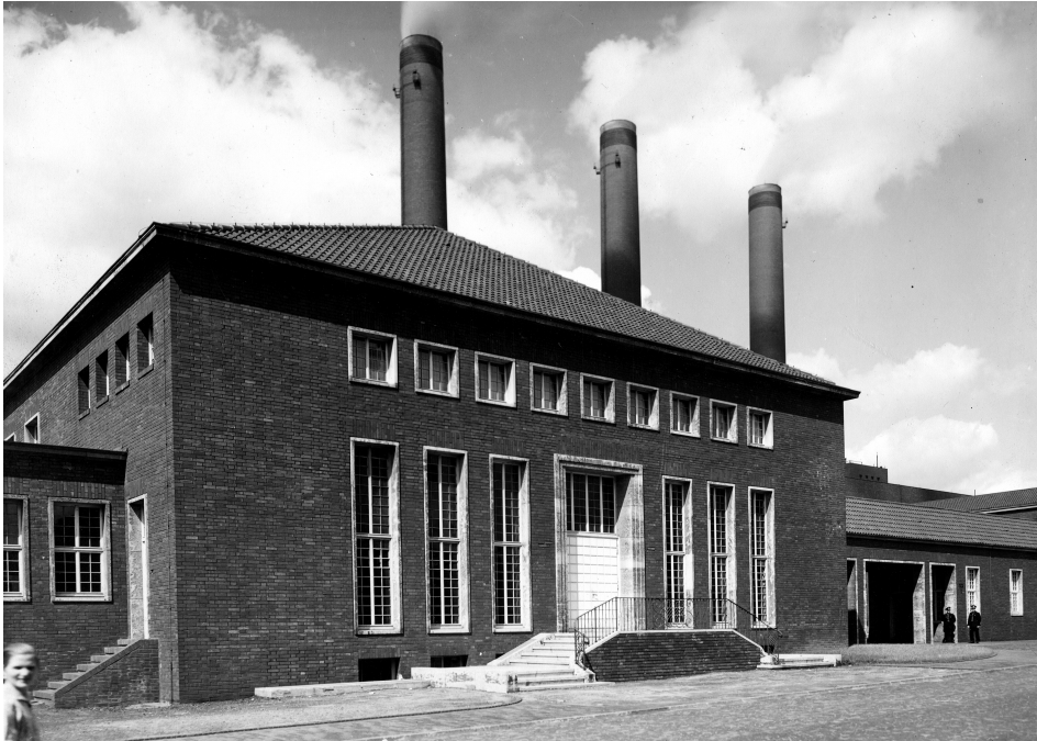
Abb. 20: Eingang und Belegschaftshaus des Hydrierwerks der Gelsenberg Benzin AG, 1940 208
