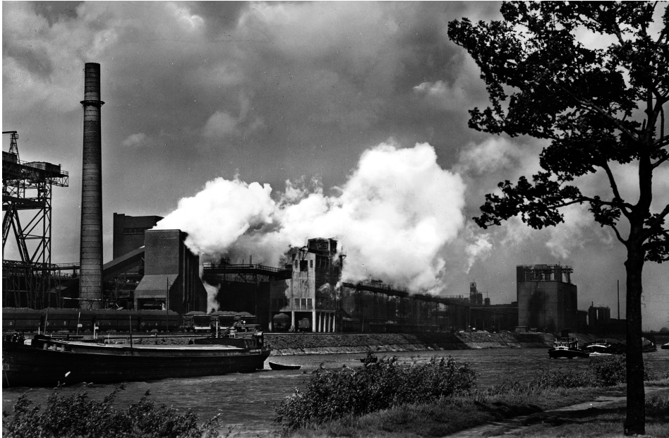
Abb. 9: Löschwolken über der Großkokerei Nordstern in Gelsenkirchen 1955 137
