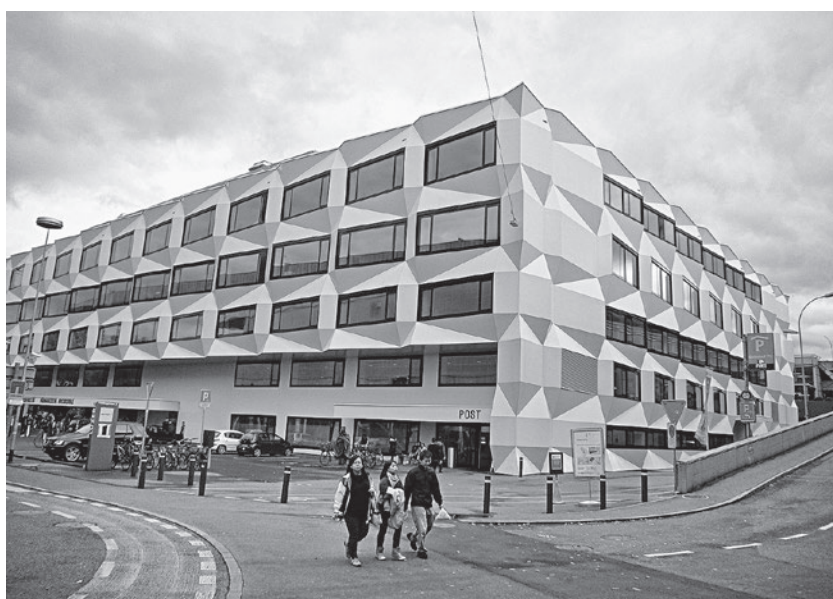
Abb. 10: Uni/PH Luzern: Die neue Fassade des ehemaligen Postgebäudes
