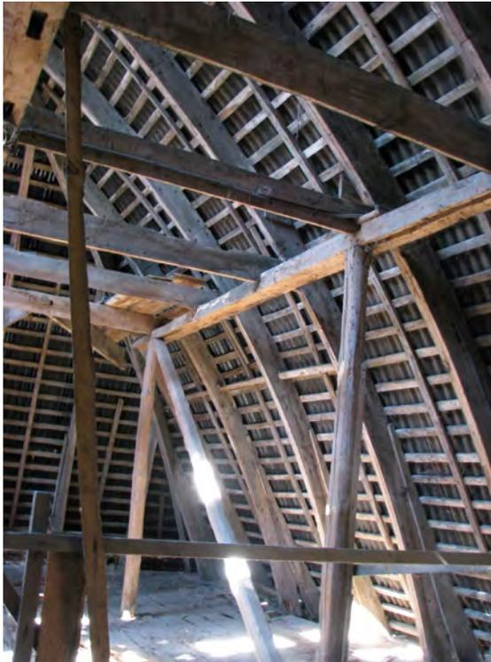
Abb. 9.156: Scheune Wellerswalde, Bohlenbögen mit unterem Längsrähm und Kehltriegeln
