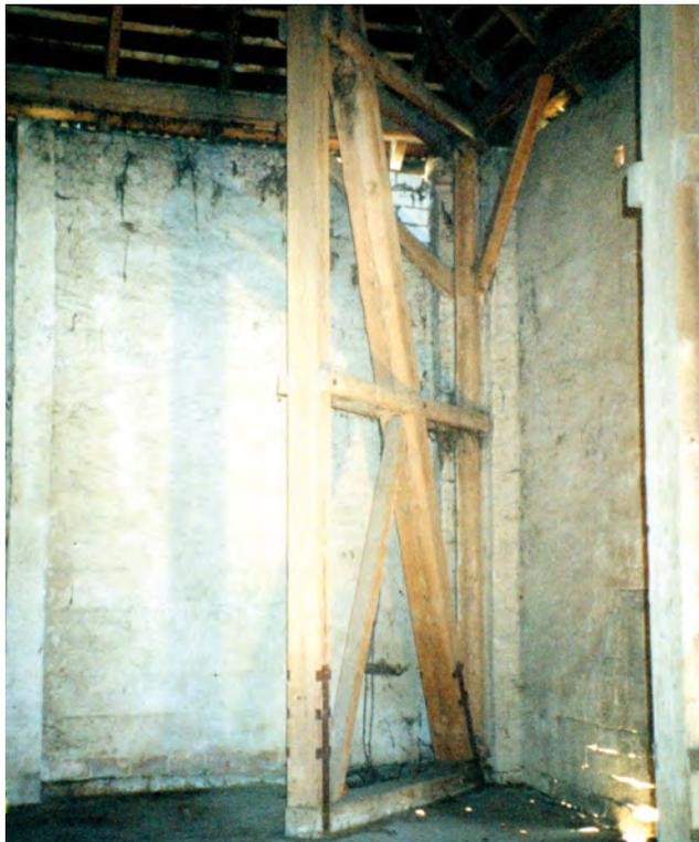
Abb. 13.35: Scheune Merzdorf, Detail Gitterstütze an einer Gebäudedecke, Aufnahme Januar 2006
