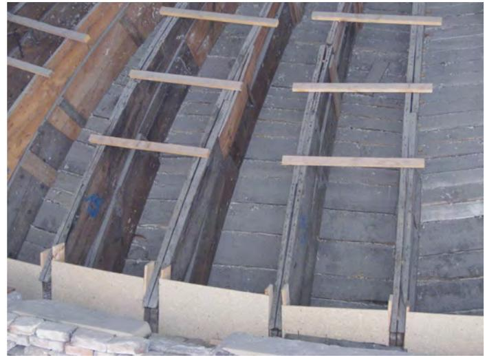
Abb. 9.11: Anatomiegebäude der Tierarzneischule Berlin, Detail der Bohlensparren im unteren Bereich (Quelle: Ingo Müller, 2009)
