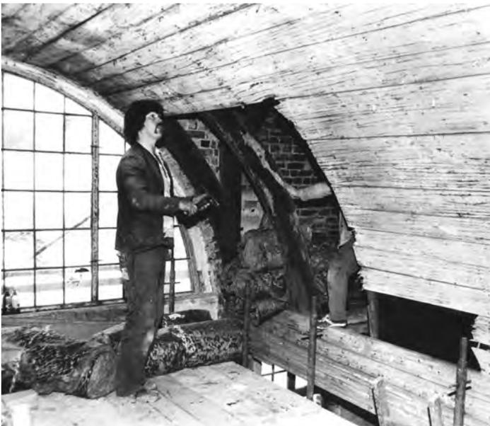
Abb. 9.45: Alt-Langsdorf, Schul- und Bethaus, Sanierung der Tonne, Aufnahme 1988
