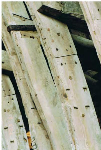
Abb. 9.142: Reithalle Groß-Miltzow, Bohlenbögen mit Holz- und Eisennägeln
