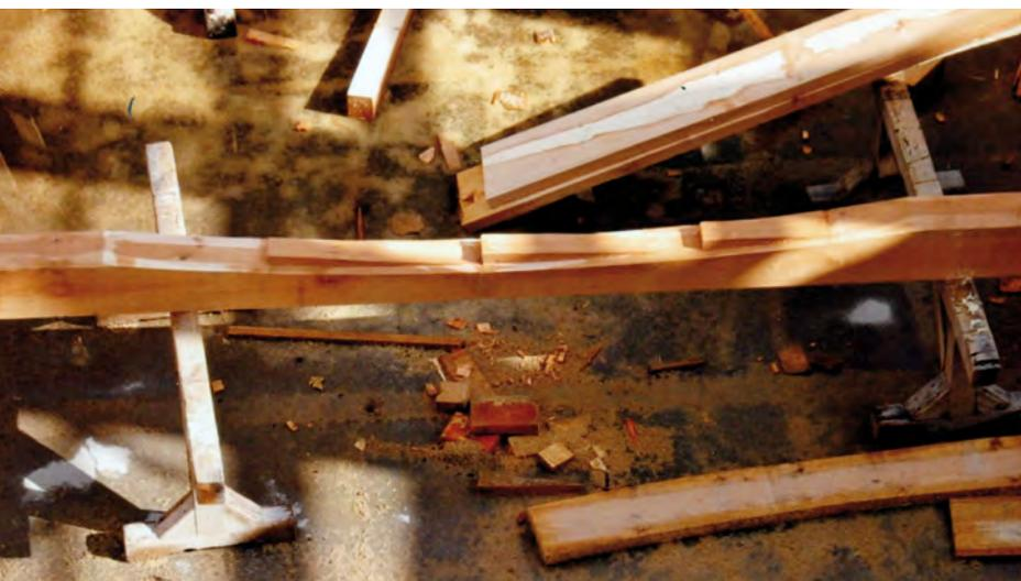
Abb. 9.111: Reithalle Basedow, Sanierung, Verzahnung an einem ausgekehrten Sparren zum Eingreifen in die Mittelbohle eines Bogens, (Quelle: M. Hartig, Herbst 2005)
