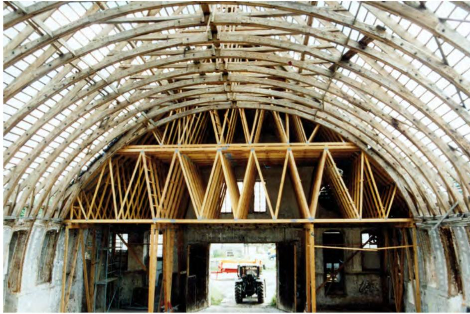
Abb. 9.107: Reithalle Basedow, Beginn der Sanierung, provisorische Fachwerkbinder stützten die ersten fünf Binder am Ostgiebel, Aufnahme Juli 2005
