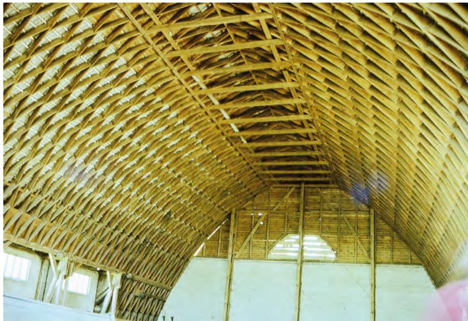
Abb. 13.26: Scheune Putlitz, Innenansicht, am Ostgiebel drei Gitterstützen, Aufnahme 1989
