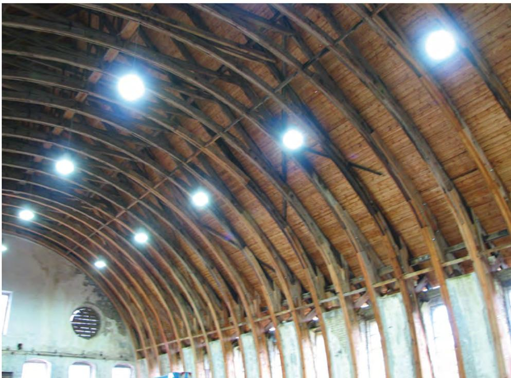
Abb. 9.115: Reithalle Badedow, sanierte Bögen und aufgebrachte Dachschalung, Aufnahme August 2006
