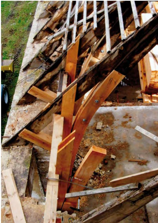
Abb. 9.113: Reithalle Basedow, Sanierung der Traufzone und Teilerneuerung der Bögen (Quelle: M. Hartig, November 2005)
