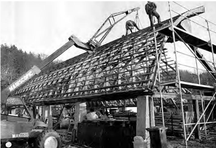
Abb. 13.57: Valley-Zollinger-Dach während der Demontage; beim vorderen Segment fehlt bereits die hintere Bogenhälfte, aus /125/, Aufnahme Dezember 2001
