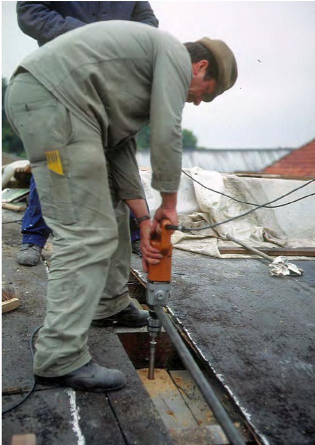
gebracht und hatten einen Durchmesser von Gewindestabdurchmesser (18 mm) + 6 mm. Als Vergussmaterial wurde Epoxidharz, gemischt mit Feinsand, Körnung bis 0,5 mm, im Verhältnis 1:1, verwendet. Die Bohrungen endeten 10 mm oberhalb der unteren Querschnittsfläche und hatten dadurch einen ›Boden‹.
