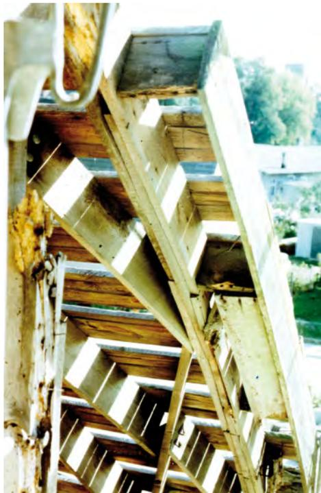
Abb. 13.28: Scheune Putlitz, Westgiebel, Randabschluss der Lamellenkonstruktion mit dreifachem Bohlenbinder, Aufnahme 1989
