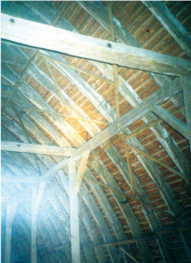
Abb. 9.56: Burg Rabenstein, Scheune, Dachbögen mit Kehltriegeln, Rähm und Stützen, Aufnahme März 2006
