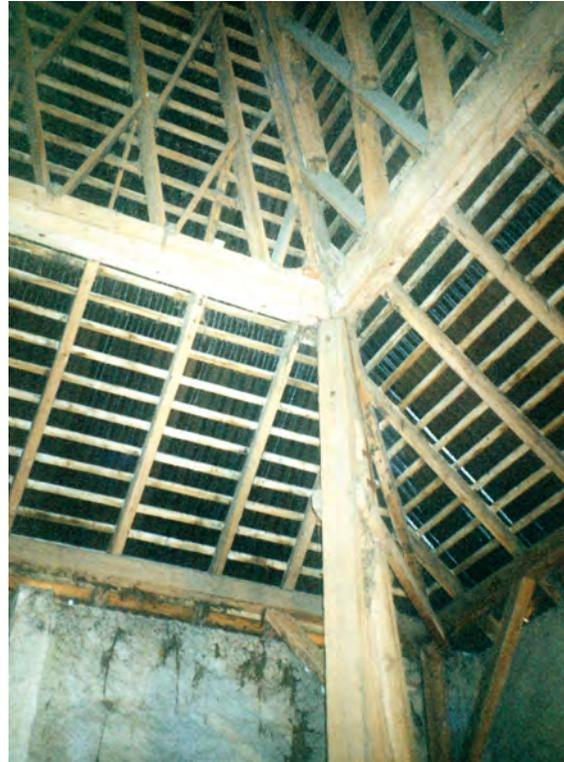
Abb. 13.36: Scheune Merzdorf, Blick in das Dach an einer Gebäudeecke, im unteren Bereich Aufschieblinge, Aufnahme Januar 2006
