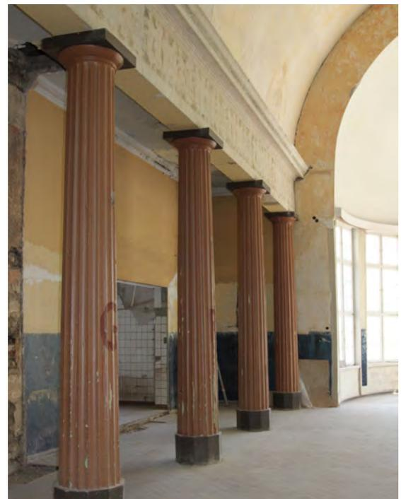
Abb. 9.195: Schießhaus Weimar, Dorische Säulen aus Holz während der Sanierung, Aufnahme Februar 2011
