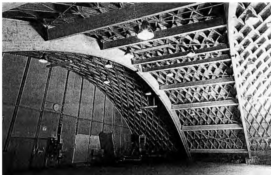
Abb. 13.77: Flugzeughalle Mengen, sanierte Halle mit untergesetzten BSH-Bögen, aus /128/
