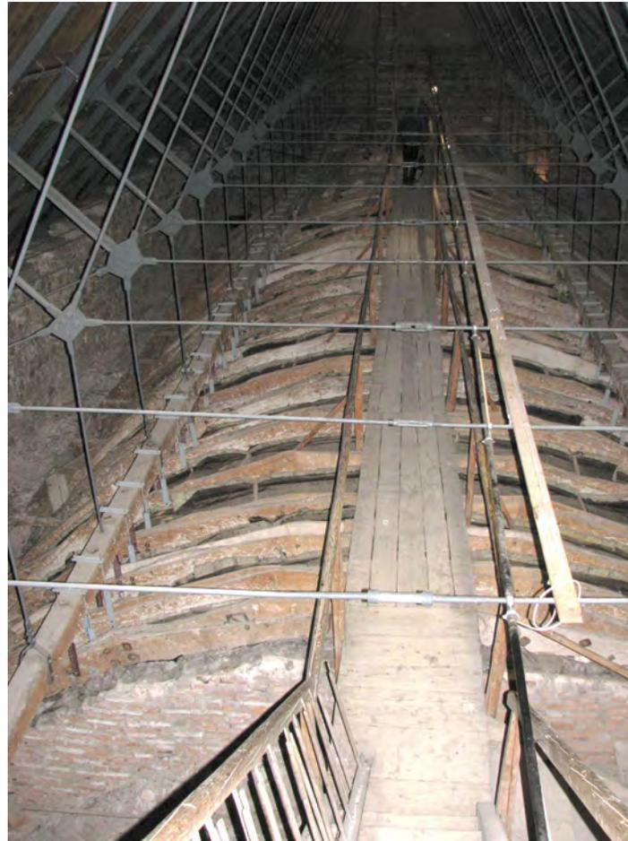
Abb. 8.55: Dom St. Blasien; Blick in den Dachraum der Chorkirche auf die Bohlenbögen und Stahlabhangung, Aufnahme Oktober 2009
