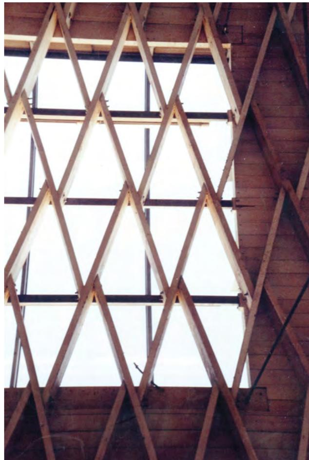
Abb. 13.75: Ostfildern-Nellingen, Markthalle, Lamellen und aufgesetztes Oberlicht
