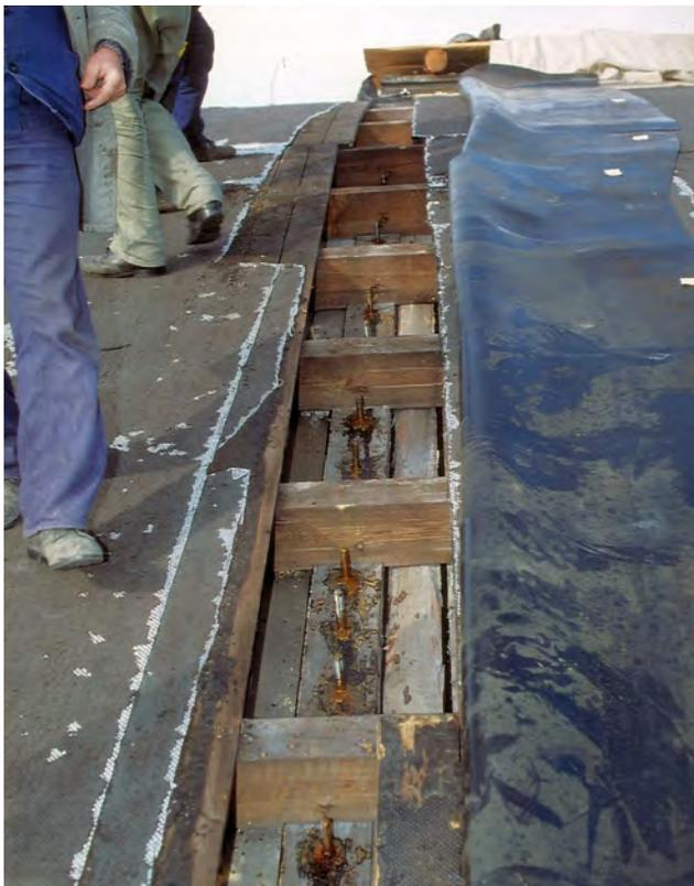
Abb. 11.27: Einbringen der Gewindestangen von oben und Verguss mit Epoxidharzmörtel, Aufnahmen Oktober 1990
