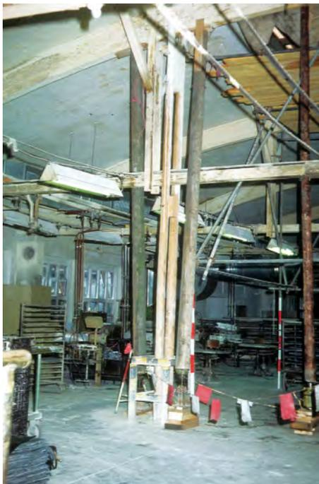
Abb. 11.25: Sanierung eines gerissenen Hetzer-Bogens (Fabrikhalle Tabarz), provisorische Absteifung, Aufnahme Juli 1990
