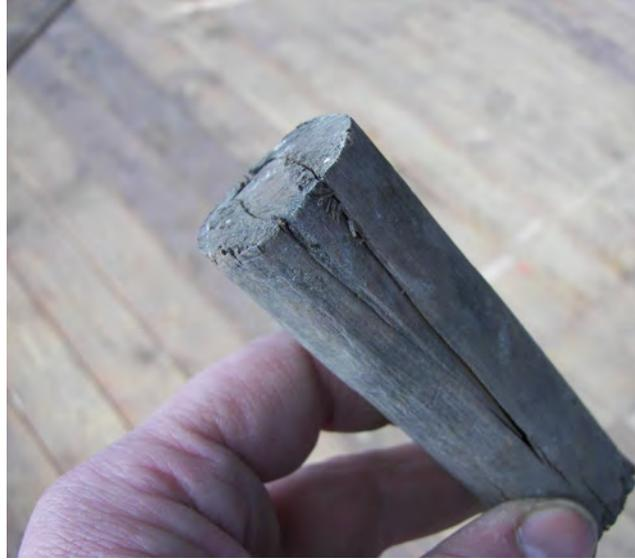
**Abb. 9.13:** Anatomiegebäude Tierarzneischule Berlin, Holz nagel mit eingetriebenem Holzkeil (Quelle: Ingo Müller, 2009)
