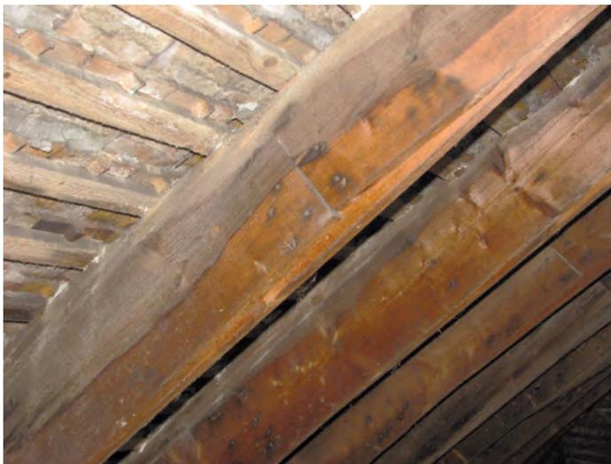
**Abb. 12.17:** Gewerbe- und Wohngebäude Großbothen, Detail der Bogenbohlen mit Stahlnägeln, Aufnahme Oktober 2010
