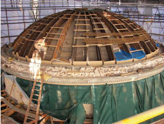
Abb. 9.10: Anatomiegebäude der Tierarzneischule Berlin, Dachkuppel während der Sanierung, obere Schalung entfernt, zwei übereinander liegende Bohlenbögen (Quelle: Ingo Müller, 2009)
