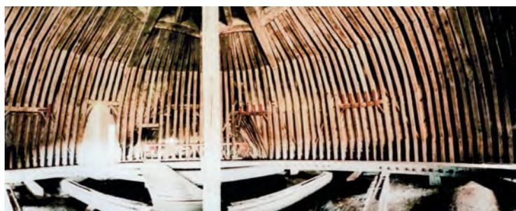
Abb. 7.5: Schloss Chambord, Blick in die Kuppelkonstruktion eines Eckturmes (Quelle: Schlossverwaltung Chambord)
