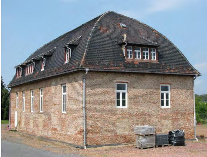
**Abb. 12.15:** Gewerbe- und Wohngebäude in Großbothen, Colditzer Straße, der Putz ist abgeschlagen, die Gaupen sind noch im Originalzustand, Aufnahme September 2010
