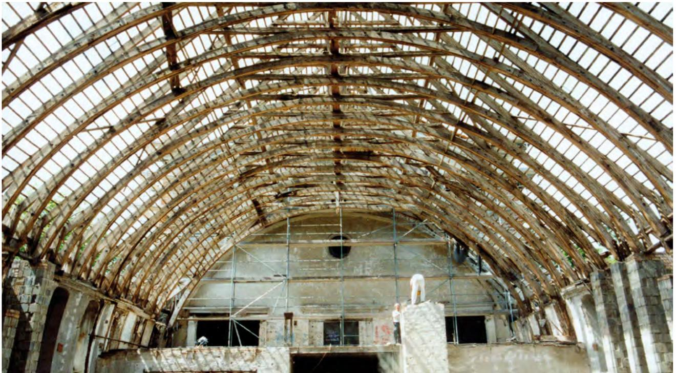
Abb. 9.105: Reithalle Basedow, Dachhaut entfernt, Aufnahme Juli 2005
