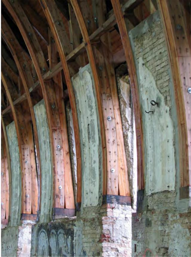
Abb. 9.114: Reithalle Badedow, Sanierung, erneuerte Bogenfüße und Stützen auf Schwellen, Aufnahme August 2006
