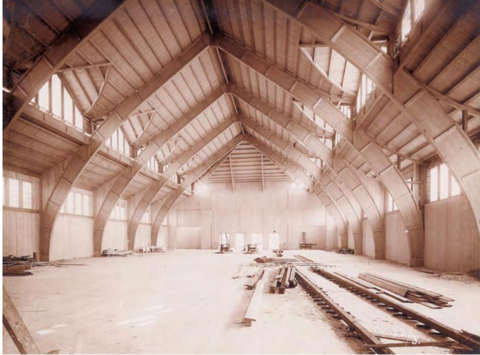
Abb. 11.14: Bogenförmige Hetzer-Rahmen mit über 20 m Spannweite
