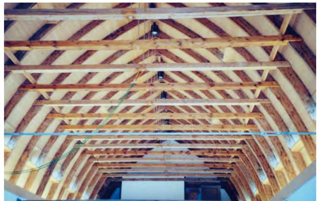
Abb. 9.176: Blick in den Dachraum des größeren ›Schuppens‹ 2, heute Turnhalle; Kehlriegel sowie Zugstangen, vollflächige Dachschalung, Aufnahme September 2006
