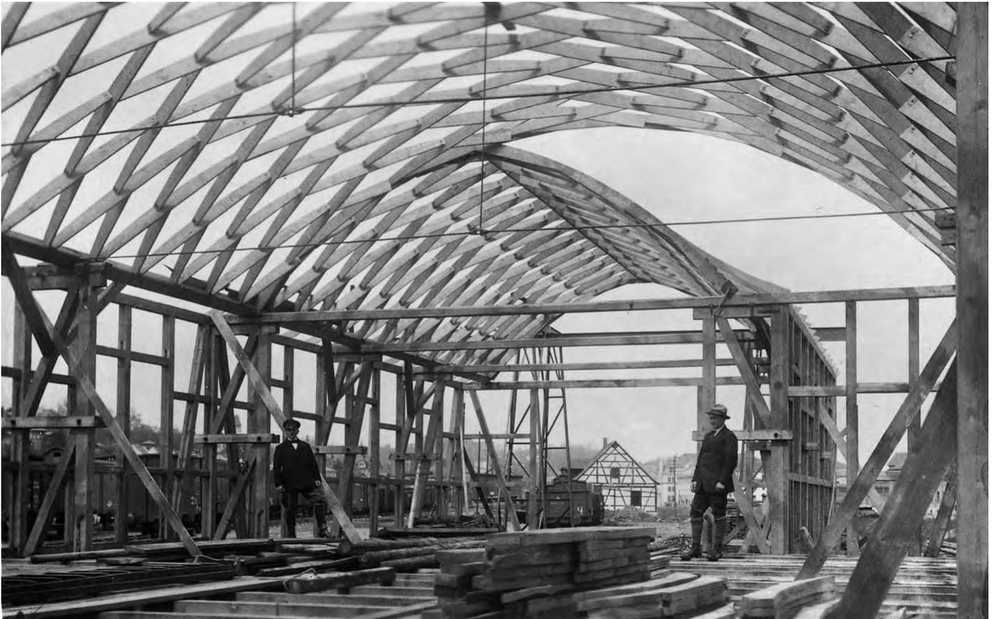
Abb. 13.80: Coburg, Lagerhalle Fa. Knoch-Glas, Bauzustand 1924, aus /5/
