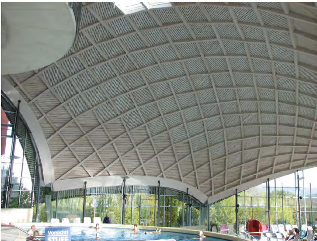
Abb. 13.88: Therme Toscana Bad Sulza, Rauten-Lamellen-Struktur mit Randträgern aus Brettschichtholz, Aufnahme Oktober 2010
