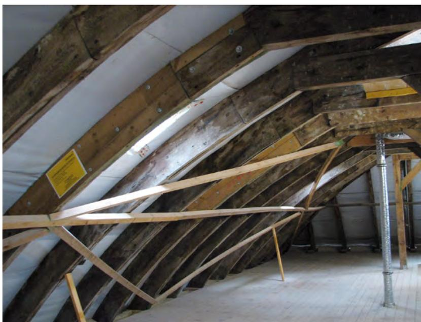
Abb. 9.119: Gymnasium Neustrelitz; Blick in das obere Dachgeschoss mit sanierten Bohlenbögen, Aufnahme August 2006
