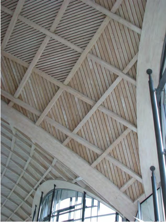
Abb. 13.89: Therme Toscana Bad Sulza, Detail der Lamellenstruktur ohne sichtbare Verbindungsmittel, Aufnahme Oktober 2010
