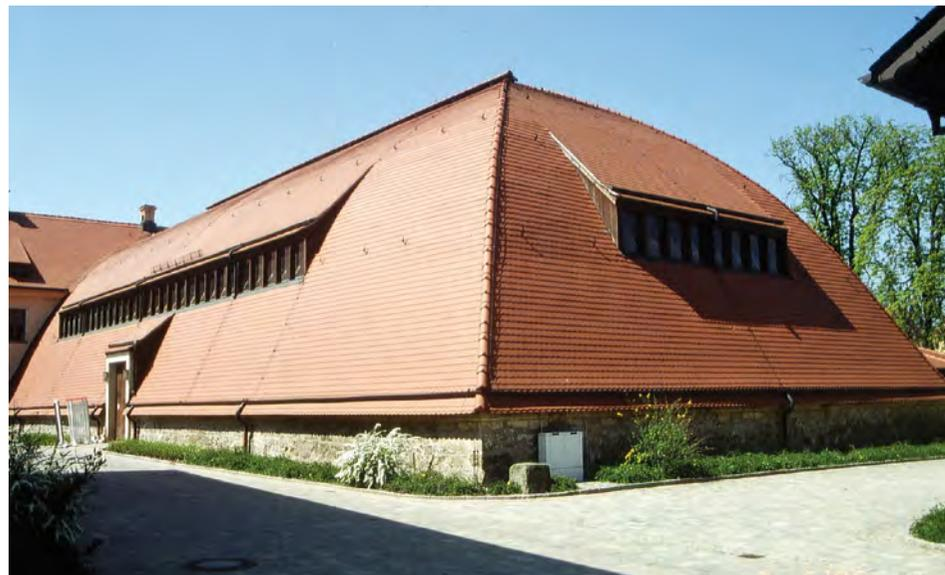
**Abb. 9.178:** Landgestüt Moritzburg, Alte Reithalle, Blick nach Westen, vorn Abwalmung mit Gaupen, im Hintergrund anschließendes Stallgebäude, Aufnahme Mai 2006
