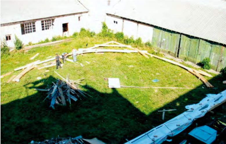
Abb. 9.110: Reithalle Basedow, Sanierung, Auslegen eines Gespärres mit Bogen am Boden (Quelle: M. Hartig, Herbst 2005)
