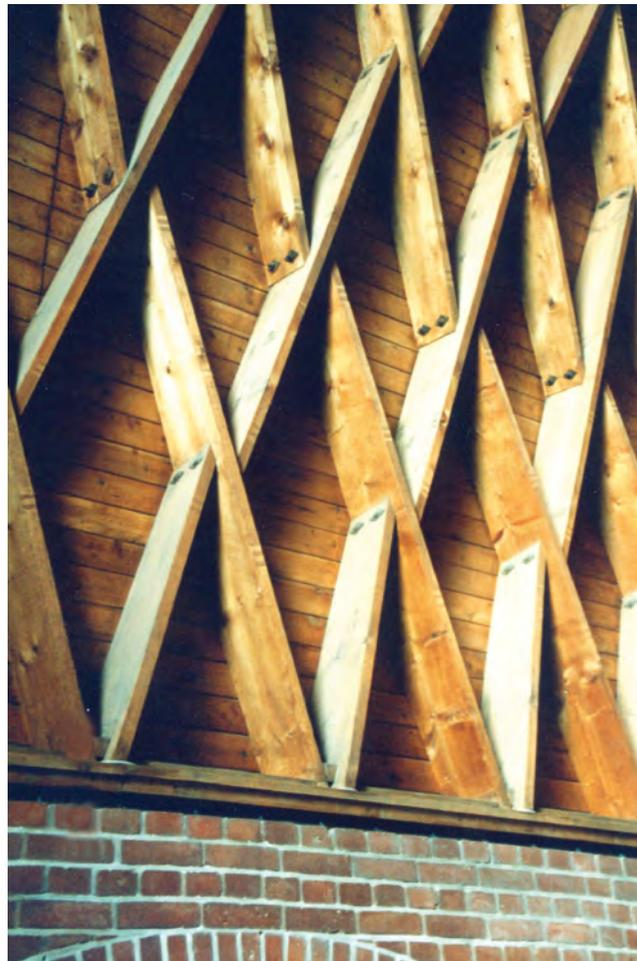
Abb. 13.45: Güstrow, Marienkirche, offenliegende, unbehandelte Lamellenstruktur, Aufnahme August 2003
