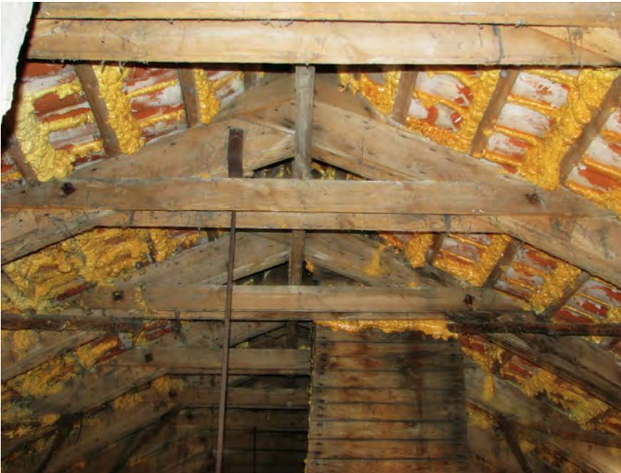
Abb. 9.89: Lübstorf, Alte Dorfstraße 52, Firstbereich mit Hahnenbalken und aufgesetzten Firstknaggen, Aufnahme Juni 2008
