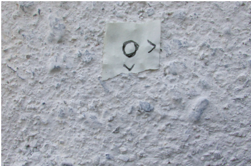
Abb. 74: Saniertes Feld , das vor der Reinigung und Neukalkung mit Rissen und dunklem Bewuchs versehen war und nun dazu dient, möglichen Neubewuchs zu er- fassen
