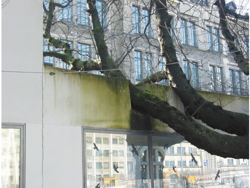
Abb. 36: Vorhersehbarer Algenbefall beim Baumschutz und der entsprechenden Ent- wässerung
