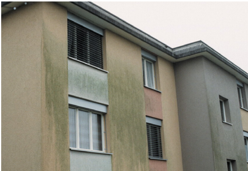
Abb. 10: Algenbefall auf einer verputzten Außenwärmedämmung
