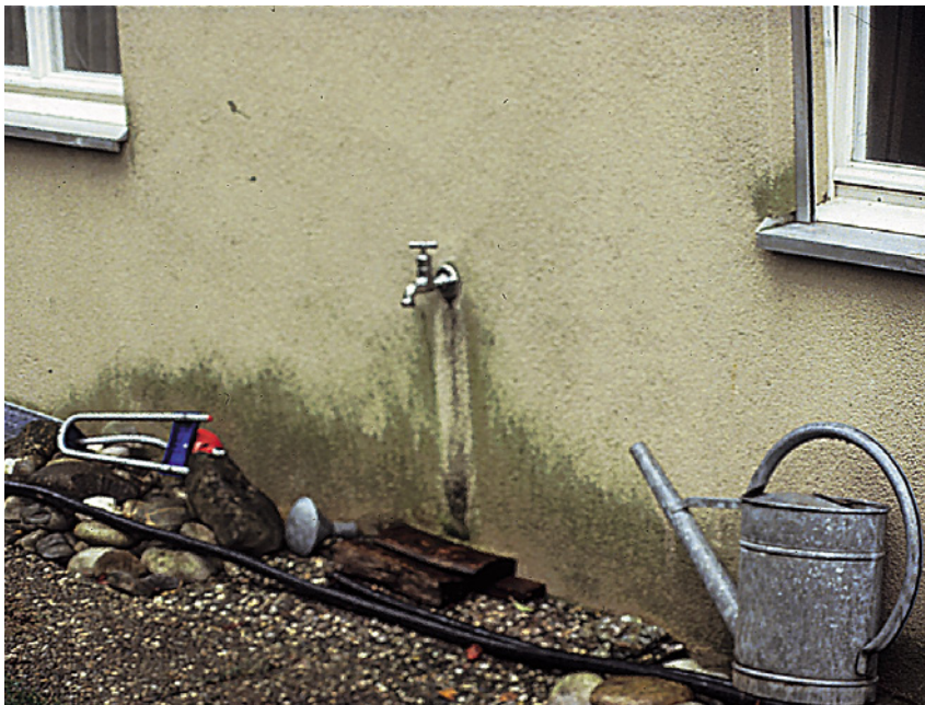
Abb. 35: Algenbewuchs im Sockelbereich im Umkreis der Was- serzapfstelle
