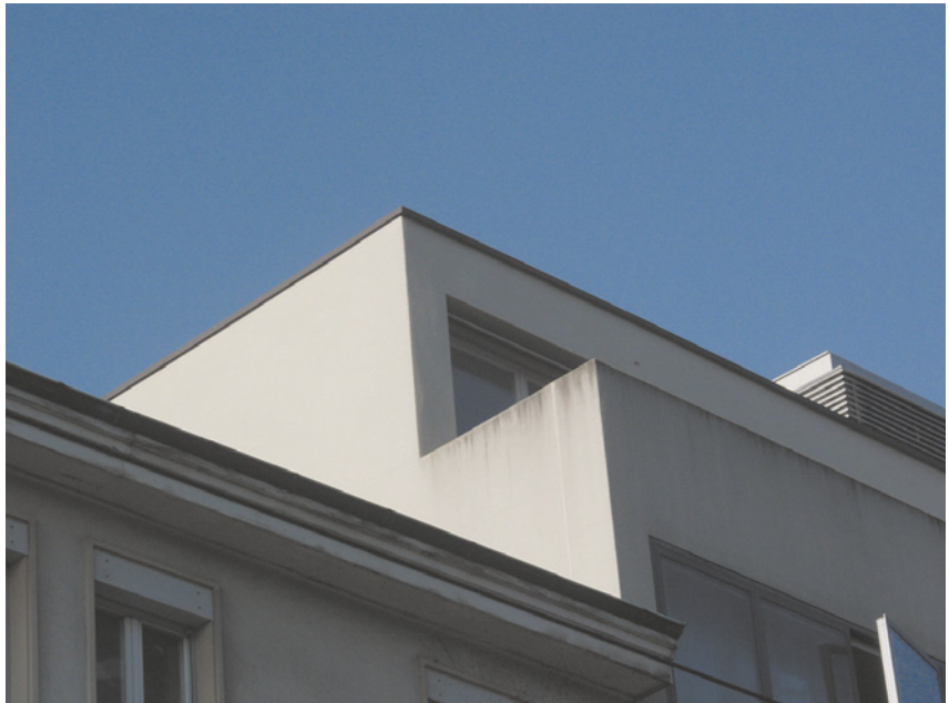
Abb. 37: Unterschiedliche Behandlung der Brüstungen oben abgedeckt = kein Algenbefall; unten nicht abge- deckt = Algenbefall
