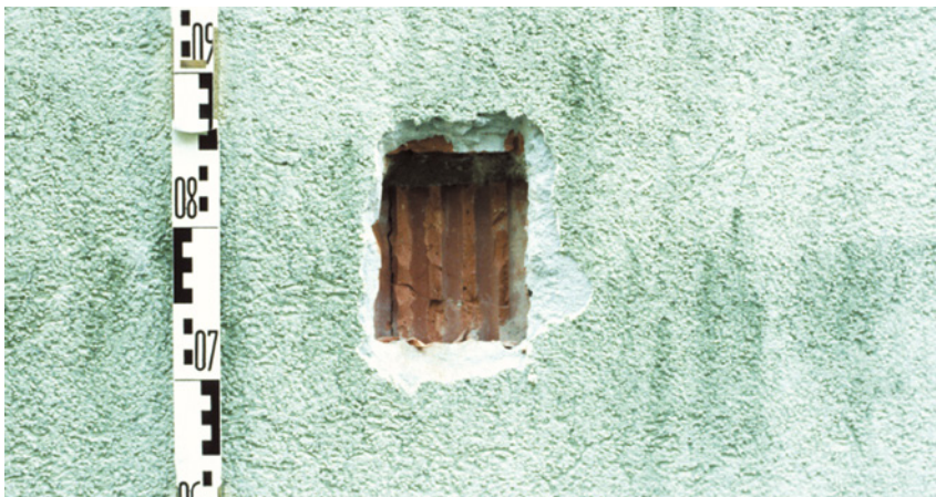
Abb. 57: Sondierstelle zur Überprüfung der Konstruktion und der Materialfeuchtigkeit
