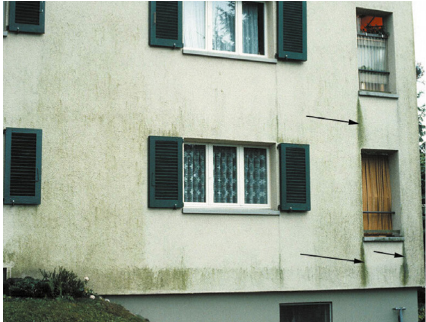
Abb. 32: Mangelhafte Entwässerung von Balkonen bewirkt starkes Algen- wachstum an Wasserläufen
