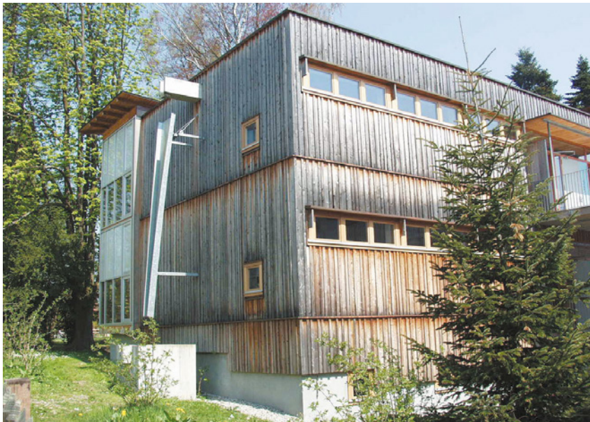
Abb. 5: Bläuepilze an Holz- konstruktionen. An der ungeschütz- ten bewitterten Holzkonstruktion wachsen Bläuepilze am Holz, ohne die Holzstruktur zu schädigen.
