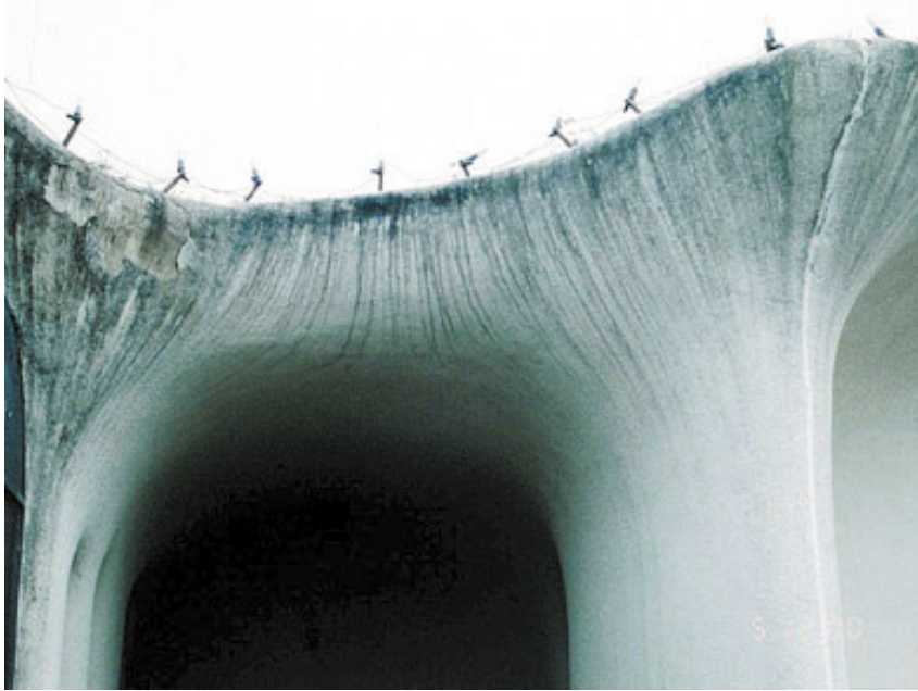
Abb. 38: Runde Brüstungen ohne Abdeckungen provozieren den Algenbefall an den Wasserlaufspuren
