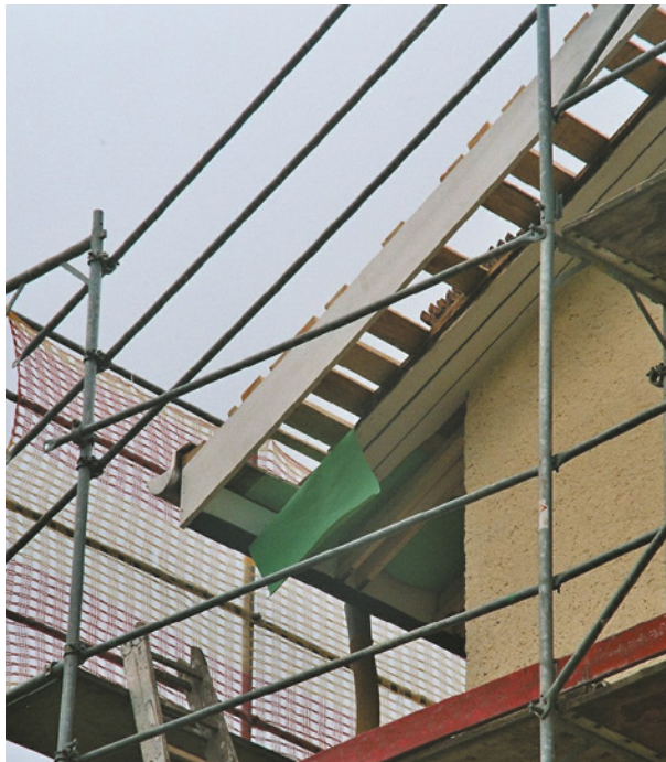
Abb. 85: Bauzustand; mit Latten wird das Vordach um mindestens die Dicke der zukünftigen Wärmedämmung verbreitert
