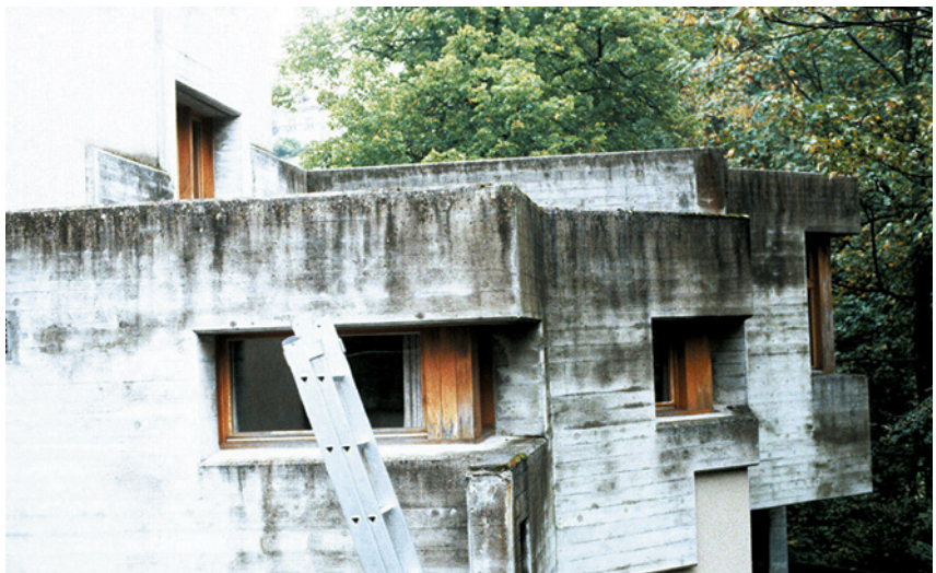
Abb. 59: Die Sichtbetonteile sind, ausgehend von den Brüstungen und Dachrändern, sehr stark verschmutzt
