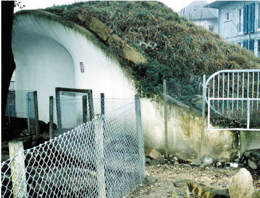
Abb. 34: Algenwuchs an der runden Mauerkrone wegen ständig hoher Feuchtigkeit
