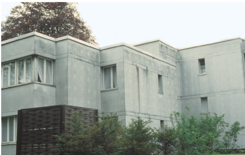
Abb. 51: Hinterlüftete Fassadenbekleidung aus großformatigen Faserzementplatten. Die Montagepunkte zeichnen sich als helle, nicht bewachsene Flächen im sonst ziemlich flächigen Bewuchs ab.
