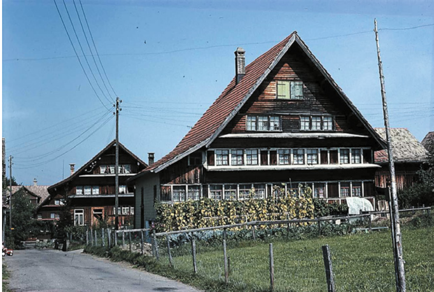
Abb. 7: Bläuepilze an Holz- fassade. Ein Dach- vorsprung sorgt für Regenschutz und verhindert oder verzögert lokal die Bläuepilzentwicklung
