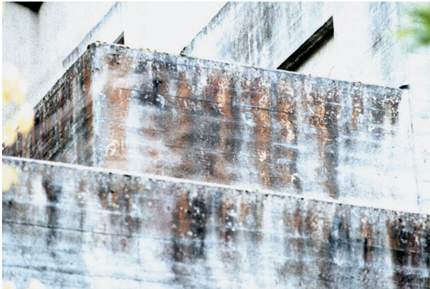
Abb. 61: Detail aus Abb. 60. Bei den rötlichen Verschmutzungen handelt es sich um einen Bewuchs von Grünalgen
