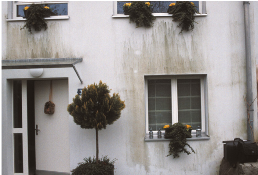
Abb. 45: Ansicht der verschmutzten Fassade. Gut sichtbar sind auch die hellen Flecken neben und über dem Sturz. An diesen Stellen wurden die Sturzelemente mechanisch mit Dübeln befestigt.
