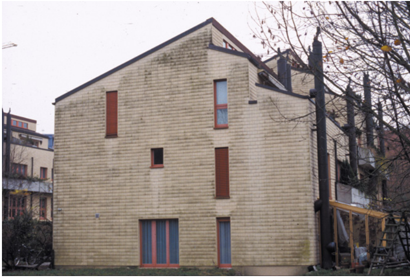
Abb. 9: Außenwärmedämmung mit hinterlüfteter Verkleidung mit Algenbefall
