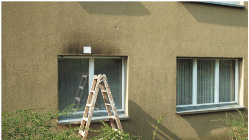
Abb. 48: Fenstersturz mit Schwärzepilzen. Verputzte Außen- wärmedämmung auf Polystyrolplatten.
