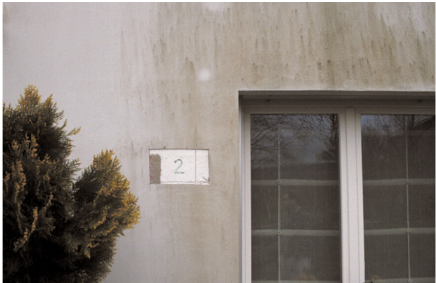
Abb. 46: Detailaufnahme aus Abb. 45. Sichtbar ist auch die Stelle der Probeentnahme. An dieser Probe wurden die Organismen auf der Oberfläche be- stimmt.
