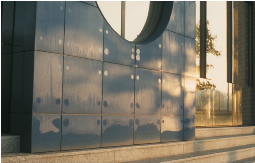
Abb. 50: Tauwasser auf einer hinterlüfteten Fassadenbekleidung aus Keramikplatten. Die Verankerungen zeigen sich als scharf abgegrenzte tauwasserfreie Zonen.
