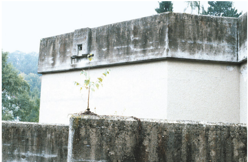
Abb. 62: Die Sichtbeton- flächen sind sehr stark verschmutzt
