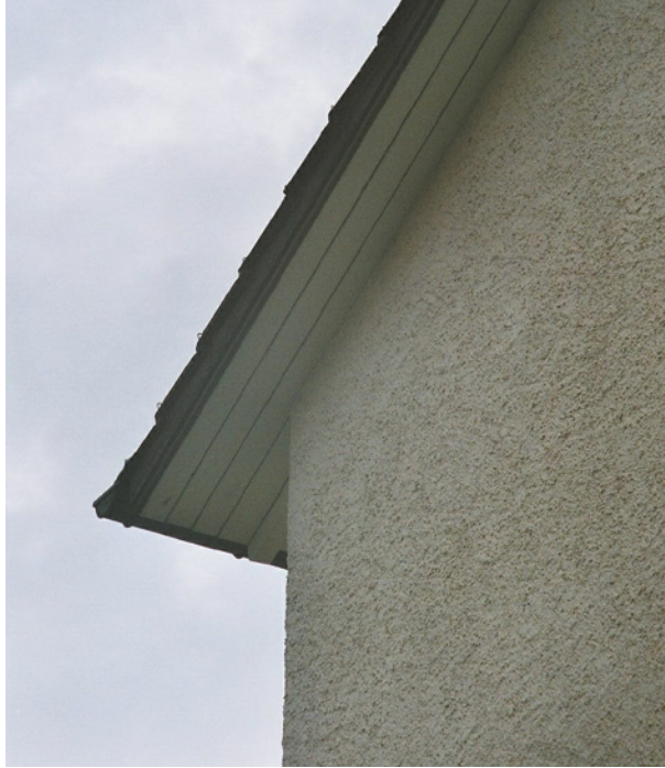
Abb. 84: Der Zustand vor der Sanierung; das Vordach bietet gerade Platz für die Wärmedämmung, aber hat danach keinen Überstand mehr
