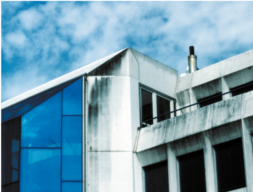
Abb. 39: Schräg nach außen und nach innen ge- neigte Brüstungen und Abdeckungen sind sehr anfällig für Algenbefall an den Wasserlaufspuren
