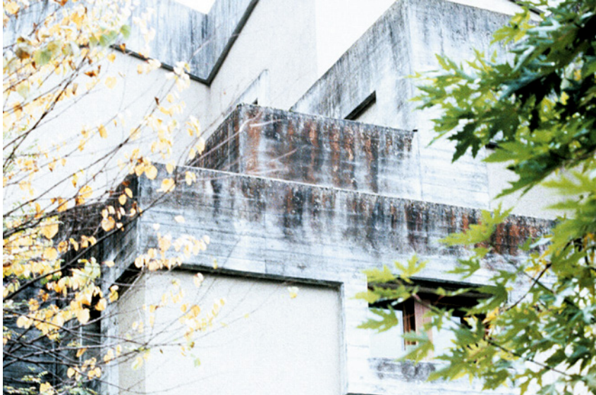
Abb. 60: Teilweise treten rote Verschmutzungen auf, ähnlich Rostfahnen bei korrodierten Armierungseisen. Diese erweisen sich als mikrobieller Befall.
