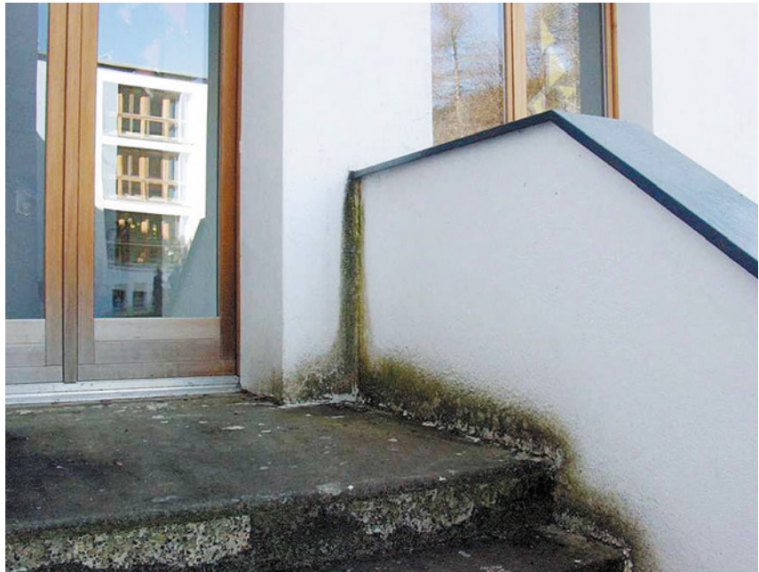
Abb. 33: Mangelhafte Abdeckung der Brüstung mit Algen- befall am Wasserlauf und starker Algen- befall im Spritz- wasserbereich
