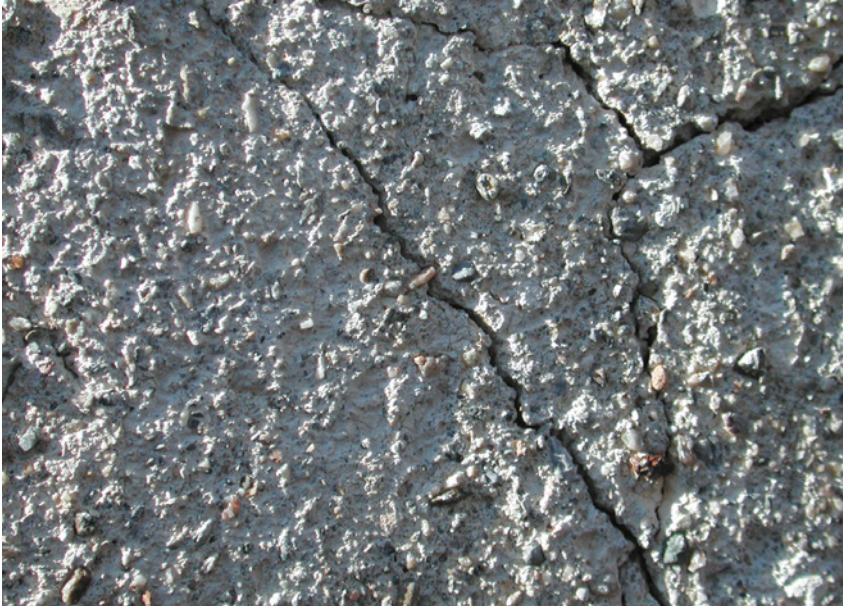
Abb. 69: Der dunkle Bewuchs zeigte sich als Flechtenlager gemeinsam mit Pilzkolonien in den Rissen des Verputzes, aber auch auf vielen leicht vorstehenden horizontalen Stellen
