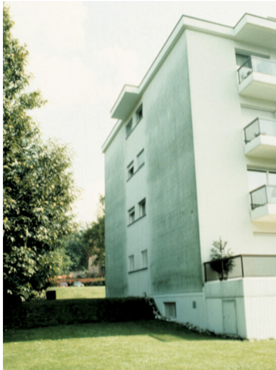
Abb. 54: Algenbewuchs an der Nordfassade, Gebäudeabstand wenige Meter von einem Waldstück. Die scharfe Abgrenzung des Befalls zwischen Nord- und Westfassade ist gut sichtbar.
