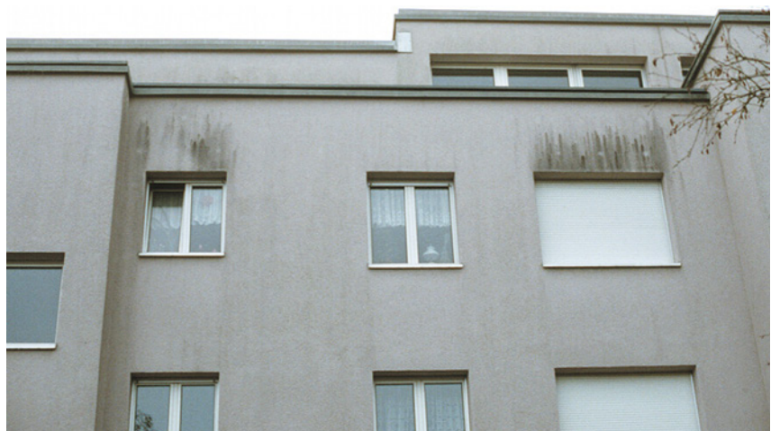
Abb. 49: Fenstersturz mit Algenbewuchs. Die Dübelanker zeichnen sich dank ihrer Wär- mebrückenwirkung als bewuchsfreie helle Flecken ab.
