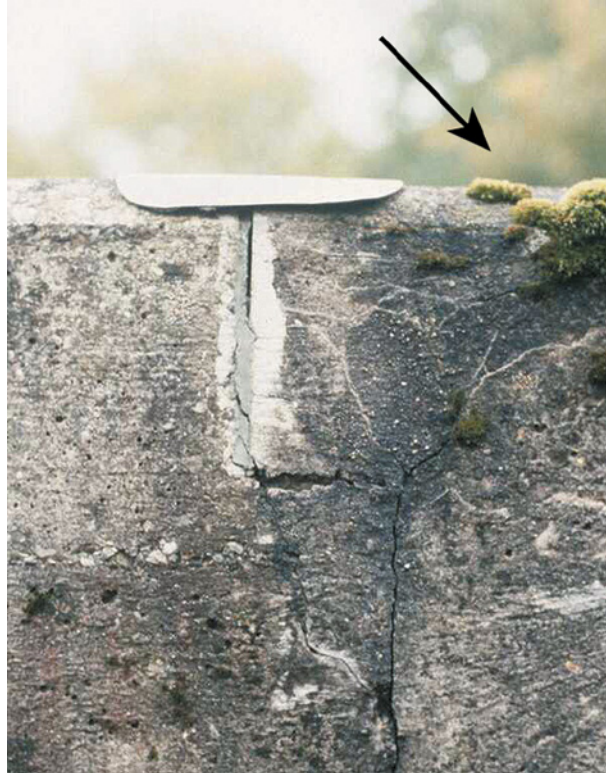
Abb. 63: Moose wachsen auf den horizontalen bzw. schwach geneigten Sichtbeton-Brüstungen dort, wo es lange feucht bleibt
