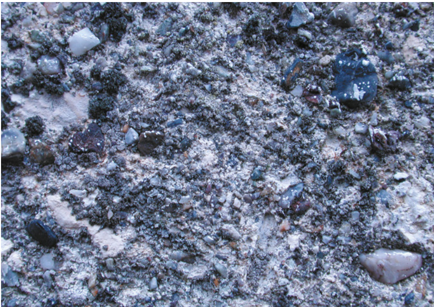
Abb. 70: Dieser Ausschnitt zeigt den Zustand des Verputzes vor der Restaurierung
