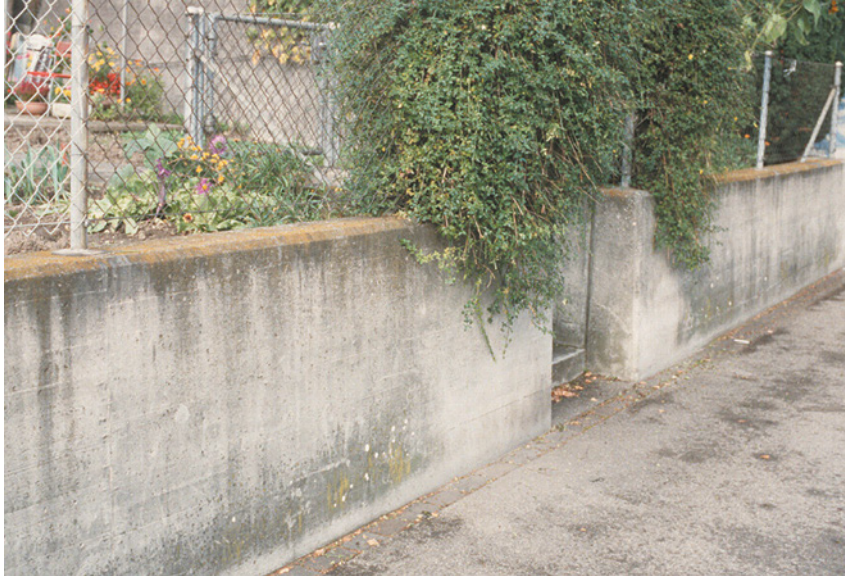
Abb. 12: Algen- und Flechtenbewuchs an einer Beton-Stützmauer. Diese Erscheinung ist alltäglich und allgemein akzeptiert.
