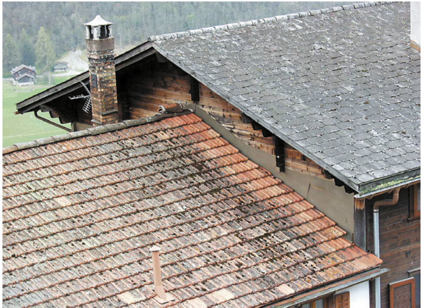
Abb. 11: Ziegel- und Faser- zement-Eindeckung mit Algen und Pilzbefall
