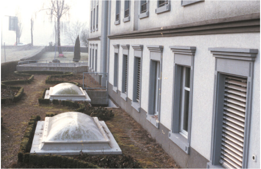
Abb. 64: Algenbewuchs auf Oberlichtern aus Kunststoff. Die gebäudeseitige Teil- fläche ist algenfrei.
