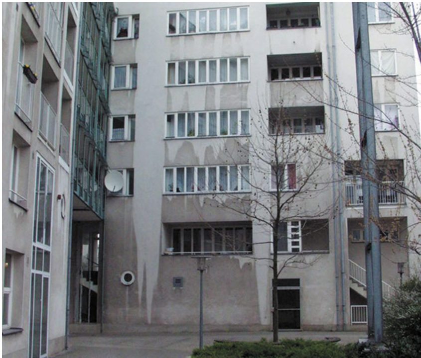
Abb. 100: Fassadenverschmutzungen werden durch ablaufendes Regenwasser abgewaschen. Wo wenig oder kein Wasser an die Fassade kommt, bleiben dunkle Flecken zurück.
