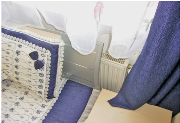
Bild 19 ■ Nahezu vollständig durch die Möblierung verstellter Heizkörper
