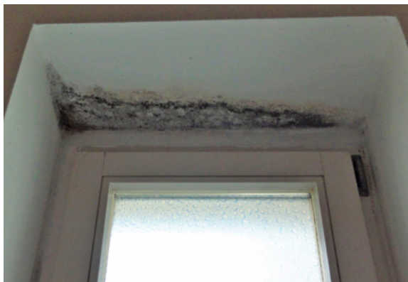
Bild 55 ■ Schimmelbildung im Sturz oberhalb eines regelmäßig über längere Zeit in Kippstellung geöffneten Badfensters
