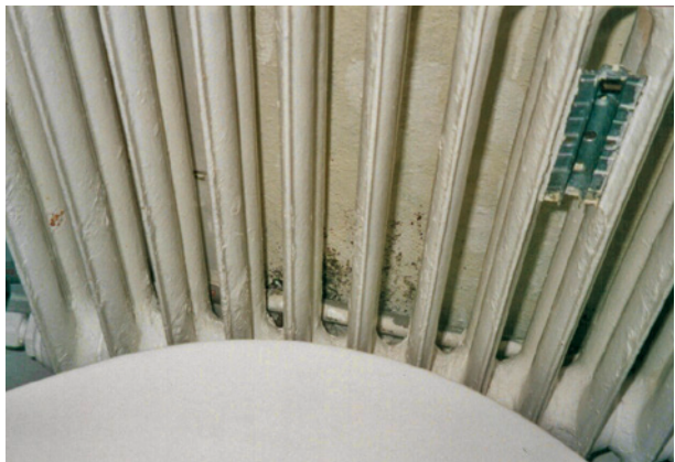
Bild 20 ■ Schimmelbildung unmittelbar hinter einem Heizkörper
