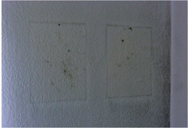
Bild 26 ■ Schimmelbildung infolge thermischer Abschirmung hinter Bildern an einer Außenwand
