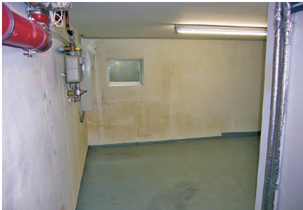
Bild 2 ■ Flächige Schimmelbildung in einem Keller im Sommer
