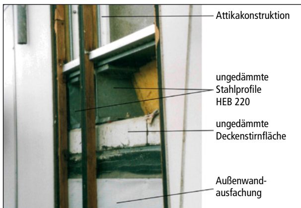
Bild 69 ■ Außenseitig freigelegter Konstruk- tionsaufbau im Bereich der Deckenstirnseite unterhalb der Attika
