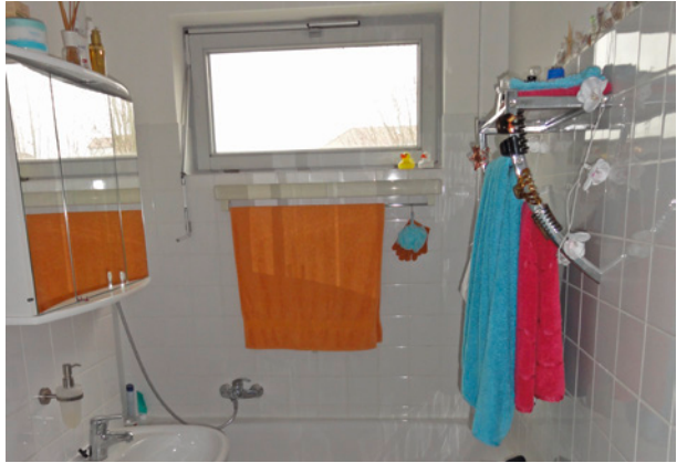
Bild 57 ■ Ungünstige Bedingungen für die Lüftung: einflügeliges Klappfenster oberhalb einer Badewanne
