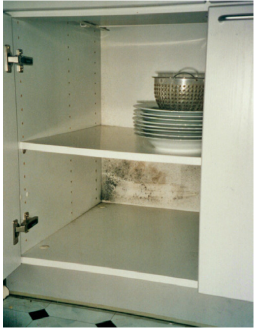
Bild 71 ■ Schimmelbildung an der Rückwand des Küchenunterschrankes im Bereich der Gebäudeaußenkante
