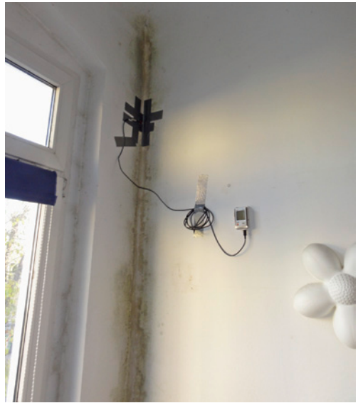
Bild 78 ■ Schadensbild im Bereich von Außenwandkante und Fensterlaibung mit dem zur Messung der Oberflächentemperatur installierten Datenlogger
