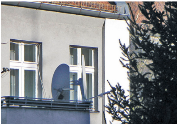
Bild 53 ■ Nachträglich mit einem Wärmedämmverbundsystem versehene Brandwand; die Wärmedämmung ist um die Außenkanten herum auf die Fassaden gezogen.
