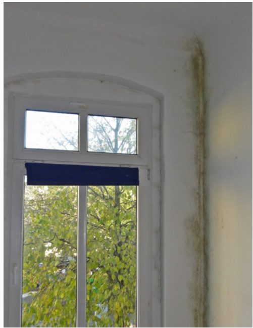
Bild 1 ■ Typische Schimmelbildung im Bereich von Wärmebrücken (hier: Gebäudeaußenkante)
