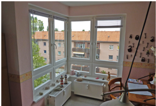
Bild 59 ■ Günstige Bedingungen für die Lüftung: fest verglaste Brüstungsfelder unterhalb von Öffnungsflügeln, die eine Nutzung der Innenfensterbank auch bei Stoßlüftung ermöglichen
