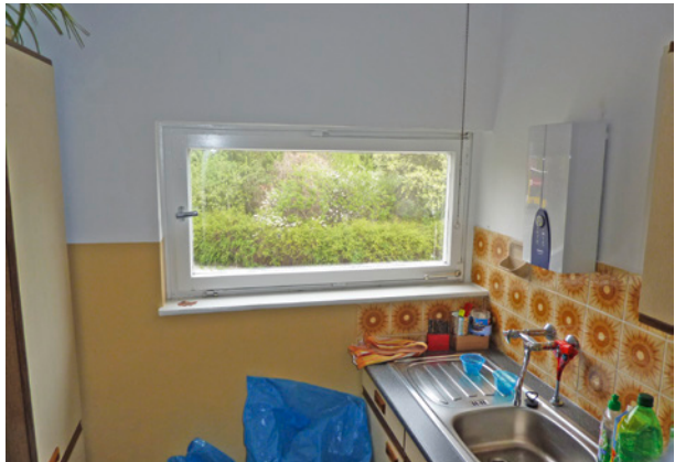
Bild 58 ■ Ungünstige Bedingungen für Lüftung: liegendes Format eines Fensterflügels, der bei Stoßlüftung die Nutzung der Küche erschwert
