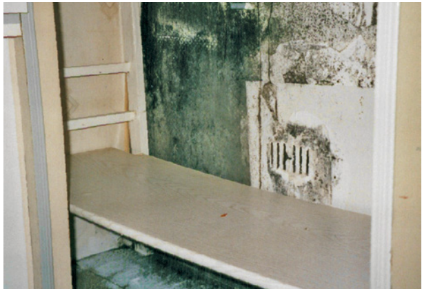
Bild 27 ■ Schimmelbildung infolge thermischer Abschirmung in einem Küchenunterschrank ohne Rückwand
