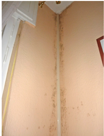
Bild 64 ■ Schimmelbildung in der Gebäudeaußenkante
