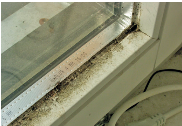
Bild 15 ■ Ablaufspuren von Tauwasser an einem Fenster und hieraus resultierende Schimmelbildung auf den Verglasungsabdichtungen
