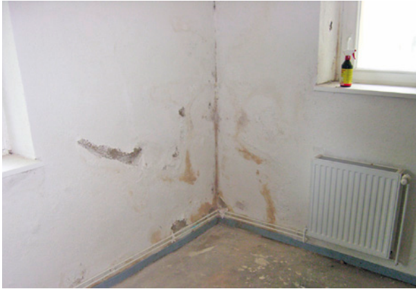
Bild 10 ■ Feuchteschaden mit Schimmelformung infolge von außen eindringenden Wassers mit den hierfür typischen Verfärbungen und Trocknungsrändern
