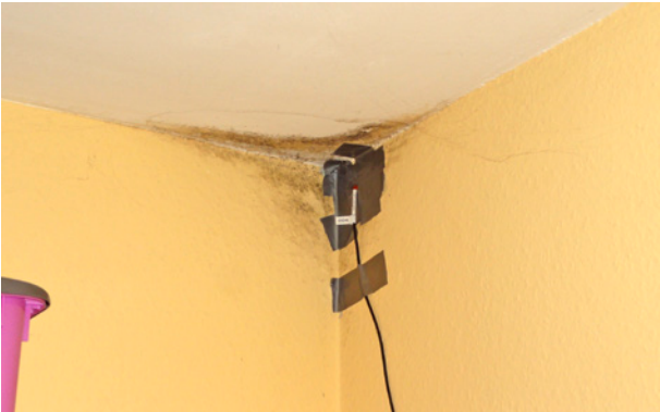
Bild 95 ■ Schadens- bild in der untersuchten Raumecke mit dem zur Messung der Ober- flächentemperatur installierten Datenlogger
