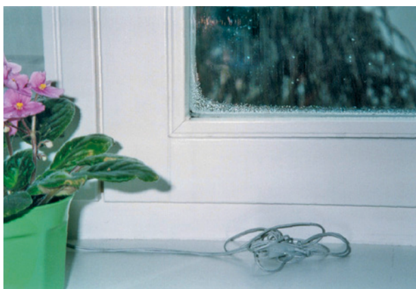
Bild 49 ■ Tauwasserbildung im Randbereich einer Isolierverglasung
