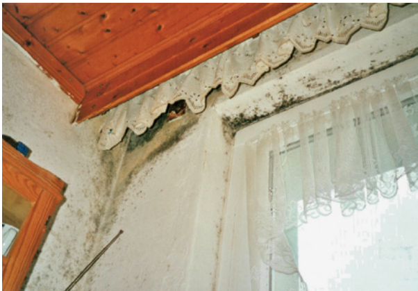
Bild 60 ■ Erhebliche Schimmelbildung in der oberen Raumecke zwischen der Außenwand und der Wand zum Treppenhaus
