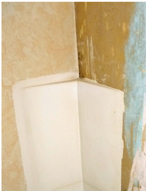
Bild 54 ■ Bis auf etwa halbe Höhe einer Außenwandkante geführte Innendämmung aus keilförmigen Calziumsilikatplatten mit oberhalb angrenzender Schimmelbildung
