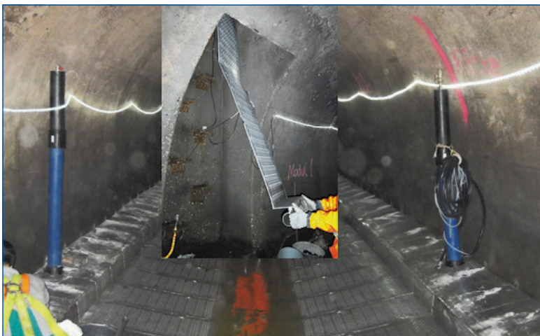
Abbildung 19: Kanalwärmetauscher – Frankfurt Speicherstraße [Fotos: EGS-plan, Stuttgart, Architekt: HHS Planer + Architekten AG, Kassel, Bauherr: ABG FRANKFURT HOLDING, Frankfurt]
