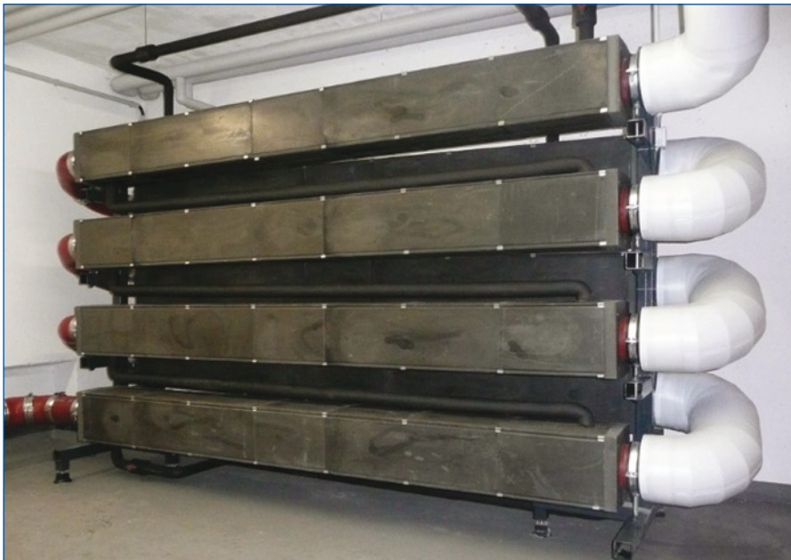
Abbildung 28: Halbschalen-Absorber [Foto: Industrie-Abwasserwärmetauscher von PEWO]
