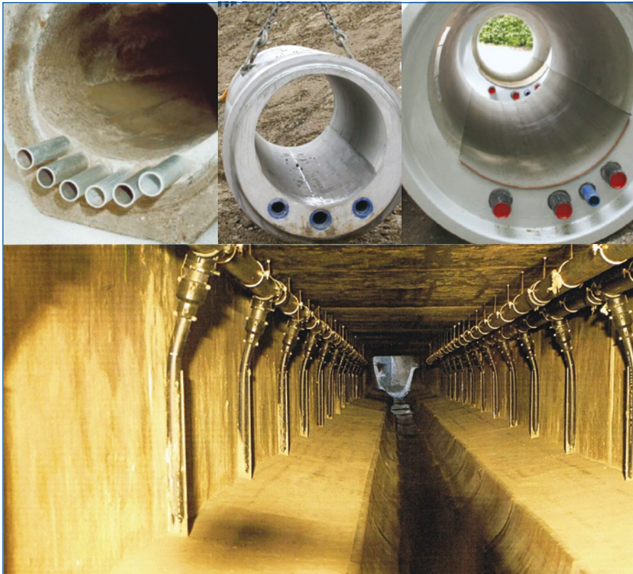
Abbildung 24: Rohr- und Rinnenwärmetauscher
