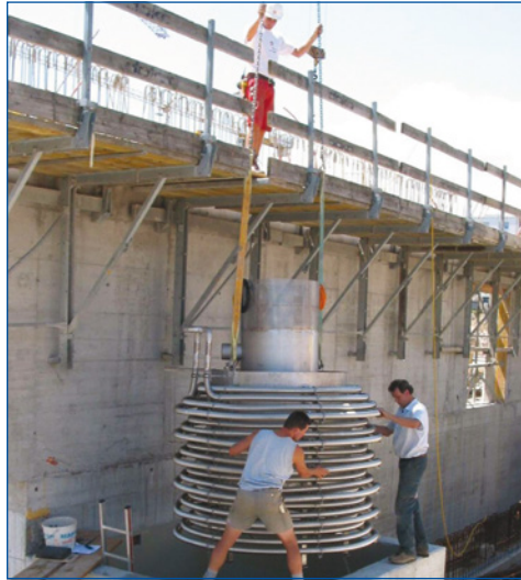
Abbildung 35: Abwasserschacht zur Abwasserwärmerückgewinnung [Foto: Feka-Energiesysteme AG, Bad Ragaz]
