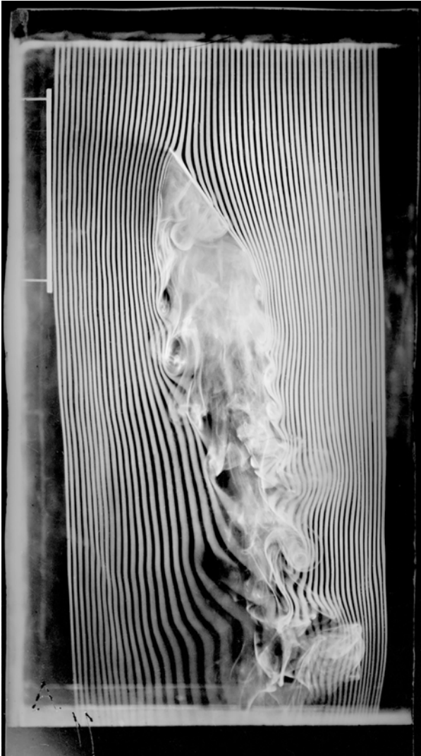
Abbildung 3: Étienne-Jules Marey: Plan incliné, angle de 30 degrés, quatrième et dernière version de la machine à fumée, équipée de 57 canaux, 1901
