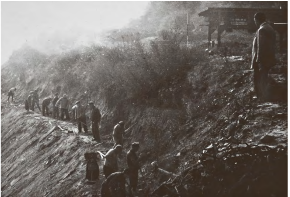
Abb. 24–25 Aufschüttung des Trümmerschutts aus der Kasseler Innenstadt am Auehang in Vorbereitung für die 1955 stattfindende Bundesgartenschau, 1953 (Fotografie)
