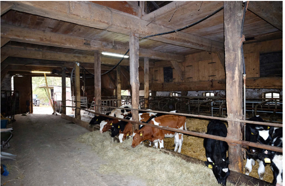
4-80 (oben) – Blick von Hofstelle auf Umspannwerk, Konverterstation, Stromleitungen. Lüder, 2018. 4-81 (unten) – Wirtschaftsteil Fachhallenhaus mit zusätzlichen Stützen und Tierhaltung. Lüder, 2018.
