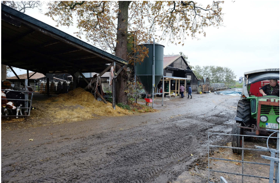
4-76 (oben) – Wirtschaftsteil Fachhallenhaus, Verbindungsbau, historischer Schweinestall, Kälberstall (v.l.n.r.). Lüder, 2018.
