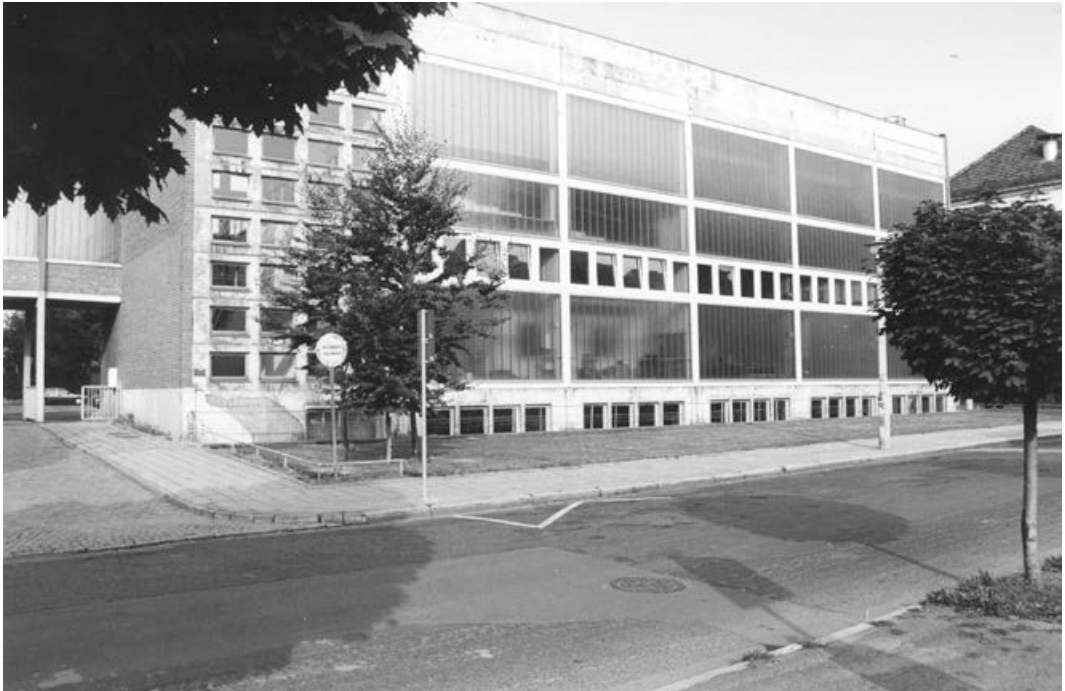
Abb. 2 Hörsaalgebäude (abgerissen), Bauhaus-Universität Weimar, Archiv der Moderne, FS/1/1551
