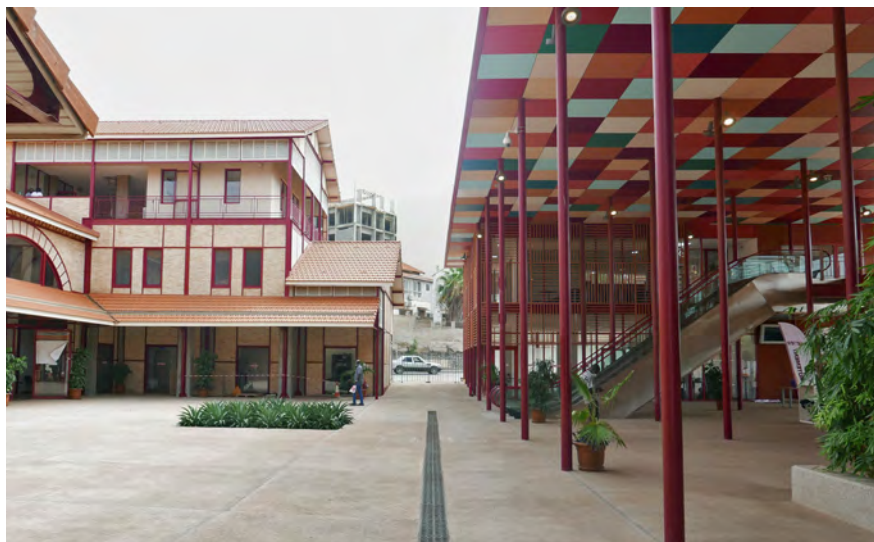
Abb. 18: Links im Bild ist das restaurierte Bahnhofsgebäude von Dakar aus dem Jahr 1914 zu sehen. Rechts sieht man den neuen Ankunftspavillon von 2019. © GA2D.
