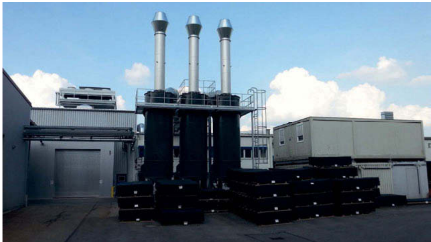
Bild: Aktivkohlemodule als Endstufe zur Gas-/Geruchsabscheidung
