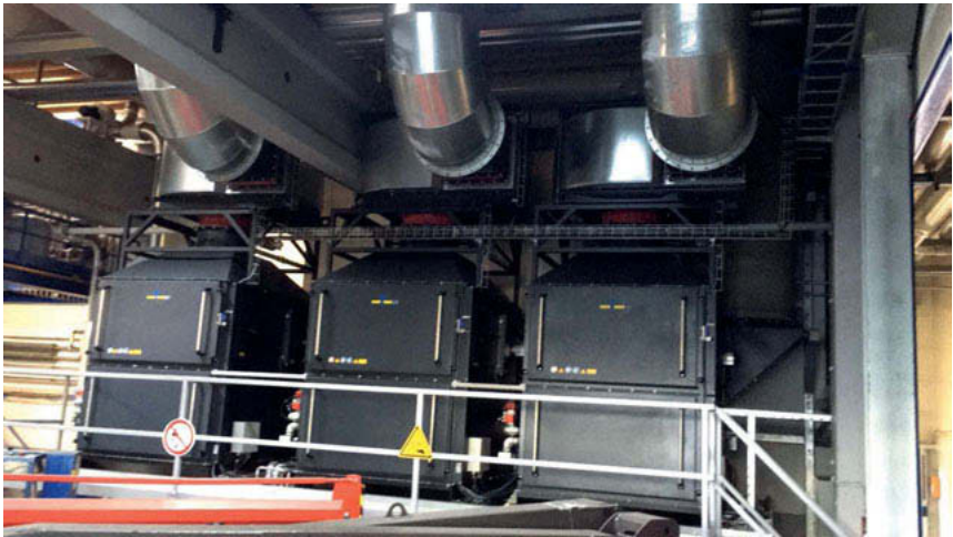
Bild: Elektrofiltermodule mit integrierter Wärmerückgewinnung und CIP Waschsysteem
