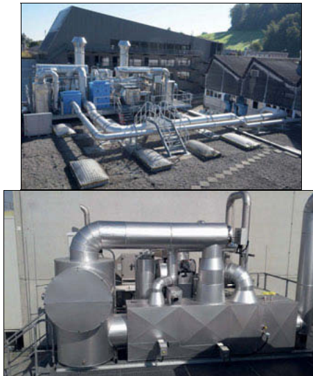
Bild 3: a) Abbau von Alkoholen, Acetaten und Ketonen in der Farbenindustrie, 20.000m 3 /h, Schweiz b) Abbau von Acrylaten, Alkanen und Aromaten in der Klebstoffindustrie, 800m 3 /h, Deutschland
