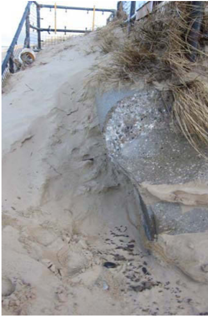
Abbildung 10 Von Sand bedeckte Betonschutzmauer in Sea Palling.
