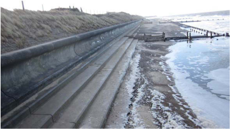
Abbildung 6 Betonküstenschutz aus Walcott. © Foto der Autorin
