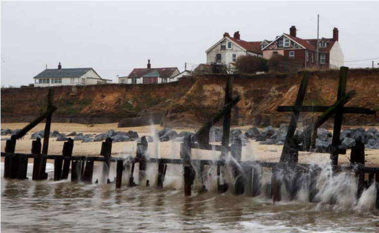
Abbildung 7 Beschädigte hölzerne Wellenbrecher im Jahr 2012.
