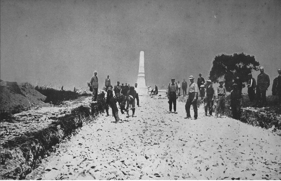
Figure 2: Construction of Edirnekapı Martyrs' Cemetery's 'Monument Road' in 1926 ( Şehitlikleri İmar Cemiyeti Albümü (1938). Istanbul: Devlet Basımevi. Retrieved from İBB Atatürk Kitaplığı Sayısal Arşiv ve e-Kaynaklar, Alb000154, 736.5 736.5 1938 1)
